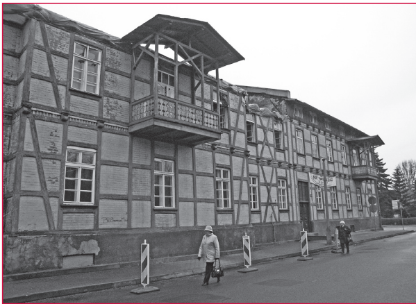
11. Dawny Hotel Müllera w Ciechocinku, widok od strony ul. Kościuszki, stan z 2009 roku. Fot. M. Warchoń, archiwum NID
