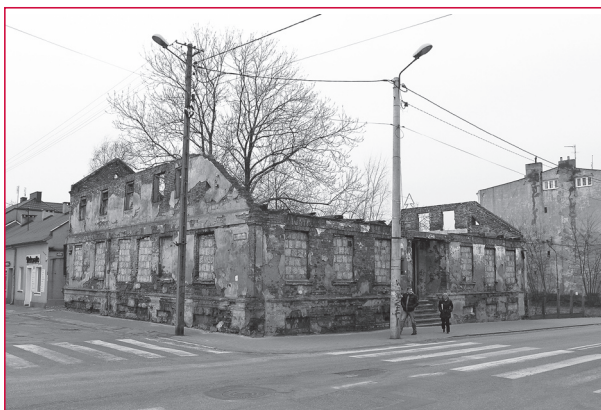
7. Budynek d. plebanii ewangelicko-augsburskiej, Zgierz, ul. Długa 34, stan z 2011 roku. Fot. P. Filipowicz, W. Witkowski, archiwum OT NID w Łodzi
