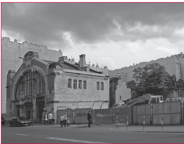
22. Pozostałości po hali targowej na Koszykach, stan z 2014 roku. Fot. J. Brudnicki
