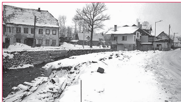
2. Pozostałości po budynku mieszkalnym przy ul. Głównej 26 w Bogatyni, stan z 2010 roku. Fot. G. Grajewski
