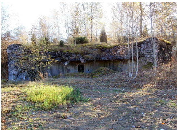
3. Jeden z bunkrów punktu oporu Proszienica, będącego częścią tzw. Linii Mołotowa
