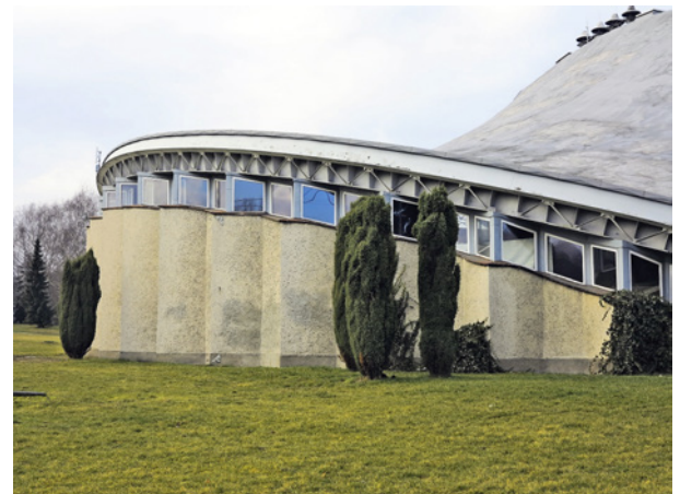
3. Fragment wtórnie obudowanych ścian osłonowych hali i łuku obrzeżnego konstrukcji dachu. Fot. A. Olczyk, 2014
