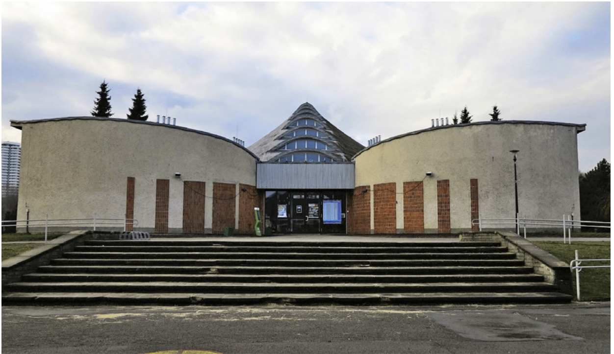
2. Wejście do hali od Promenady gen. Ziętka, ujęte segmentami z lat 80., tzw. rogalami. Fot. A. Olczyk, 2014
