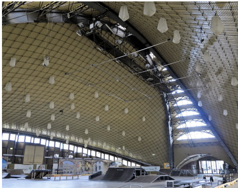
4. Wnętrze hali z widoczną konstrukcją koźła nośnego. Fot. A. Olczyk, 2014
