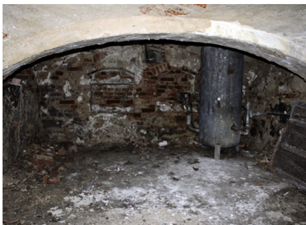
4. Wnętrze piwnicy na moszcz i wino w części południowej domu. Fot. W. Eckert
