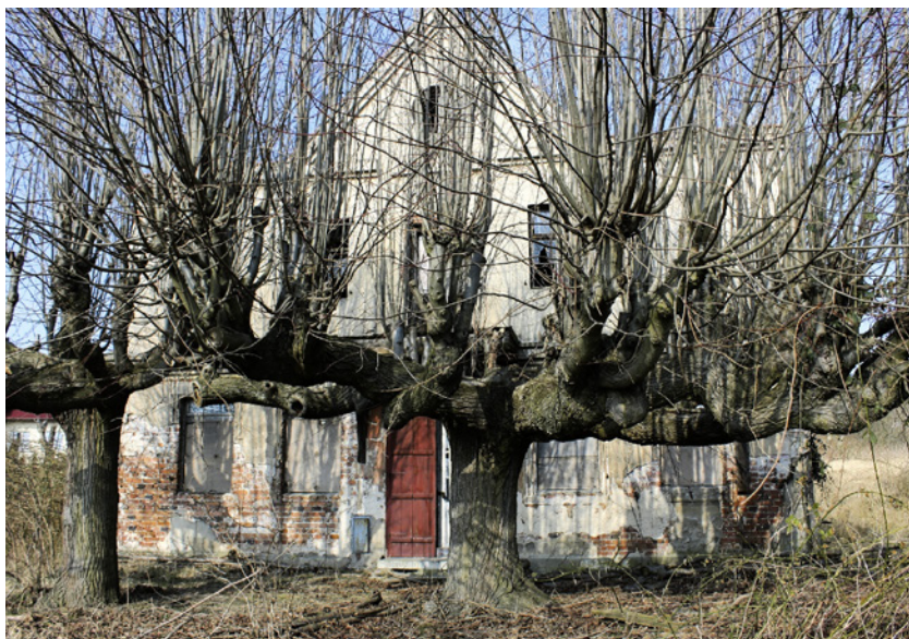
3. Lipy w formie kandelabrow przed elewacją południową budynku. Fot. W. Eckert
