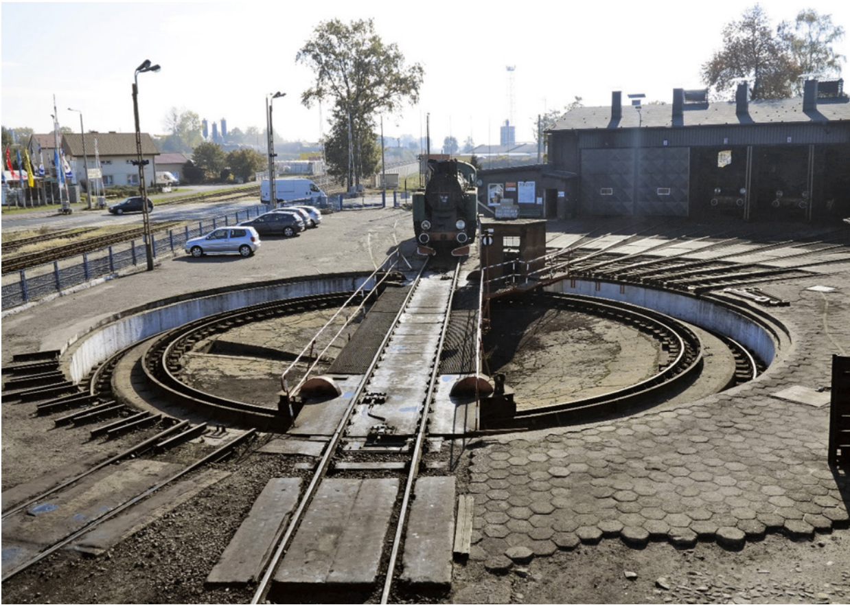
4. Zespół budynków i urządzeń parowozowni w Wolsztynie (stan z 2018 r.). Fot. Robert Kola
