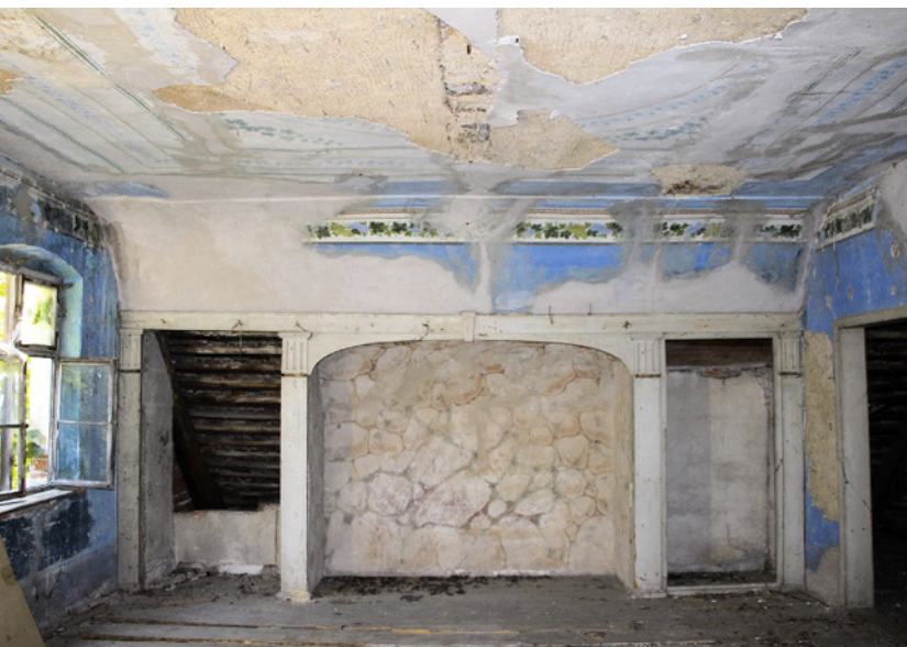
5. Wnętrze pokoju gościnnego na poddaszu w południowej części budynku. Fot. W. Eckert
