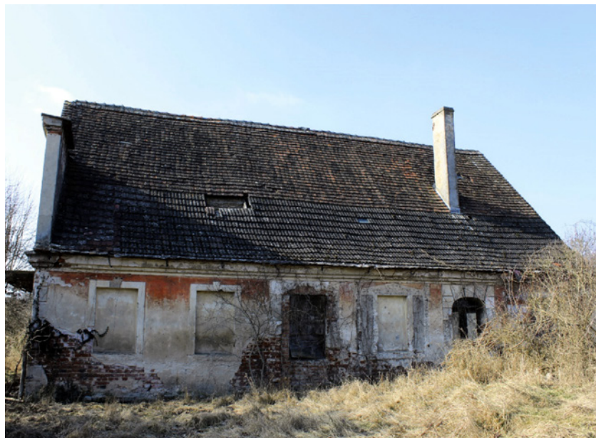
1. Dom nr 23 w Górzykowie, elewacja wschodnia. Fot. W. Eckert
