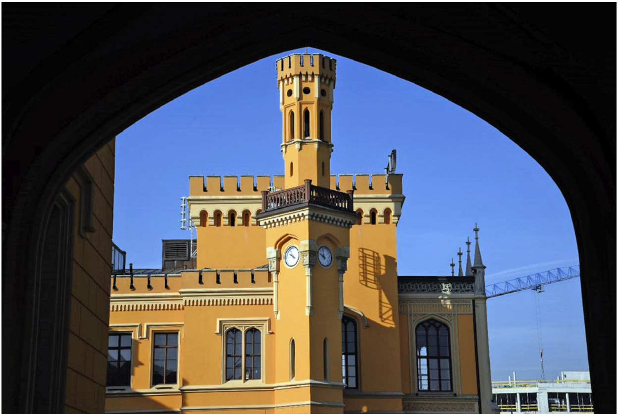
1. Ryzalit środkowy dworca Wrocław Główny po pracach remontowych prowadzonych w latach 2010-2012. Fot. Krzysztof Czartoryski
