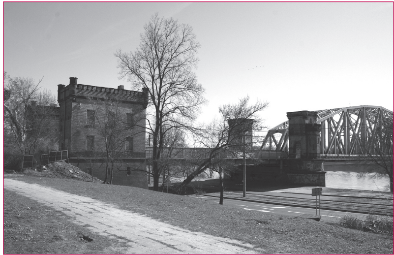
4. Widok od północnego zachodu na budynki na podporach z prawego brzegu Wisły oraz na parę przęseł o konstrukcji blachownicowej z 1984 r.
