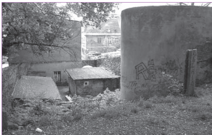
3. Dzierżoniów. Wtórnie zagospodarowane międzymurze.
