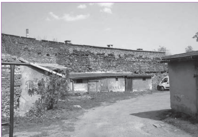
4. Świebodzice. Mury miejskie, odcinek północny o dobrze zachowanych cechach pierwotnej konstrukcji, obudowany.
