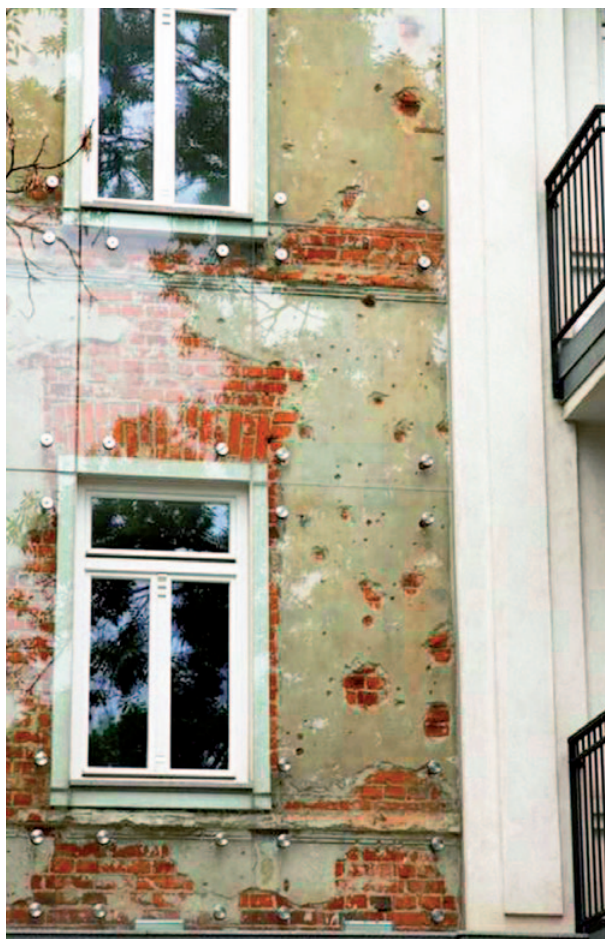
26. Elewacja kamienicy przy ul. Wilczej 72, widoczne zachowane i wypukłone w trakcie konserwacji ślady po pociskach z czasów Powstania Warszawskiego. Fot. archiwum NID
