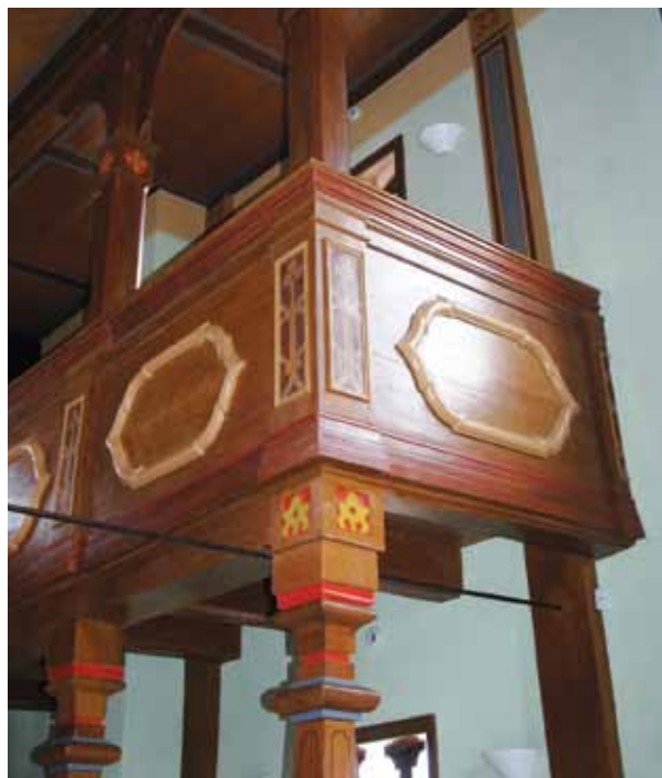
Fot. 4. Twardogóra, kościół poewangelicki, fragment wnętrza z zachowanymi emporami (fot. archiwum NID OT Wrocław).
