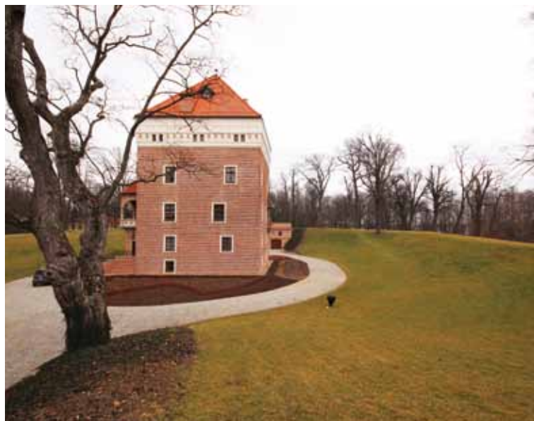
Fot. 7. Rzemień, założenie obronne z wieżą mieszkalną (fot. R. Kwolek).
