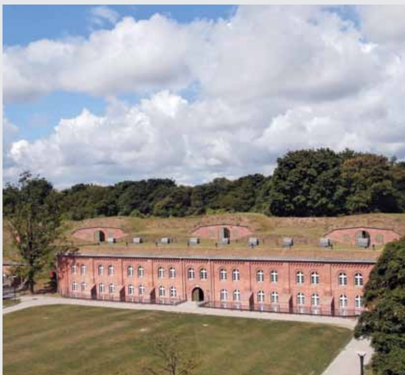
Fot. 1. Gdańsk, Umocnienia Góry Gradowej, (fot. archiwum Centrum Hewelianum).
