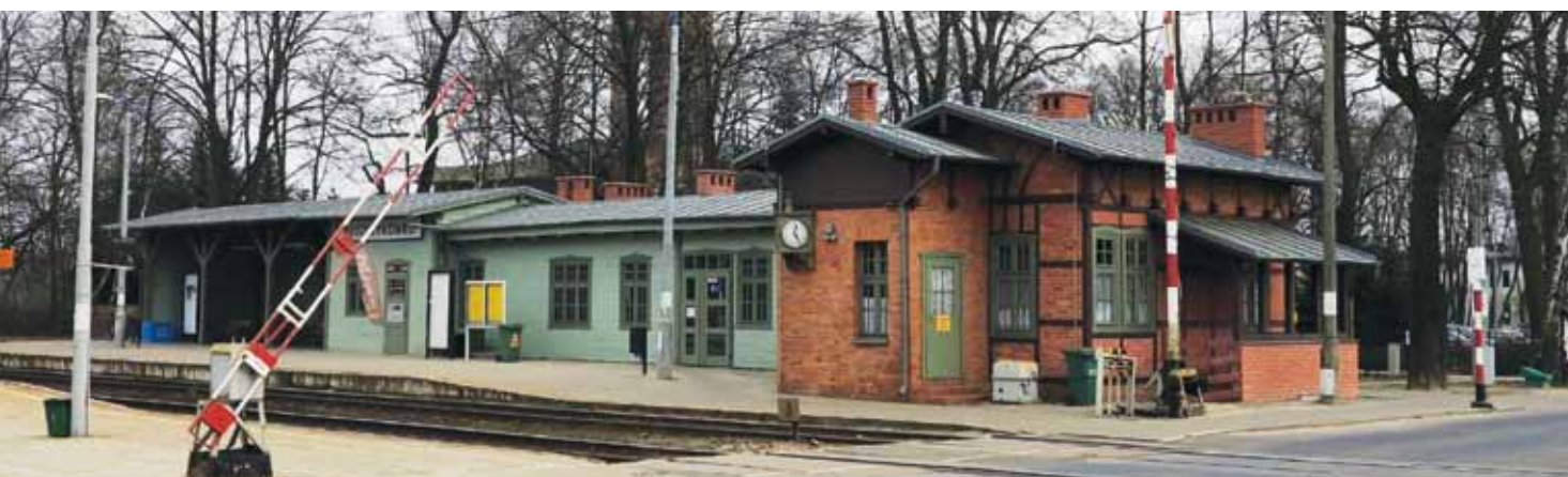
Fot. 8. Puszczykówko, dworzec kolejowy (fot. R. Banach, 2014).
