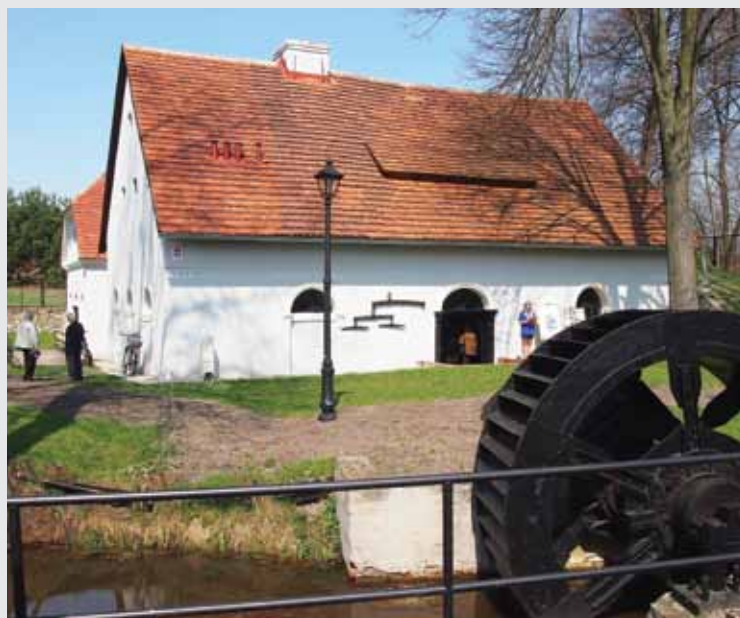
Fot. 3. Mała młotownia w zespole dawnej huty żelaza w Zagwiździe (fot. I. Liżewska, 2014).
