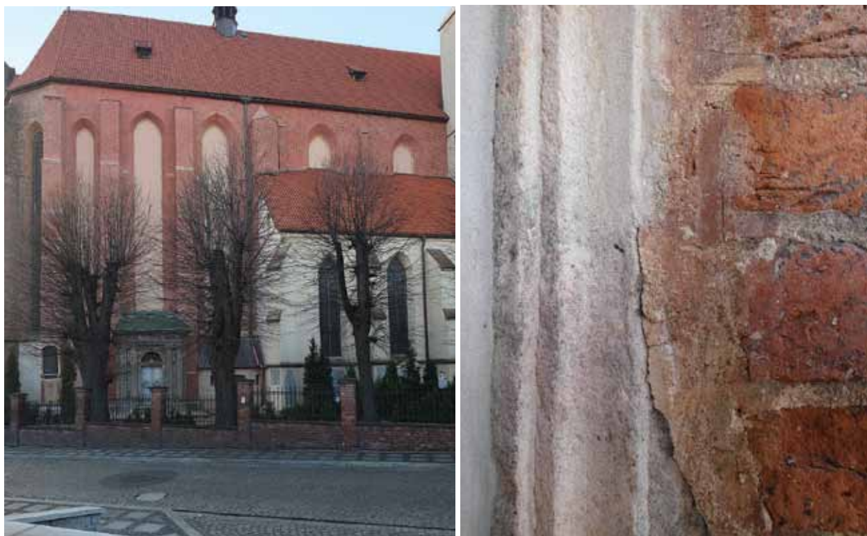
Gotycki kościół pw. św. Jerzego w Dzierżoniowie , połowa XIII wieku, ok. 1338-1389, 1555-1589. Elewacje konserwowane od 2011 roku.
