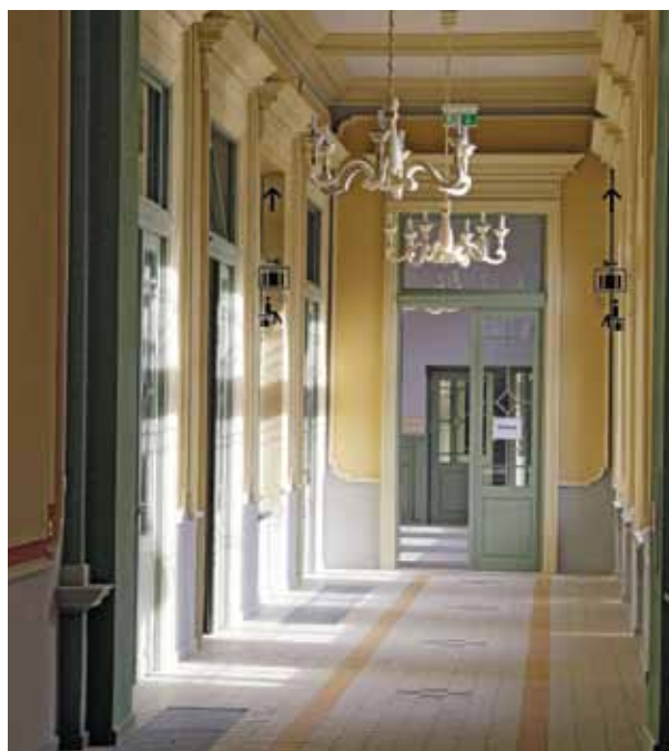
Fot. 12. Przemyśl, wnętrze dworca kolejowego po pracach konserwatorskich (fot. archiwum konkursu „Zabytek Zadbane”).
