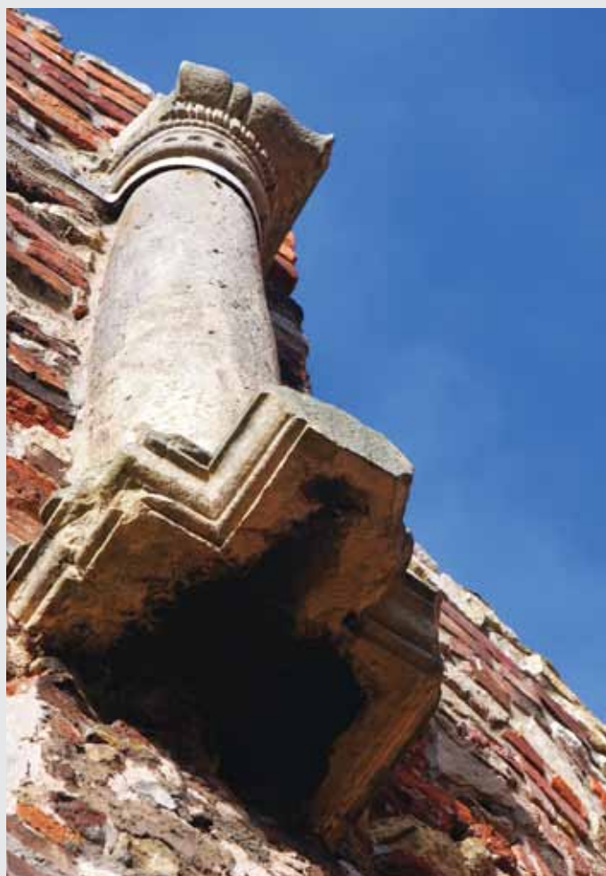
Fot. 3. Zamek w Siewierzu. Fragment ściany od strony dziedzińca z zachowanym elementem konstrukcyjnym w postaci kolumny (fot. I. Liżewska).
