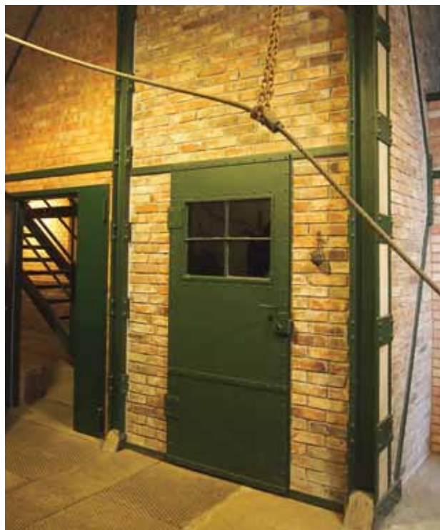
Fot. 13. Zabrze, szyb „Maciej”, wewnątrz nadszybia adaptowanego na cele turystyczne (fot. A. Mucha, 2015).
