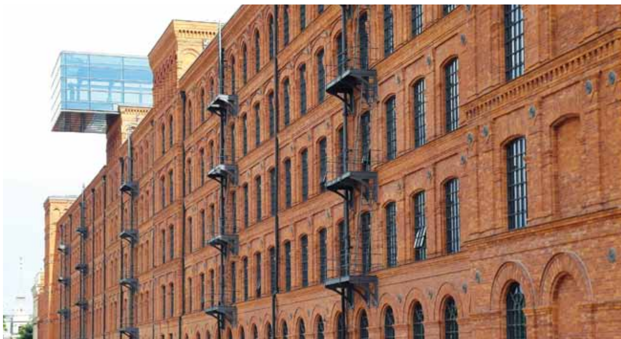
Fot. 16. Łódź, dawna przędzalnia fabryki włókienniczej Izraela Poznańskiego, obecnie hotel Andel's (fot. I. Liżewska, 2013).
