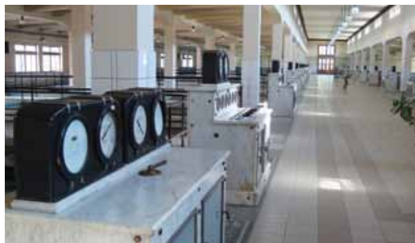
Fot. 7. Warszawa, Zakład Wodociągu Centralnego (Filtry), wnętrze hali filtrów pośpiesznych (fot. R. Kola, 2012).
