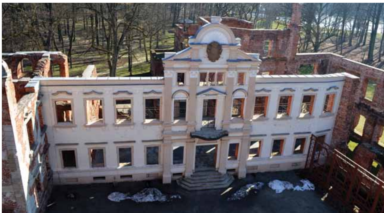
Fot. 11. Żmigród, pozostałości pałacu w stanie trwałej ruiny po konserwacji (fot. P. Roczek).
