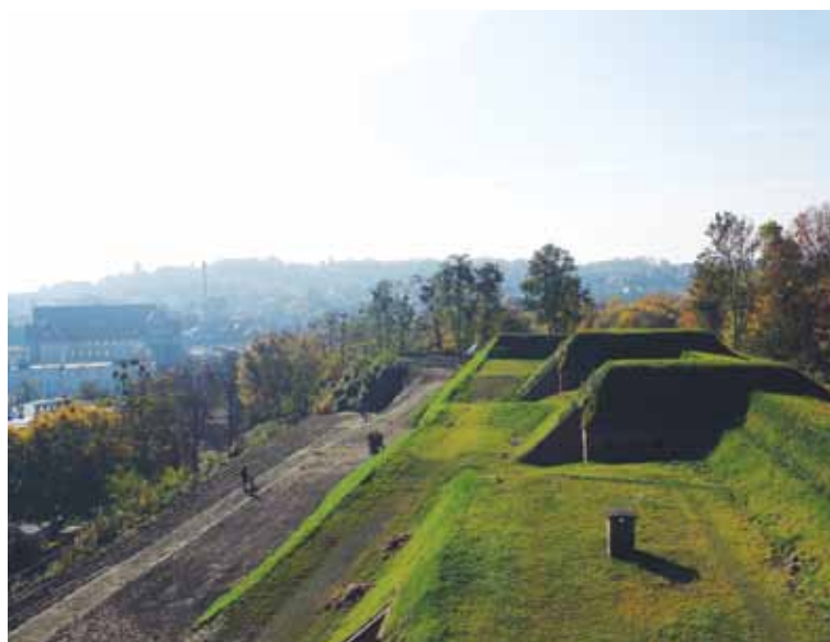
Fot. 6. Gdańsk, umocnienia Góry Gradowej (fot. archiwum Centrum Hewelianum).
