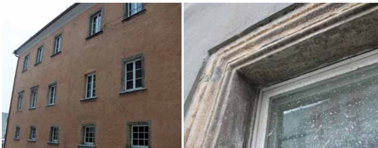
Radków , renesansowy ratusz, 1545, 1609-1628, 1750, 1852, 1882-1885. W trakcie prac prowadzonych w 2010 roku przywrócono pokrycie dachowe z łupka, przeprowadzono remont elewacji. Fot. 10. Elewacja z miękkim tynkiem piaskowo-wapiennym. Fot. 11. Detal – gruby tynk cementowy położony w trakcie prac, następnie usunięty (fot. M. Ptak, 2010).
