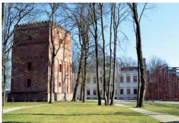
Fot. 1. Żmigród, zrewaloryzowany zespół pałacowo-parkowy z wieżą mieszkalną na pierwszym planie i ruiną pałacu w tle (fot. G. Grajewski, 2013).
