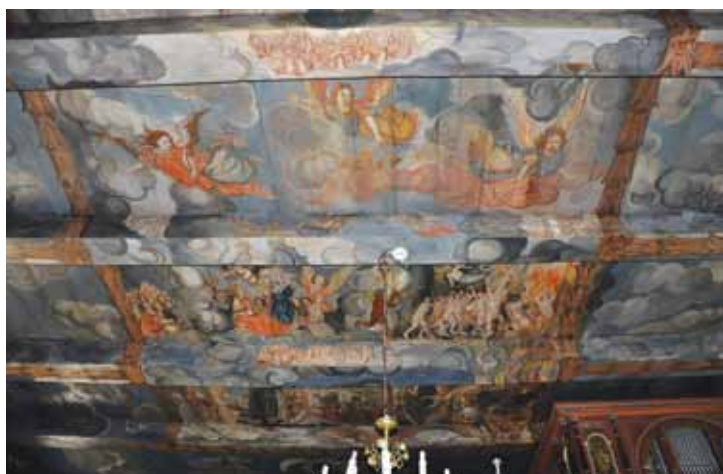
Fot.2. Iwęcino, kościół filialny, polichromia stropu (fot. R. Walkiewicz).
