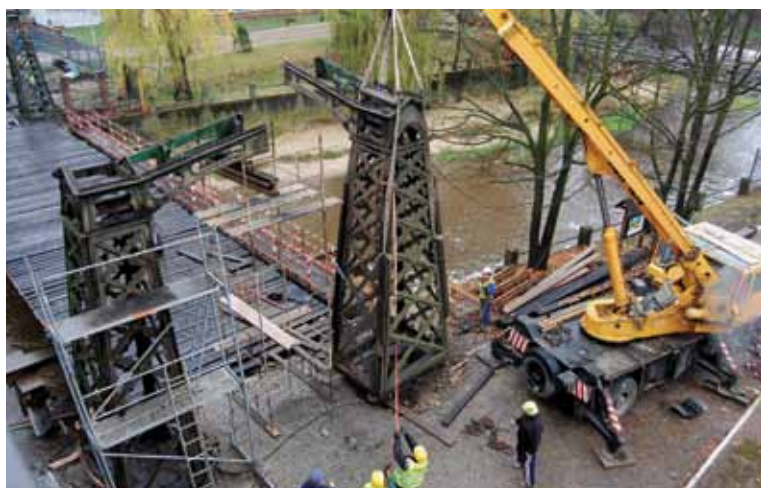
Fot. 16. Ozimek, most w czasie prac remontowych (fot. UMiG Ozimek).
