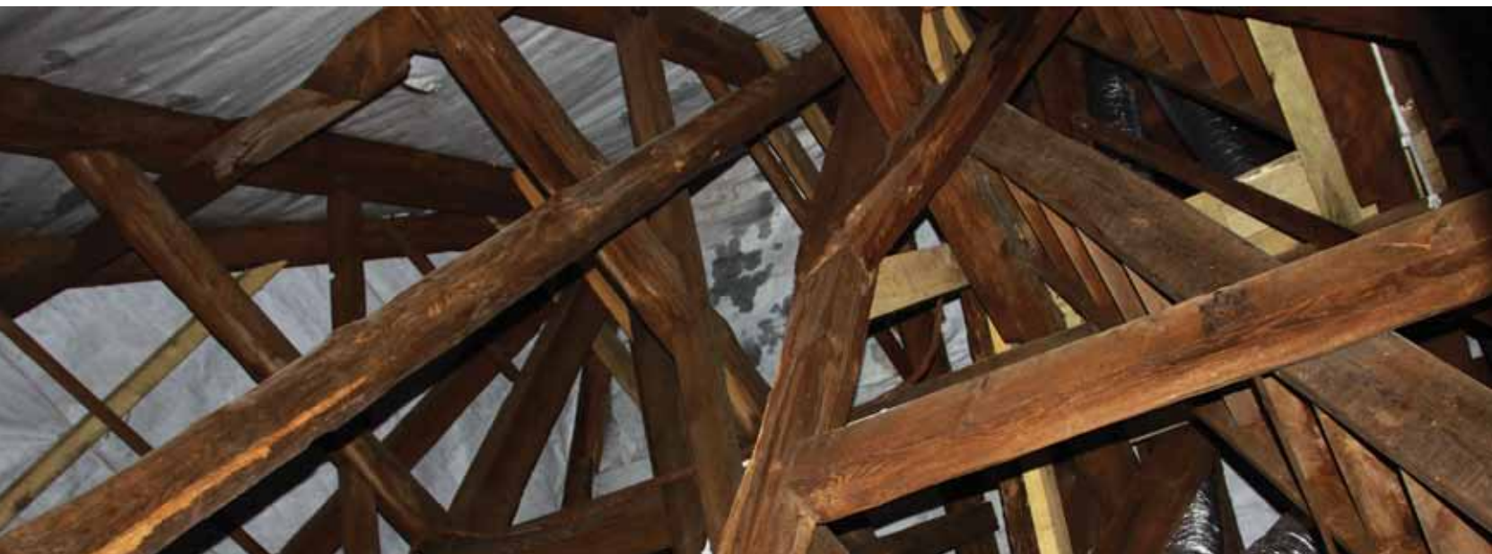
Więźba dachowa w dawnym ratuszu w Rostarzewie, wyróżnionym w kategorii specjalnej architektury i konstrukcji drewnianych | Fot. T. Palacz, NID OT Poznań
