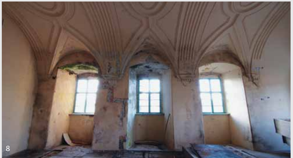
5-11. Wnętrza, a w nich barokowe freski wydobywane w pasowych odkrywkach spod wtórnych tynków i warstw malarskich | Fot. A. Witkowska
