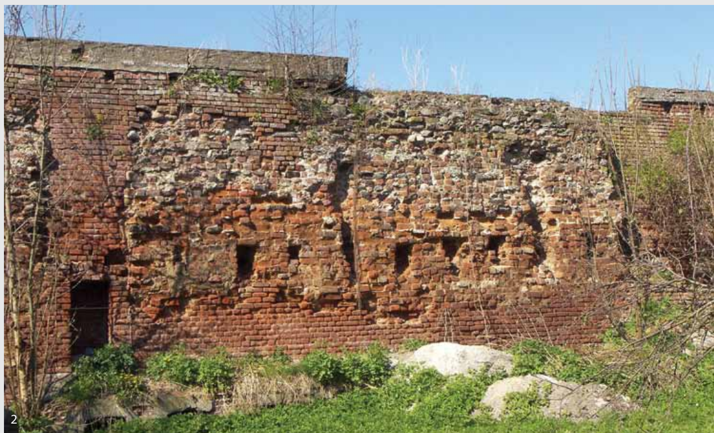
2. Stan lica ceglanego | Archiwum UM w Lubawie
