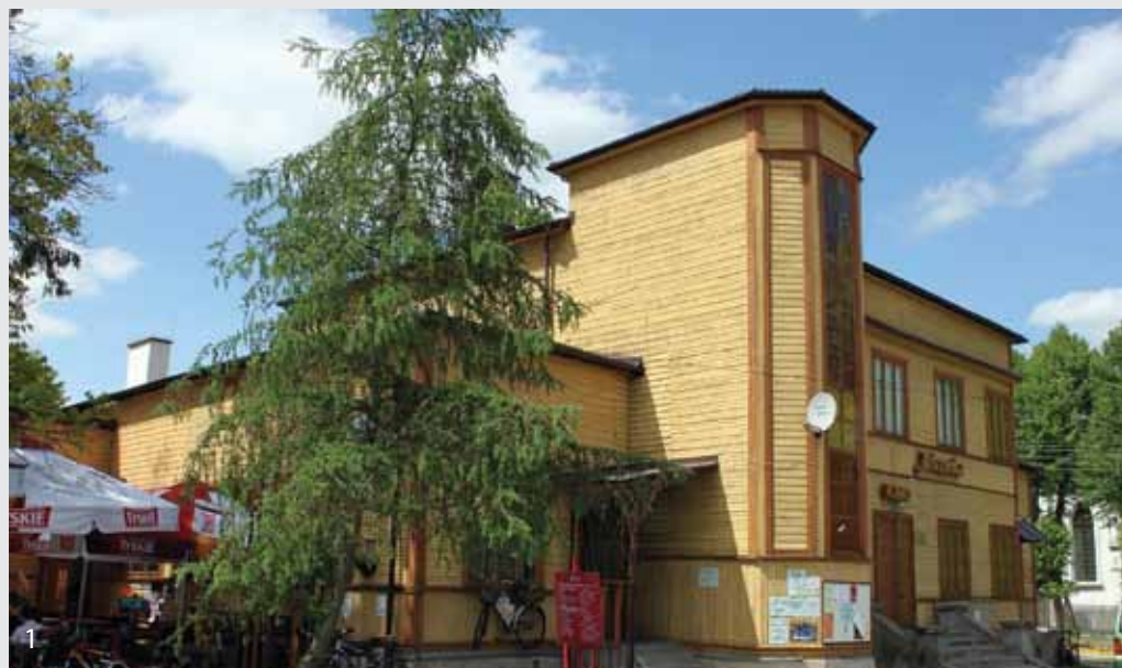
1, 2. Szalowane elewacje zewnętrzne | Archiwum UM w Supraślu 3. Odsłonięta konstrukcja zrębowa na podmurówce | Archiwum UM w Supraślu
