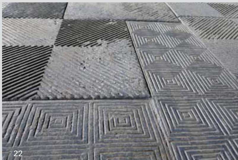
19. Okna maszynowni | Fot. A. Mucha, NID OT Katowice 20. Ściana działowa hal | Fot. A. Mucha, NID OT Katowice 21. Konstrukcja dachu wraz z suwnicami | Fot. A. Mucha, NID OT Katowice 22. Posadzka żeliwna | Fot. A. Mucha, NID OT Katowice
