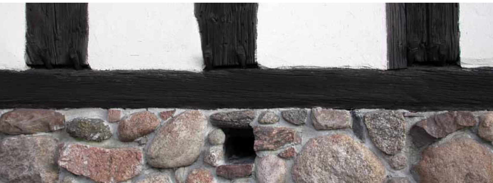
Kościół filialny Świętego Krzyża w Obornikach - wyróżniony w kategorii architektury i budownictwa drewnianego | Fot. T. Łuczak, NID OT Poznań
