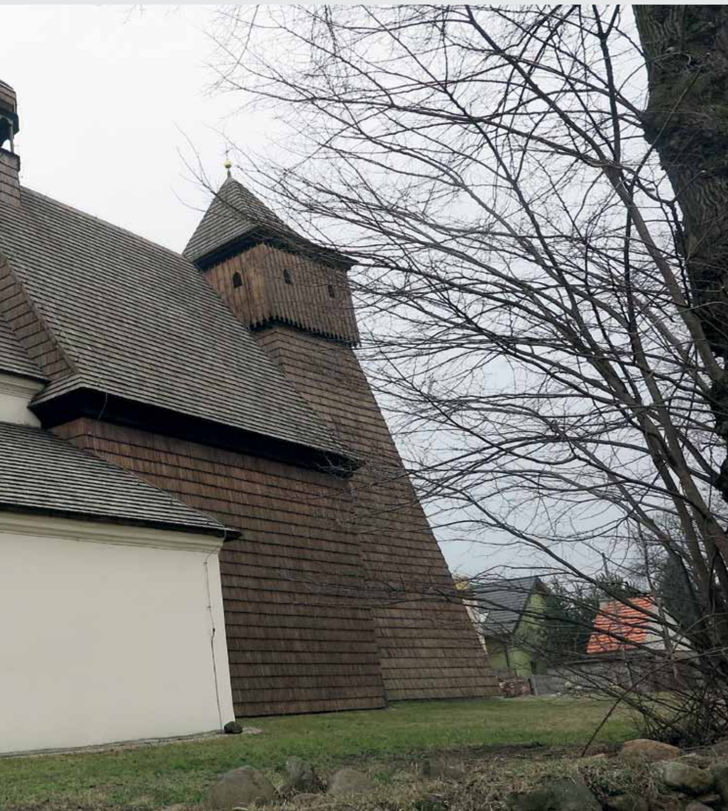
11. Widok ogólny od północnego wschodu | Fot. A. Olczyk, NID OT Katowice
