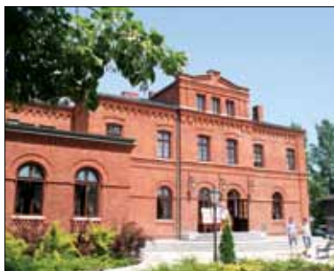
Wyróżnienie Budynek resursy w Żyrardowie, woj. mazowieckie (Miasto Żyrardów) Fot. I. Liżewska, NID OT w Olsztynie
