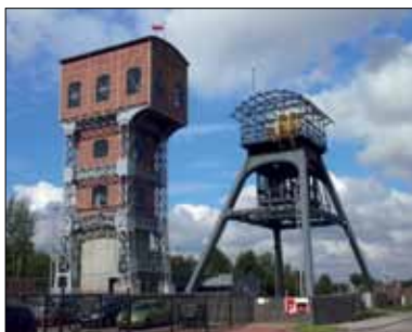
Wyróżnienie Wieże wyciągowe Kopalni Węgla Kamionnego „Polska” w Świętochłowicach, woj. śląskie (Gmina Miejska Świętochłowice) Fot. A. Mucha, NID OT w Katowicach
