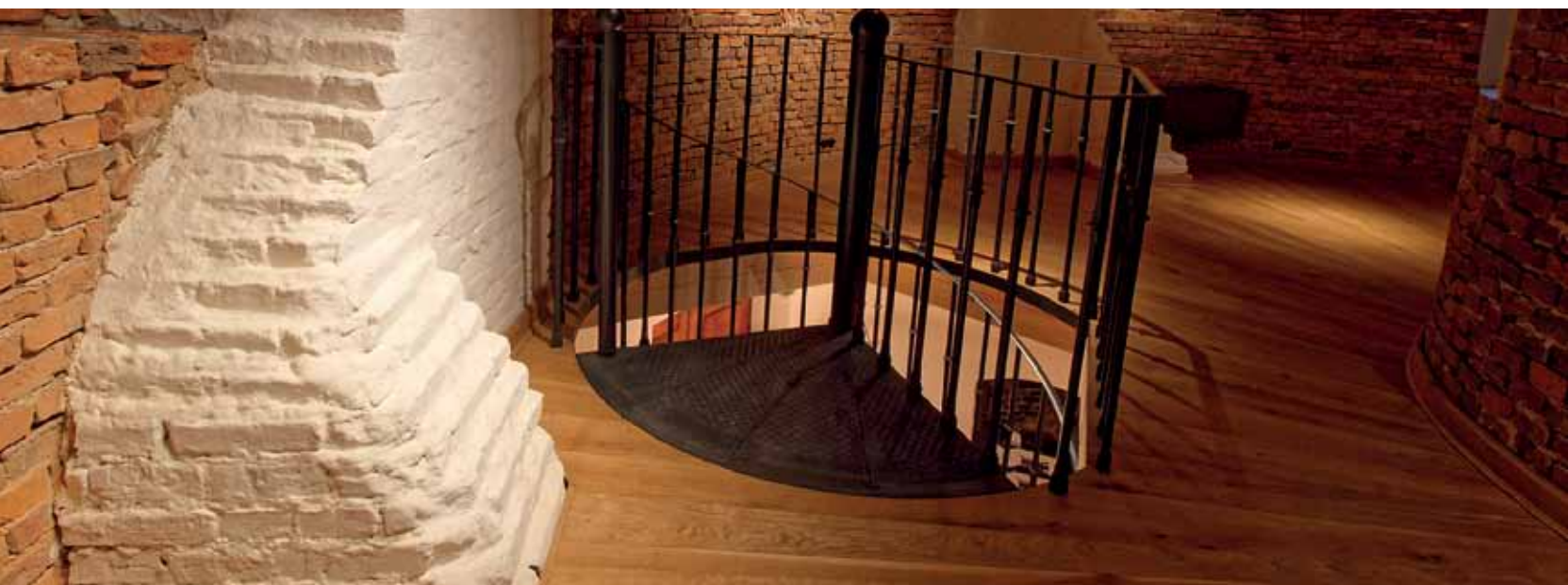
Wodociąg w Łazienkach Królewskich w Warszawie – wyróżnienie w kategorii zabytków techniki | Fot. Archiwum Monument Service Sp. z o.o. Sp. k.
