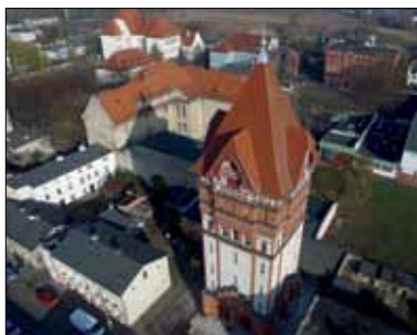
Wyróżnienie Wieża ciśnień w Chełmży, woj. kujawsko-pomorskie (Gmina Miejska Chełmża) Fot. Dragonfly Drones Cezary Stanczewski
