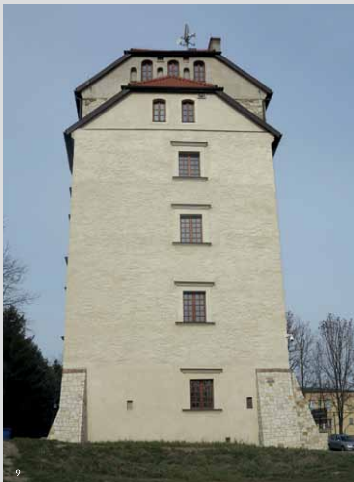
9. Tynki i przypory narożne elewacji południowej | Fot. E. Prusicka, NID PT w Lublinie
