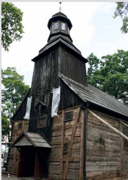
1. Ściany nawy odsłonięte spod szalowania – widok od południowego zachodu | Fot. I. Żerebiło, Wojewódzki Urząd Ochrony Zabytków w Poznaniu Delegatura w Pile
