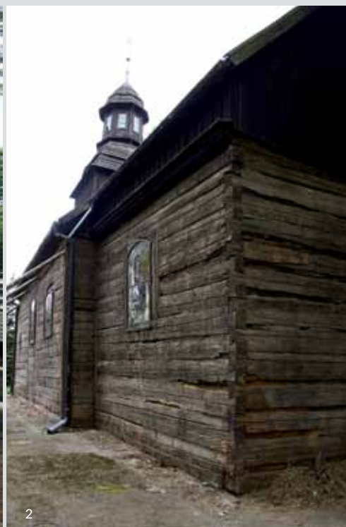
1. Ściany nawy odsłonięte spod szalowania – widok od południowego zachodu | Fot. I. Żerebiło, Wojewódzki Urząd Ochrony Zabytków w Poznaniu Delegatura w Pile
