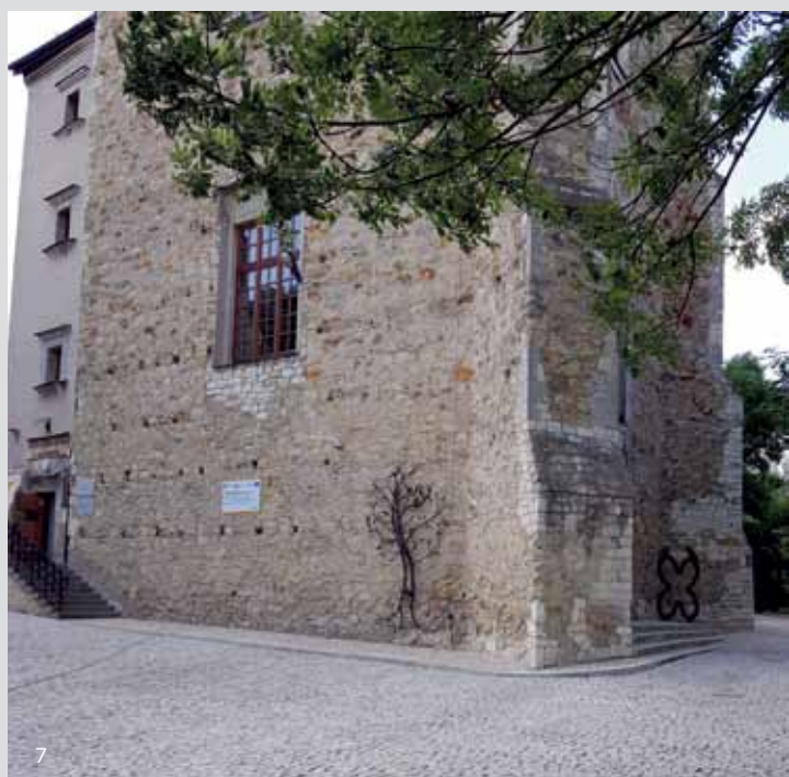
8. Nawierzchnia i fragment muru po stronie wschodniej wieży | Fot. A. Gąska, GOK w Wojciechowie
