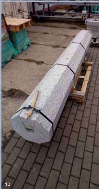
8-9. Wnętrze wieży 10-11. Zbiornik - wnętrze i zewnętrzne czaszy 12. Odtworzony trzon filara elewacji 13. Zbiornik i system przesyłu wody
