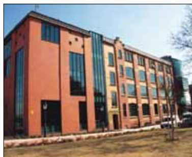
Wyróżnienie Fabryka papieru, później szatnia z łaźnią, obecnie budynek biurowy gazowni w Poznaniu (Oddział Zakład Gazowni- czy w Poznaniu Wielkopol- skiej Spółki Gazownictwa Sp. z o.o.) Fot. R. Banach, NID OT w Poznaniu
