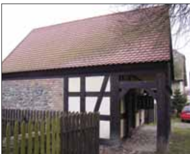
Wyróżnienie Kuznia, obecnie izba regionalna w Dolsku, woj. zachodniopomorskie (Gmina Dębno) Fot. W. Witek, NID PT w Szczecinie
