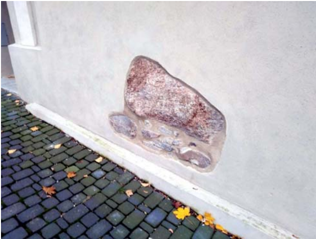
Fot. 4. „Odkrywka — świadek” w elewacji, pokazująca kamienny mur kościoła
