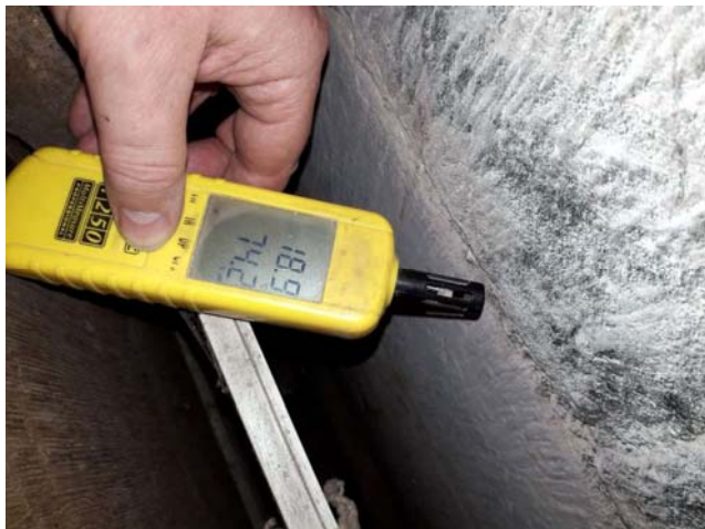
Fot. 2. Uszkodzenia gładzi na ścianie zewnętrznej krużganka. Miejsce 46
