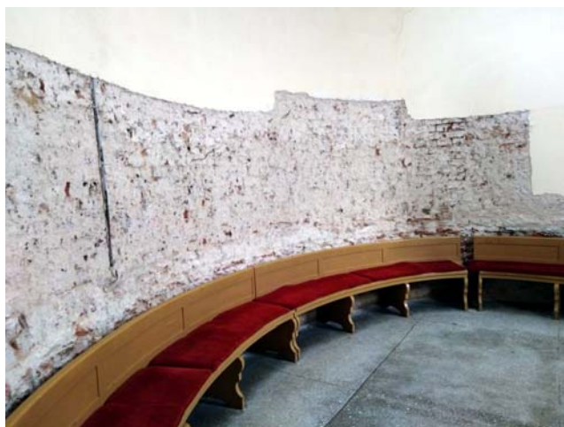
Fot. 5. W nawie od strony południowo-zachodniej tynk usunięty do wysokości 2,30–2,6 m
