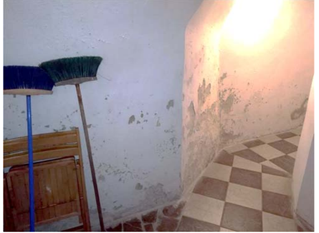
Fot. 3. Uszkodzenia tynku za ołtarzem, w prezbiterium
