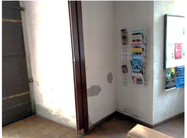
Fot. 5. Uszkodzenia związane z zawilgoceniem i zasoleniem na tynku kruchty (punkt pomiarowy nr 13)
