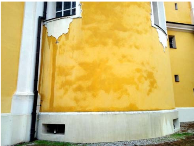
Fot. 4. Tynk elewacji kościoła zwilża woda deszczowa
