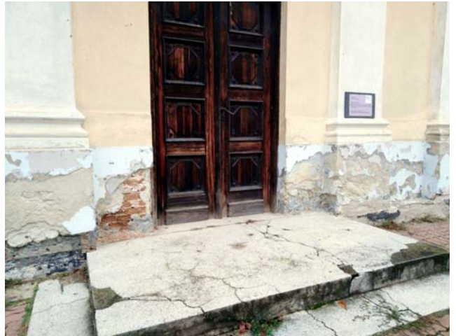
Fot. 7. Stopień przy wejściu głównym
