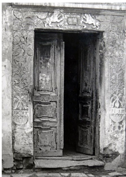
29. Ul. Grodzka 3, portal kamienny oraz nieistniejące drzwi ramowo-płycinowe. Fot. K. Gottfried, MJ.F. Nr dz. III-C, sygn. 622
