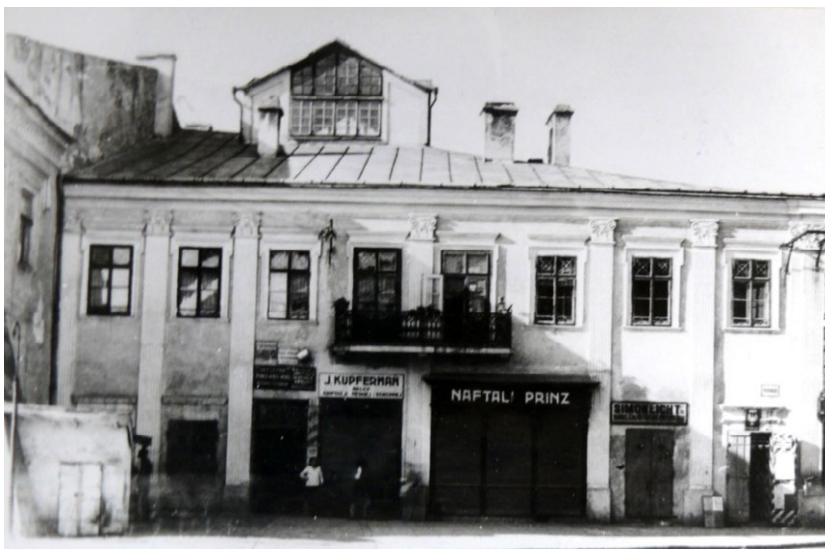
55. Kamienica, Rynek 11, witryny sklepowe i drzwi zamykane żaluzjami oraz drzwi podwójne, od zewnątrz deskowo-szpungowe, objane blachami, 1979 r. Fot. H. Górecki, MJ.F. Nr dz. III-B, sygn. 4945
