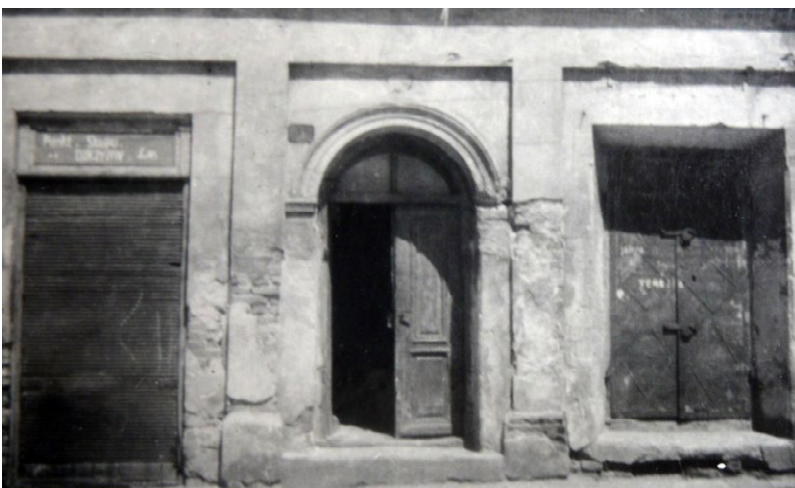
53. Rynek 16, na osi drzwi główne do kamienicy, ramowo-płycinowe z nadświetlem, pełne. Od lewej zamknięte żaluzjami, po prawej objane blachami, 1955 r. Fot. K. Gottfried, M.J.F. Nr dz. III-B, sygn. 87557
