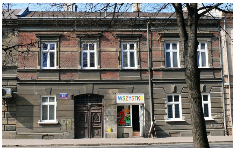
121. Kamienica przy ul. Kraszewskiego 13, stan z 2011 r., historyczna stolarka i nowa witryna z PCV. Fot. J. Stęchły
