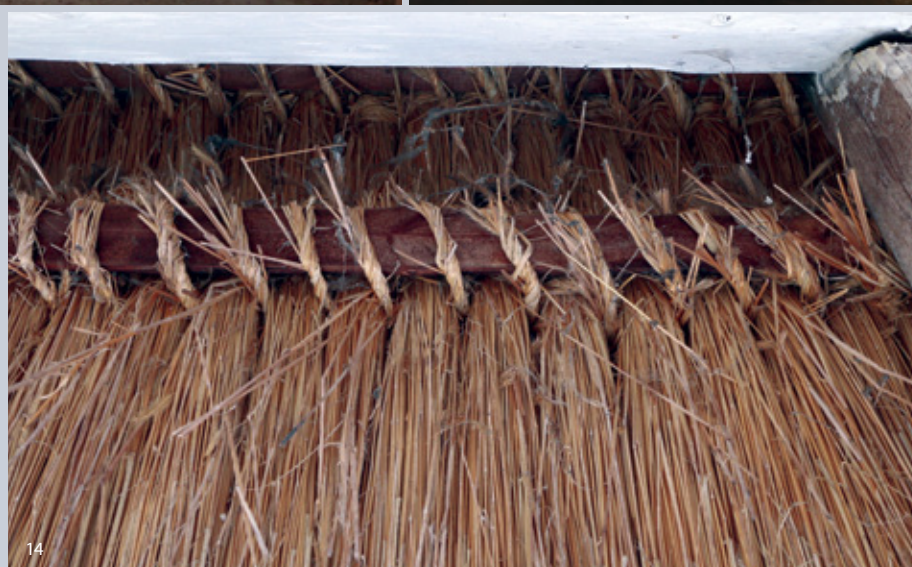
10. Wnętrze komory 11. Kuchnia 12. Wnętrze izby mieszkalnej 13. Więźba i pokrycie dachu 14. Kliczki wiązane zgodnie z lokalną tradycją Fot. 10–14 | Barbara Potera, NID OT w Rzeszowie
