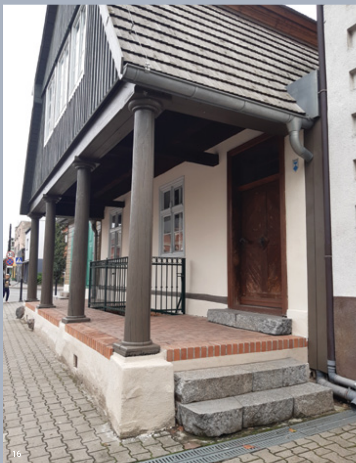
17. Elewacja frontowa przybudówki, wejście do kawiarni | Fot. Daniel Mikulski, NID OT w Poznaniu
