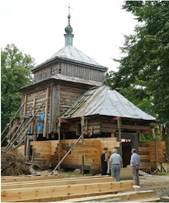
107, 108. Leżachów, pow. przeworski. Cerkiew św. Nikity, podczas prowadzenia prac konserwatorskich. Po lewej widok od pn., widoczna niemal zupełna wymiana dolnych partii obiektu na nowe. Fot. J. Kurek, 2017. Zbiory autora. Po prawej widok na portal pn.-wsch. uzupełniany nowym drewnem montowanym na śruby. Fot. A. Żygadło, 2017. Zbiory autora.
