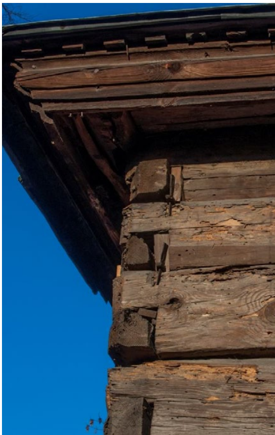
113,114. Święte, pow. jarosławski. Dzwonnica cerkiewna z ok. 1806 r. Podczas prac remontowych wymieniono niemalże całą oryginalną konstrukcję. Wymieniono także ceglana podmurówkę na betonową licowaną piaskowcem. Wykonano betonowe schody licowane kamieniem. Fot. nn. Wg: http://www.zbkarkady.pl/ , [20.06.2022].
