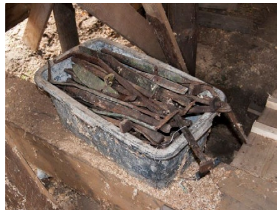
115,116. Leżachów, pow. przeworski. Cerkiew św. Nikity, podczas prowadzenia prac konserwatorskich. Po lewej: widok pd.-zach. węglowania babińca po usunięciu deskowania. Przy zamkach widoczne są ankry. W 1796 r. do Leżachowa przeniesiono starą cerkiew zakupioną w Czerniawce. Jej powtórny montaż kierował cieśla Szymon Dziobek z Borchowa, który wmontował kotwy w stare zamki zrębu cerkwi, aby te w przyszłości się nie rozsuwały. W latach 2015-2021 cały XVIII-wieczny system ankrów został usunięty przez wykonawcę prac. Fot. A. Żygadło, 2015. U góry: skrzynia z zdemontowanymi kotwami. Fot. A. Żygadło, 2017. Zbiory autora.
