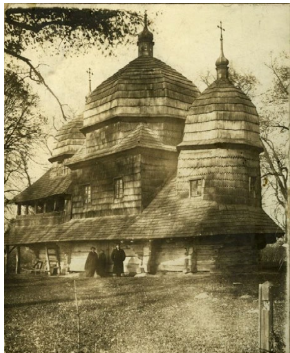
129. Widok od pd.-zach. przed przebudową zach. części świątyni. Widoczny brak słupów przed pd. portalem. Uwagę zwraca forma opierzenia: ozdobnie wycinane końcówki gontów ułożonych we wzorzyste moduły. Fot. M. Osiński, ok. 1919. Fototeka IHS UJ, sygn. P 000818.
