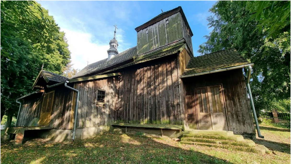
124, 125. Krzczowice, pow. przeworski. Cerkiew Św. Mikołaja. U góry: widok od pn.-zach. Widoczne dobudówki z lat 80. XX w., z ówczesną stolarką i betonowymi schodami przed wejściem. U dołu: widok od pn.-wsch. Widoczna dobudówka dostawiona do elewacji pn. zaopatrzona w betonowe schody. Stan zachowania kruchty bardzo zły. Portal wsch. kruchty ma rozbite skrzydło, uszczelniane sklejką i blachą. Fot. A. Żygadło, 2022. Zbiory autora.
