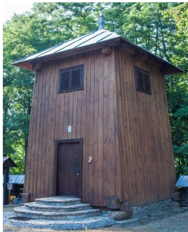
91,92. Młyny, pow. lubaczowski. Dzwonnica przy cerkwi Opieki Matki Bożej. Widok od pd.-wsch. Po lewej: przed rozpoczęciem prac modernizacyjnych. Fot. J. Szandomirski, 1966, MZŁ DSC, teka obiektu, fot. nr 7. Po prawej po pracach remontowych w 2002. Widoczne betonowe pecki, na których wtórnie osadzono granitowe głązy. Przestrzenie między głązami wypełniono podmurówką. Przed drzwiami betonowe schody olicowane kamieniem. Zmianie uległa również forma deskiowania, otwory głosowe oraz portale. Fot. A. Żygadło, 2022.
