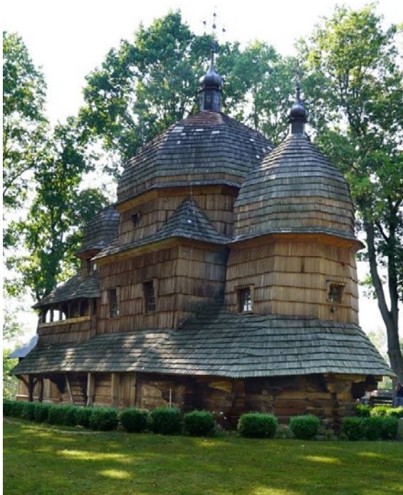
128. Widok od pd.-wsch. Widoczne ahistoryczne słupy wspierające opasanie przed pd. portalem. Uwagę zwraca również wieniec żywotników wokół cerkwi. Fot. J. Kurek, 2017. Zbiory autora.
