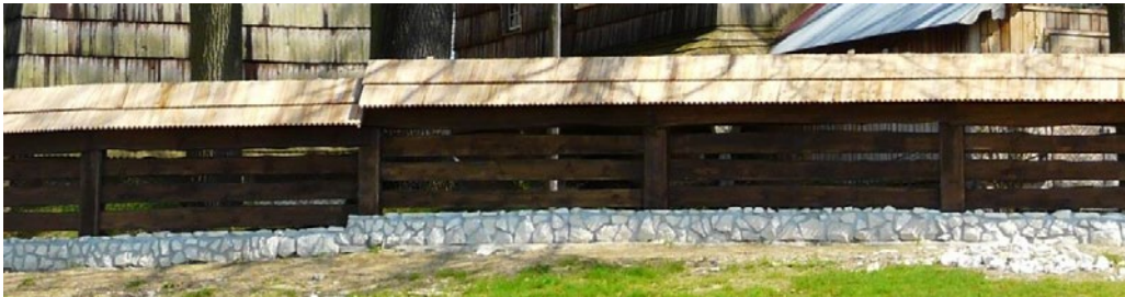
135. Chotyń, pow. jarosławski. Ogrodzenie przy cerkwi Narodzenia Matki Bożej. Widok od pn.-zach. Ogrodzenie to stanowi niezbyt udaną stylizację na parkan, głównie ze względu na dominującą betonową podstawę licowaną wapniem. Fot. D. Nowak, 2011. Zbiory autora.
