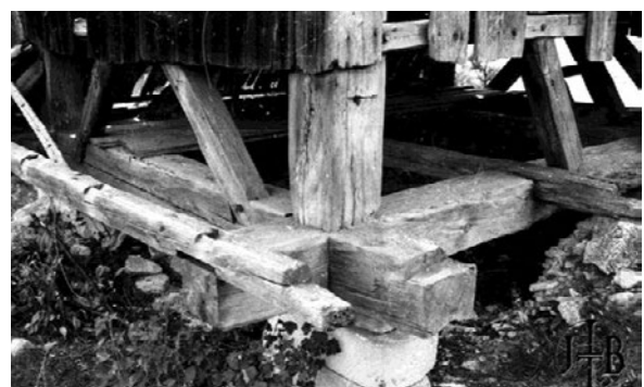
34. Łówcza, pow. lubaczowski. Dzwonnica cerkiewna, widok narożnika posadowienia od pd.-wsch. Widoczna konstrukcja fartucha osłaniającego niegdyś posadowienie. Na ostatkach podwalin wspiera się płatew, na której opierały się krokwie, a na nichłaty i połącz z gontu. Fot. J. Tur, B. Tondos, lata 60. XX w., ZAJTiBT, sygn. TT_7_62_A_006.
