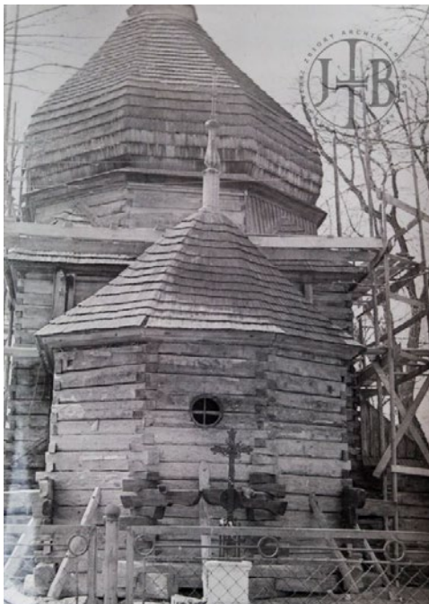
105. Poździacz (ob. Leszno), pow. przemyski. Cerkwi św. Bazylego Wielkiego, widok od wsch. Widoczne w całym obiekcie nowe historyczne węglowania bez resztek. Stan w trakcie remontu. Fot. B. Tondos. Nowak, 1971. ZAJTIBT, sygn. bn.
