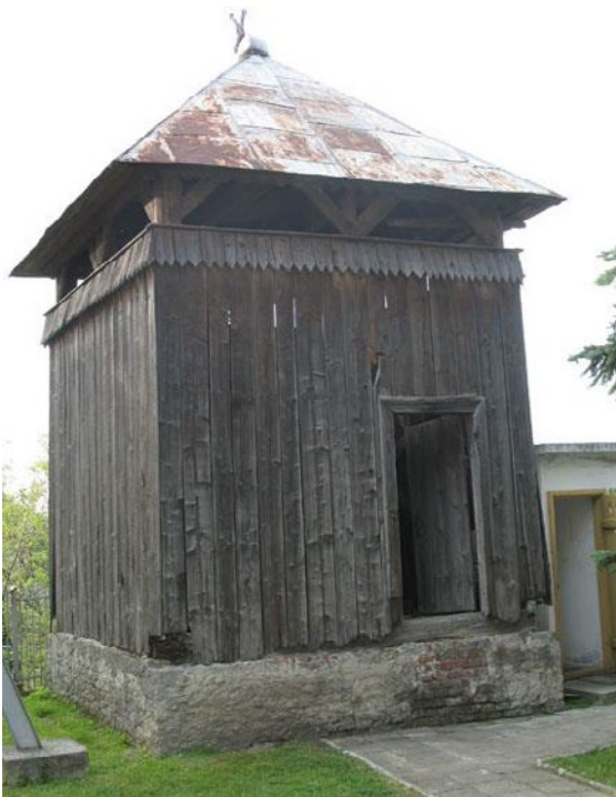
113,114. Święte, pow. jarosławski. Dzwonnica cerkiewna z ok. 1806 r. Podczas prac remontowych wymieniono niemalże całą oryginalną konstrukcję. Wymieniono także ceglana podmurówkę na betonową licowaną piaskowcem. Wykonano betonowe schody licowane kamieniem. Fot. nn. Wg: http://www.zbkarkady.pl/ , [20.06.2022].
