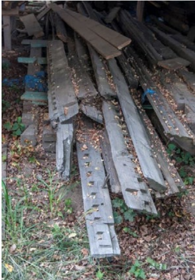
68. Po lewej: Leżachów, pow. przeworski. Materiał konstrukcyjny cerkwi, zdemontowany podczas konserwacji, przeznaczony do rekonstrukcji, zabezpieczony niedbale, wystający poza wiatę, zaśmiecony, narażony na podsiąkanie kapilarne i wody opadowe. Widoczne niszczące ozdobne listwy gzymsów. Fot. A. Żygadło, 2022. Zbiory autora.
