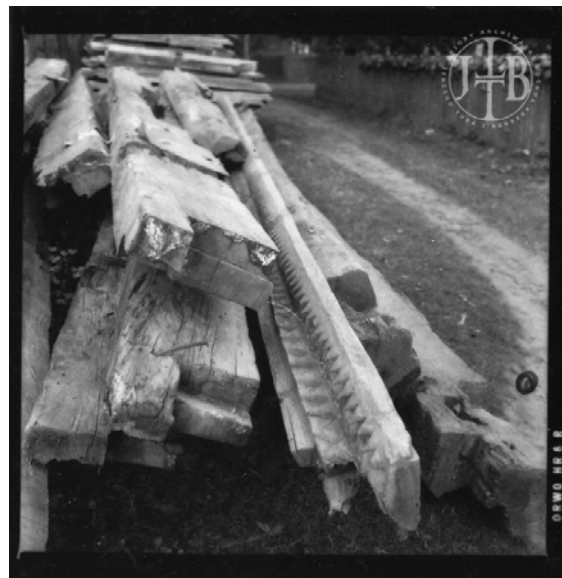
42,43. Bobrowka, pow. jarosławski. Cerkiew Przemienienia Pańskiego, widok w trakcie rozbiórki, prowadzonej przez łańcuską parafię w Ryszkowej Woli, w opinii Ryszarda Brykowskiego: „przy kompletnej obojętności, jeśli nie przyzwoleniu Wojewódzkiego Konserwatora Zabytków, Marka Gosztyły”. Po lewej widok od pd.-wsch. Po prawej materiał porozbiórkowy z widocznym ozdobnym gzymsem podokapowym o wysokiej wartości zabytkowej, zniszczonym wraz z pozostałymi elementami konstrukcyjnymi cerkwi. Fot. J. Tur, 1988. ZAJTiBT, sygn: po lewej TT_7_49_B_006; po prawej: bn.
