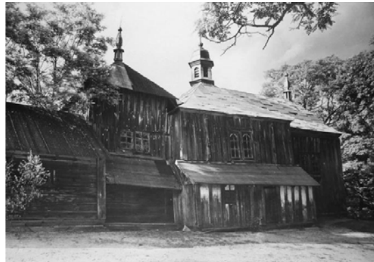
50. Widok od pd. po przebudowie w latach 30. XX w. Fot. J. Szandomirski, 1966, Muzeum Zamek w Łańcucie, DSC, teka obiektu, fot. nr 3.
