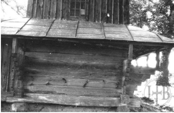
93. Młyny, pow. lubaczowski. Cerkiew Opieki Matki Bożej. Widok od wsch. widoczne posadowienie z gładzów. Fot. J. Tur. 1961. ZAJTiBT, sygn. bn.
