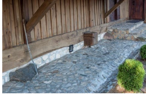
94. Młyny, pow. lubaczowski. Cerkiew Opieki Matki Bożej. Widok posadowienia od pd.-zach. Widoczny kamienno-betonowy bruk, betonowe schody licowane kamieniem, ciągła podmurówka między oryginalnymi gładzami. Fot. A. Żygadło.
