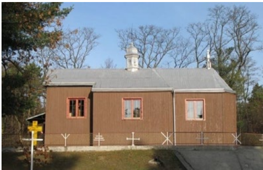
51. Widok od pd. po generalnej przebudowie obiektu i rozbiórce bramni i dzwonnicy w 1971 r. Fot. W. Pysz, 2006. Wg: www.cerkiewne.tematy.net , [20.06.2022].
