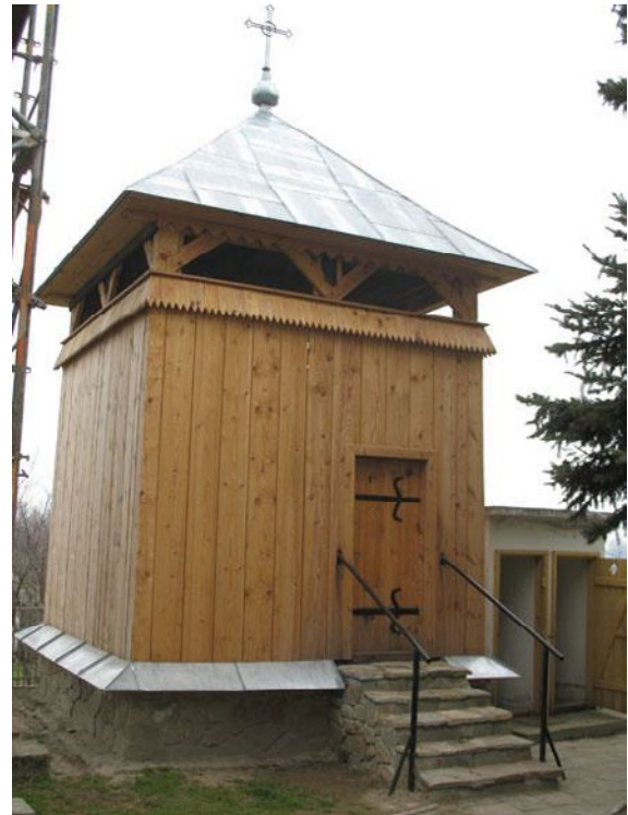
113,114. Święte, pow. jarosławski. Dzwonnica cerkiewna z ok. 1806 r. Podczas prac remontowych wymieniono niemalże całą oryginalną konstrukcję. Wymieniono także ceglana podmurówkę na betonową licowaną piaskowcem. Wykonano betonowe schody licowane kamieniem. Fot. nn. Wg: http://www.zbkarkady.pl/ , [20.06.2022].
