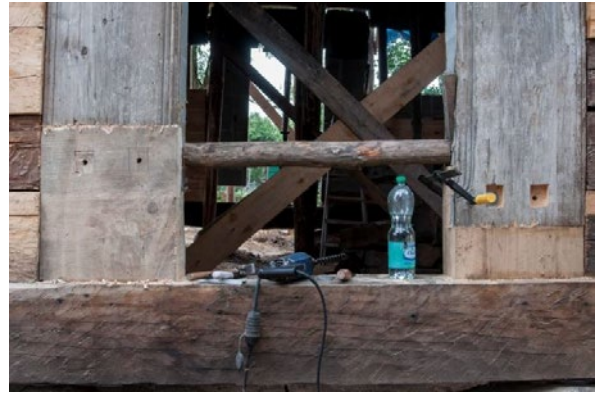
107, 108. Leżachów, pow. przeworski. Cerkiew św. Nikity, podczas prowadzenia prac konserwatorskich. Po lewej widok od pn., widoczna niemal zupełna wymiana dolnych partii obiektu na nowe. Fot. J. Kurek, 2017. Zbiory autora. Po prawej widok na portal pn.-wsch. uzupełniany nowym drewnem montowanym na śruby. Fot. A. Żygadło, 2017. Zbiory autora.
