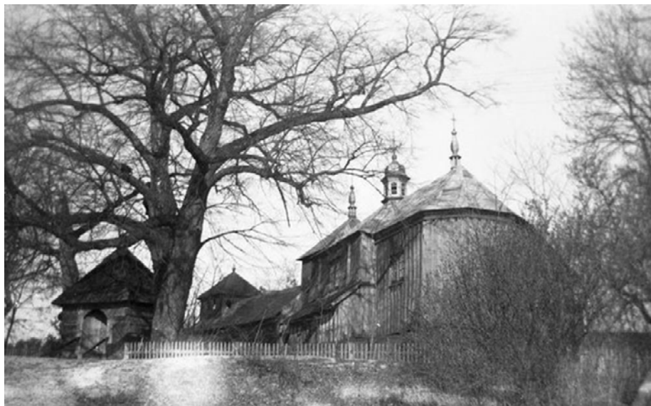
53. Niezwykle malowniczy widok zespołu cerkiewnego od pd.-wsch., widoczna: cerkiew, dzwonnica, bramka wejściowa, ogrodzenie i starodrzew. Historia zespołu cerkiewnego w Mołodyczu to metodyczny proces niszczenia jego wartości architektonicznej, zabytkowej i estetycznej. Jako taki stanowi ważny przykład stosowania metody „małych kroków” w niszczeniu zabytków i ich otoczenia. Fot. F. Hubacz, 1969. Wg: Strażnik kultury Franciszek Hubacz , red. Ł. Zagrobelny, Jarosław 2018, s. 94.
