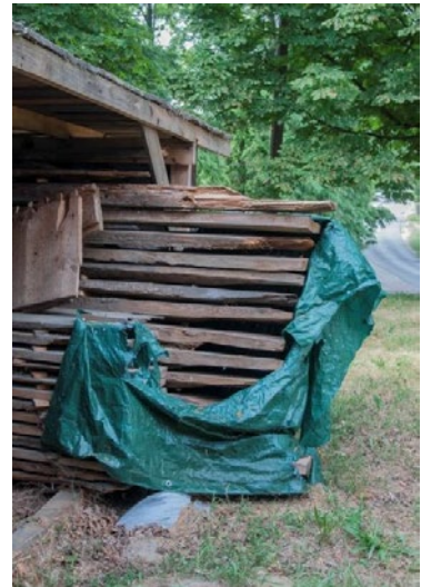
68. Po lewej: Leżachów, pow. przeworski. Materiał konstrukcyjny cerkwi, zdemontowany podczas konserwacji, przeznaczony do rekonstrukcji, zabezpieczony niedbale, wystający poza wiatę, zaśmiecony, narażony na podsiąkanie kapilarne i wody opadowe. Widoczne niszczące ozdobne listwy gzymsów. Fot. A. Żygadło, 2022. Zbiory autora.
