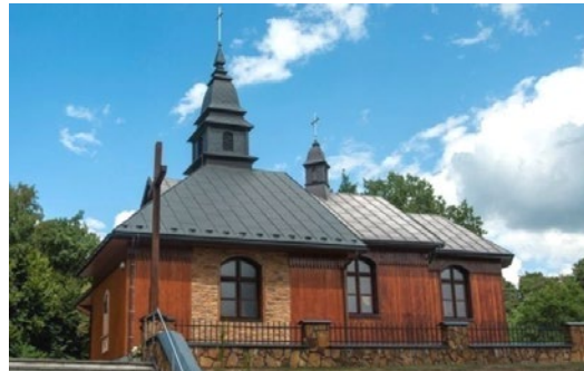
52. Widok od pd. po niedawnej rozbudowie o kaplicę przy pd. ścianie babińca. Fot. A. Żygadło, 2022. Zbiory autora.
