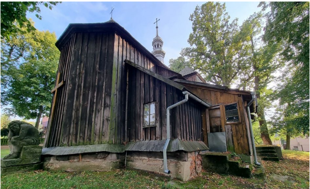
124, 125. Krzczowice, pow. przeworski. Cerkiew Św. Mikołaja. U góry: widok od pn.-zach. Widoczne dobudówki z lat 80. XX w., z ówczesną stolarką i betonowymi schodami przed wejściem. U dołu: widok od pn.-wsch. Widoczna dobudówka dostawiona do elewacji pn. zaopatrzona w betonowe schody. Stan zachowania kruchty bardzo zły. Portal wsch. kruchty ma rozbite skrzydło, uszczelniane sklejką i blachą. Fot. A. Żygadło, 2022. Zbiory autora.
