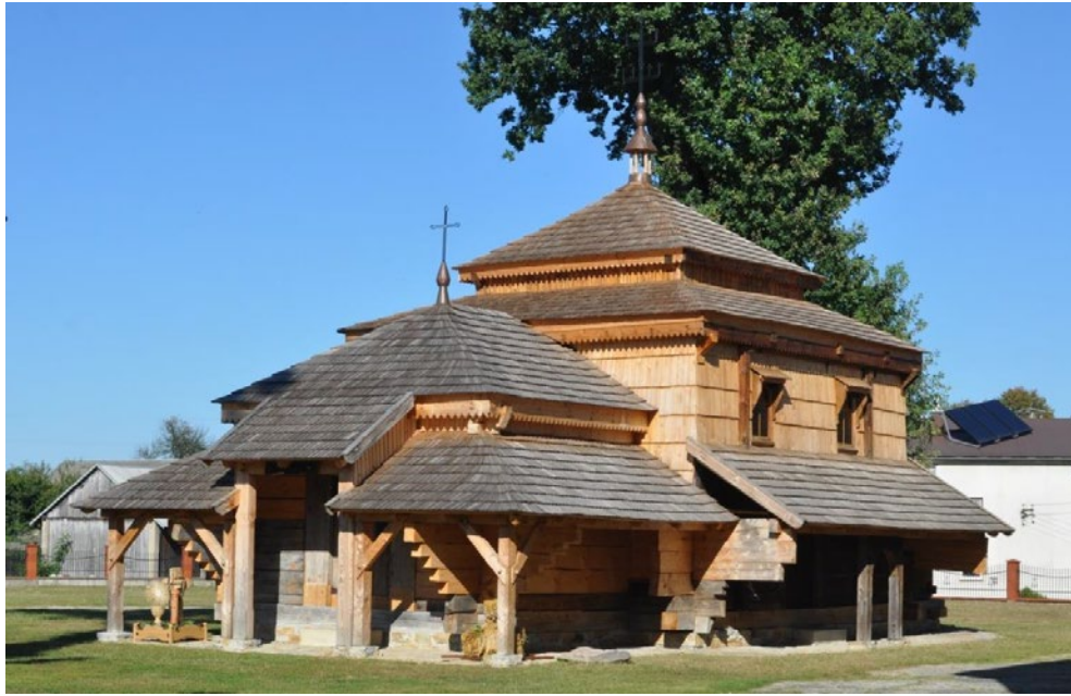
85. Rudka, pow. przeworski. Cerkiew Zaśnięcia Matki Bożej. Widok od pd.-zach., obiekt po zakończeniu prac remontowych prowadzonych w latach 2004-2012. Mimo ściśle określonych wytycznych zawartych w projekcie konserwatorskim wykonawca prac postanowił zmienić formę opasania (i tak już mocno niezgodną z historyczną), tworząc rozwiązanie bardzo odległe od oryginalnej architektury zabytku. Fot. A. Żygadło, 2013. Zbiory autora.
