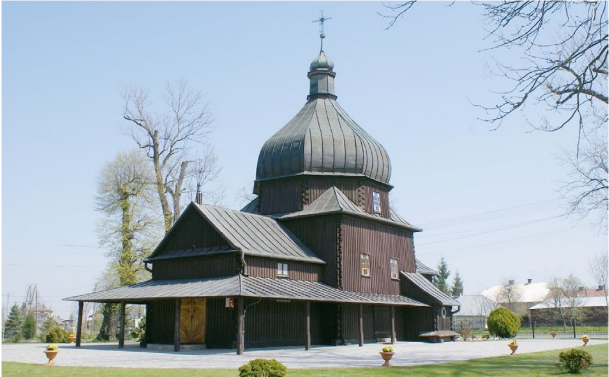
104. Poździacz (ob. Leszno), pow. przemyski. Cerkwi św. Bazylego Wielkiego, widok od pd.-zach. Widoczne w całym obiekcie nowe ahistoryczne węglowania z resztkami, wskazujące na wymianę 90% substancji zabytkowej podczas remontu. W elewacji zach. nowy portal. Fot. D. Nowak, 2011. Zbiory autora.
