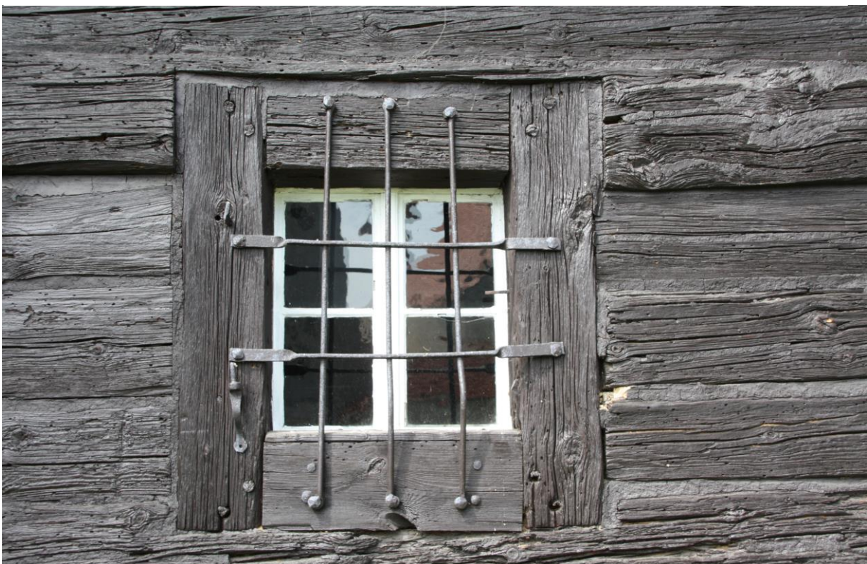
Fotografia nr 34 Chocianowice, stolarka i krata historyczne, fot. G. Naumowicz
