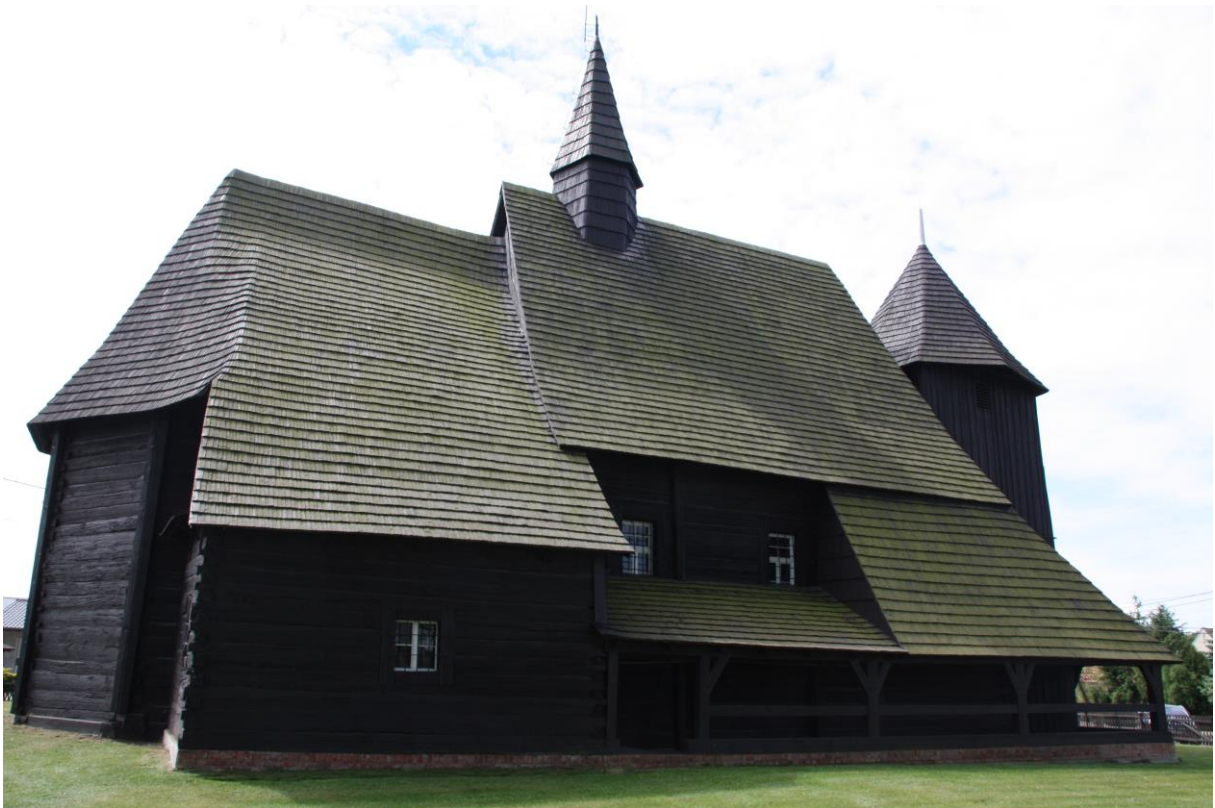
Fotografia nr 2 Chocianowice, gont łupany, strona północna, fot. G. Naumowicz
