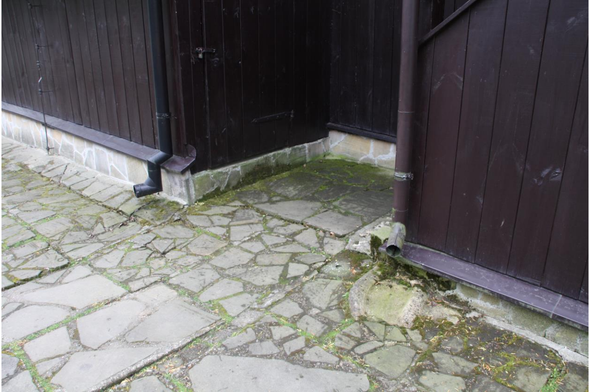
Fotografia nr 28 Bąków, utwardzenie terenu, podmurówka i rury spustowe odprowadzające wody opadowe tuż przy ścianach kościoła, fot. G. Naumowicz
