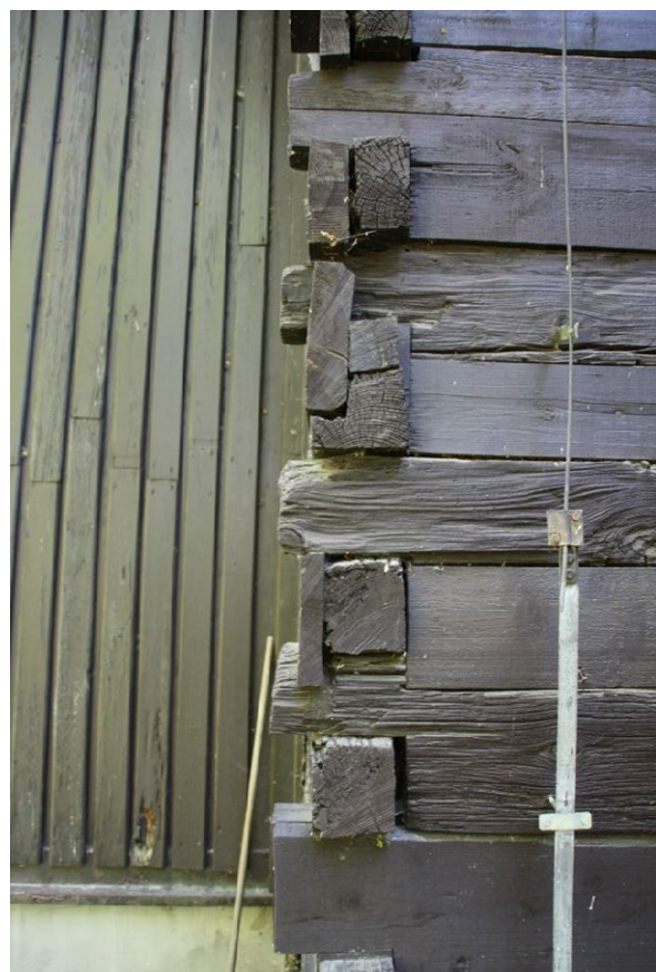
Fotografia nr 17 i 18 Rożnów i Świniary Wielkie, przykłady powierzchniowej naprawy bierwion, fot. G. Naumowicz
