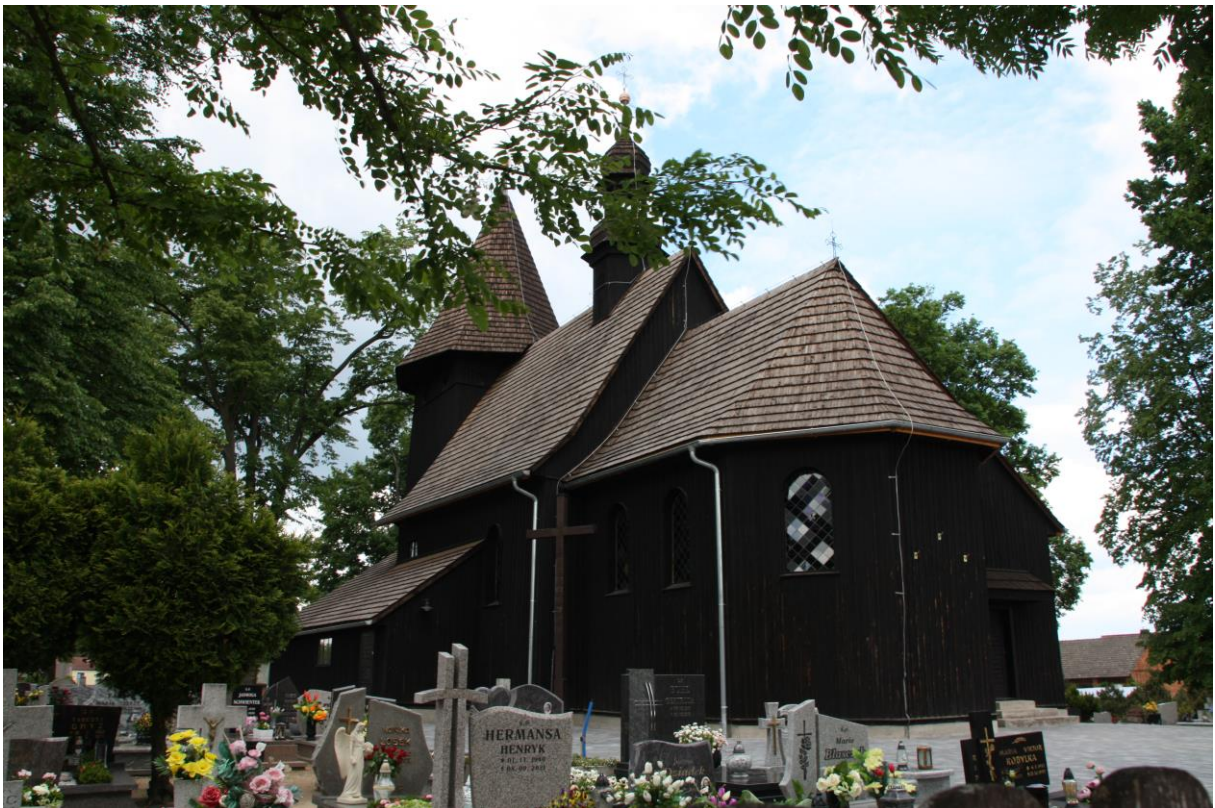
Fotografia nr 4 Laskowice, nowe pokrycie dachowe i system orynnowania, fot. G. Naumowicz
