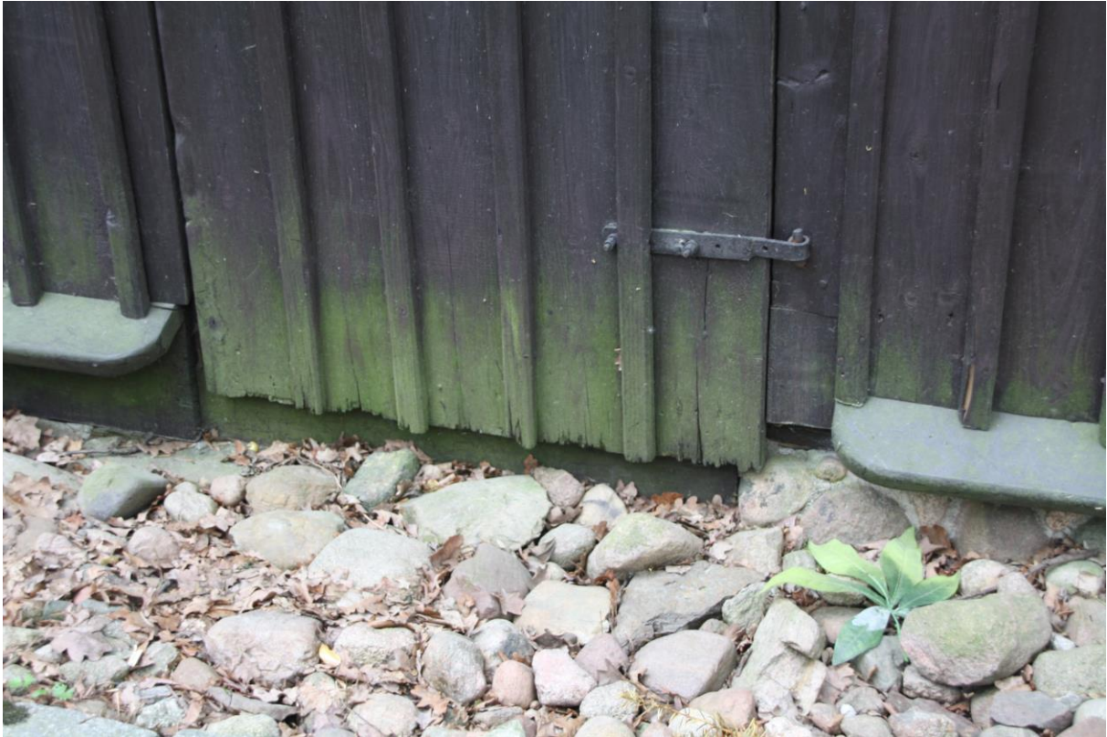
Fotografia nr 22 Jakubowice, zniszczenia od wód opadowych odbijających się od otoczeków, fot. G. Naumowicz
