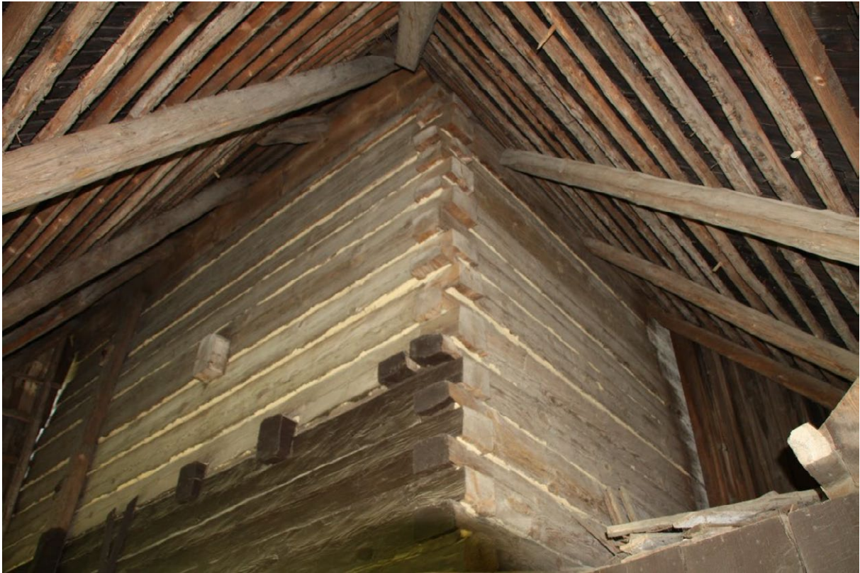
Fotografia nr 10 Chocianowice, fragment niepoczerzonego zrębu pod sobotami (zaledwie dwa niewielkie fragmenty w całym analizowanym zasobie), fot. G. Naumowicz
