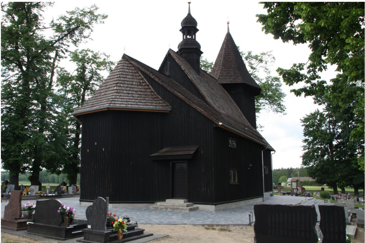
Fotografia nr 29 Laskowice, utwardzenie wykonane zapewne w tym roku (tj. 2023) z kostki betonowej
