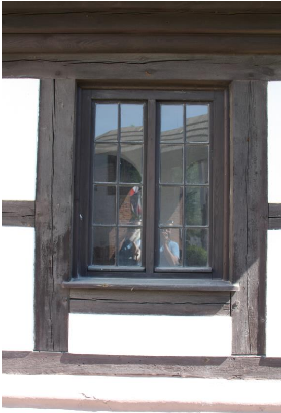
Fotografia nr 35 Wierzbica Górna, dobry przykład wymiany stolarki, fot. G. Naumowicz
