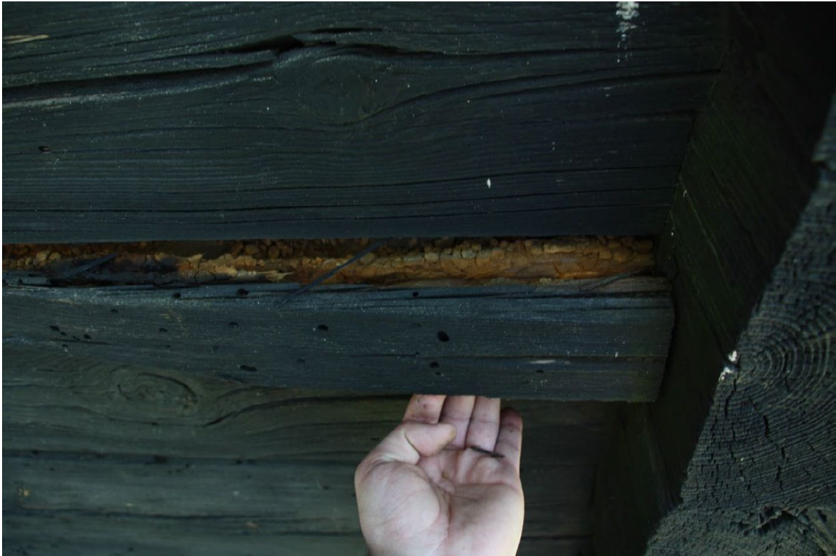
Fotografia nr 16 Wierzbica Dolna, warstwa wierzchnia spojona impregnatami, z odległości, z otworami po owadach, pod warstwą wierzchnią widoczny rozkład drewna, fot. G. Naumowicz
