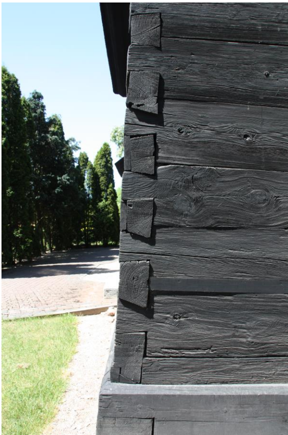
Fotografia nr 17 i 18 Rożnów i Świniary Wielkie, przykłady powierzchniowej naprawy bierwion, fot. G. Naumowicz
