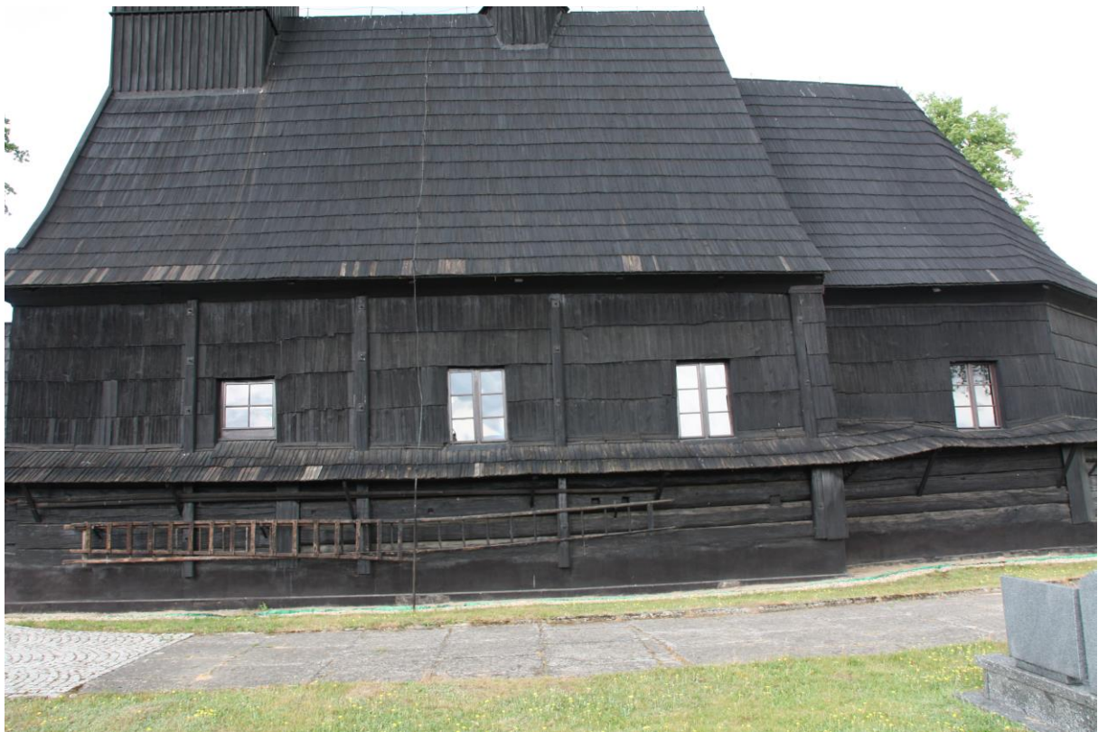
Fotografia nr 21 Wędrynia, zrębu ponad sobotami pobity gontem, podmurówka i podwalina otynkowane i pokryte substancją bitumiczną, fot. G. Naumowicz
