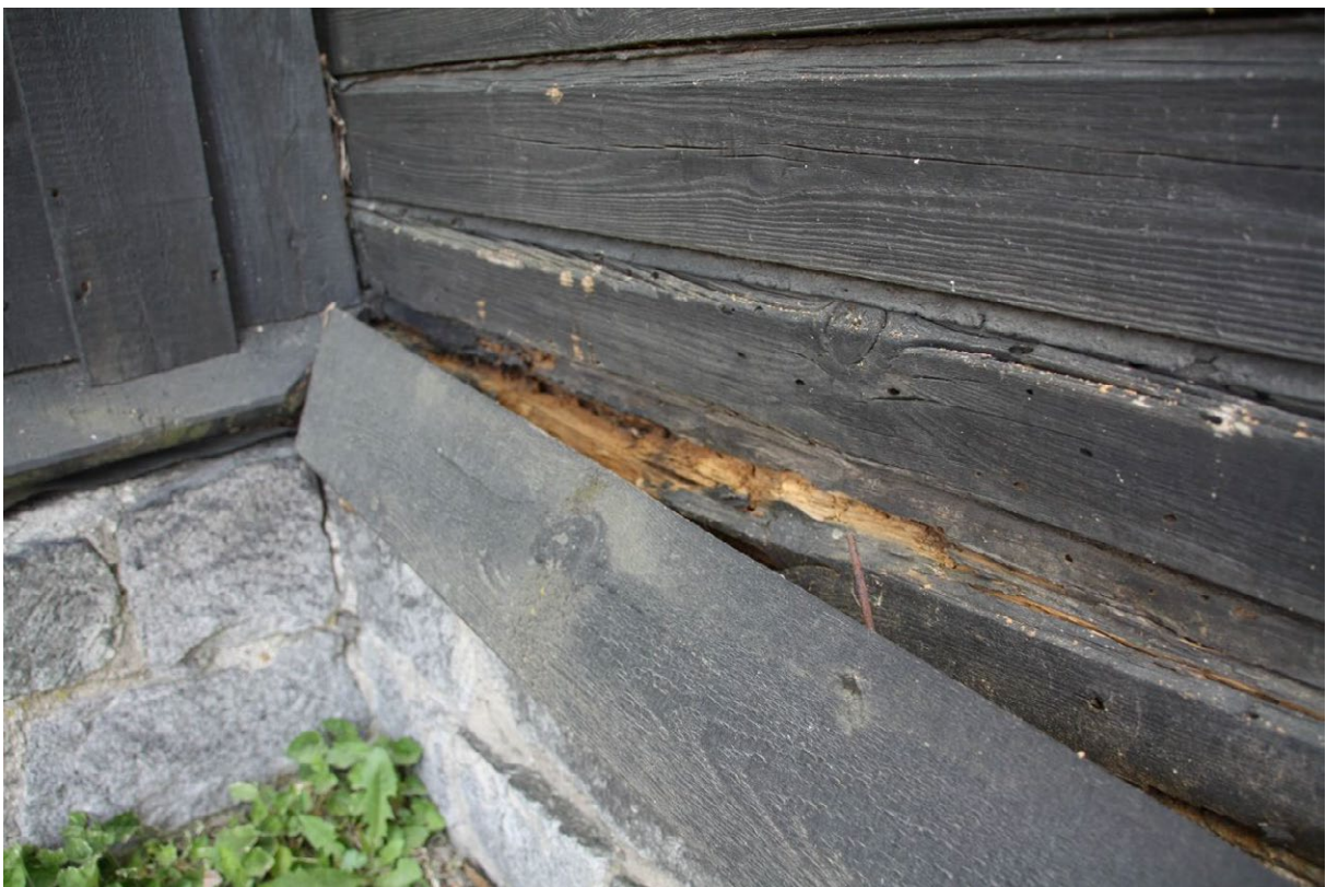
Fotografia nr 15 Wierzbica Dolna, rozkład drewna pod deską okapową, fot. G. Naumowicz
