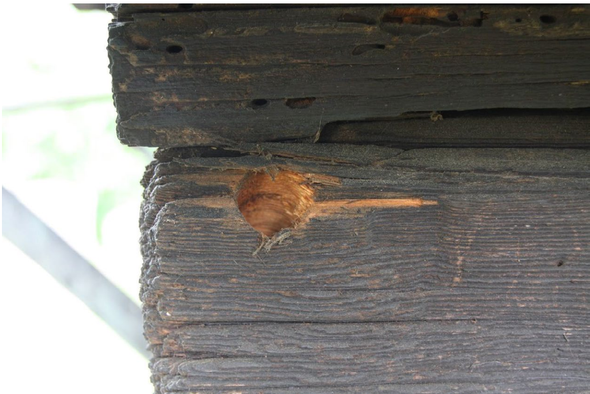
Fotografia nr 13 Maciejów, ślady po badaniach denrochronologicznych, fot. G. Naumowicz
