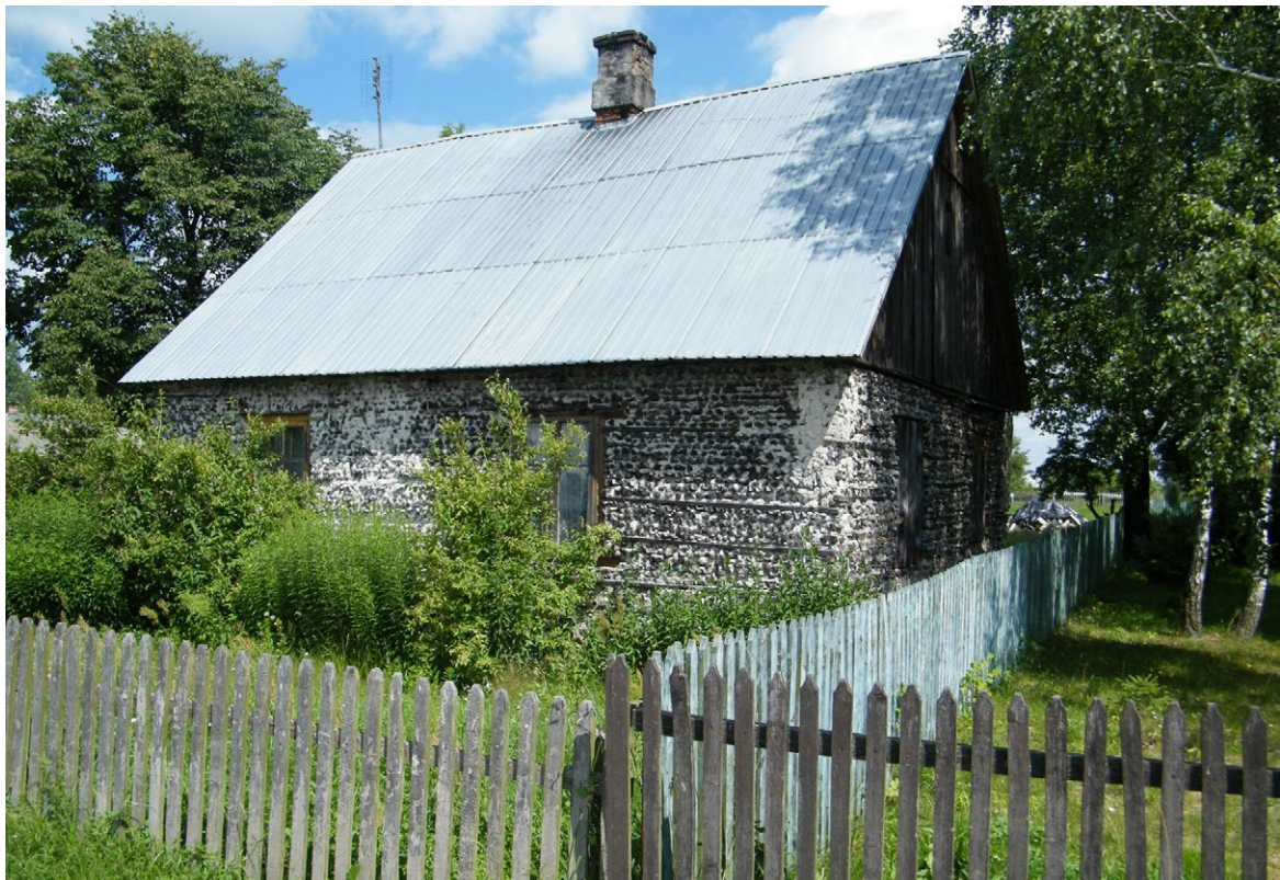
Fot. 10. Dom z lat 50. XX w. we wsi Kamieńskie w nadbużańskiej gm. Ceranów (woj. mazowieckie) – przykład konstrukcji typu wileńskiego (z polan układanych ukośnie do pow. ściany), fot. J. Szewczyk, 2008
