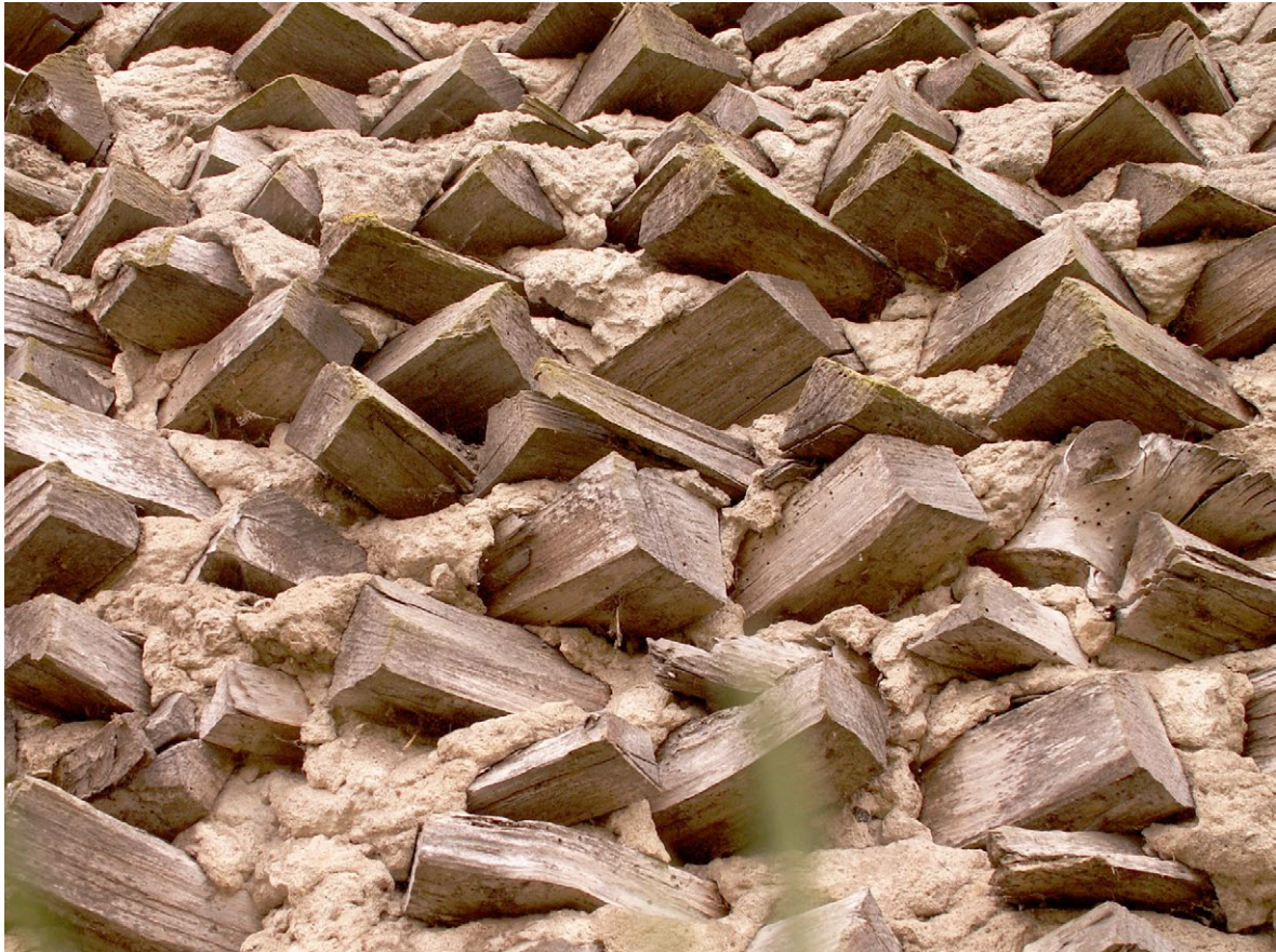
Fot. 9. Przybudówka z lat 50. XX w. w Kolonii Mężenin w gm. Platerów – przykład konstrukcji typu wileńskiego (z polan układanych ukośnie do pow. ściany), fot. J. Szewczyk, 2008
