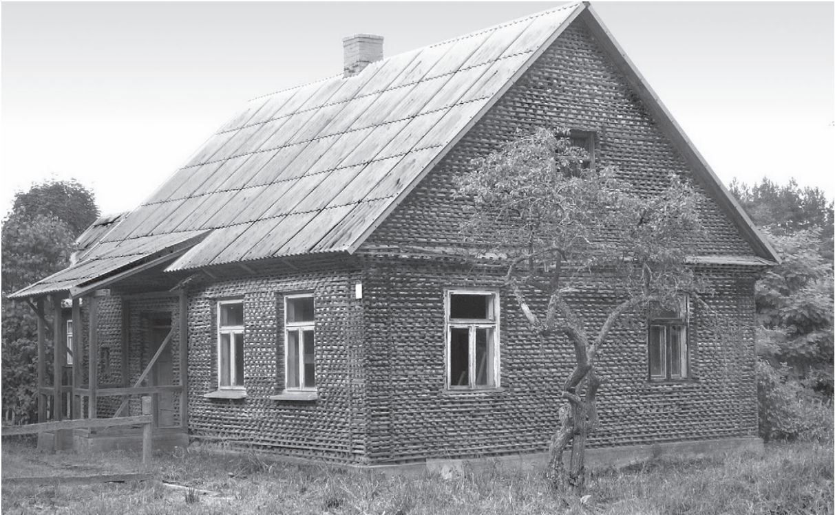
Fot. 7. Najstarszy typ konstrukcji z polan opałowowych układanych prostopadłe do pow. ściany (typ wołyński), spajanych zaprawą wapienną, w domu z 1926 r. w puszczańskiej osadzie Ożynniki w gm. Wasilków, fot. J. Szewczyk, 2007
