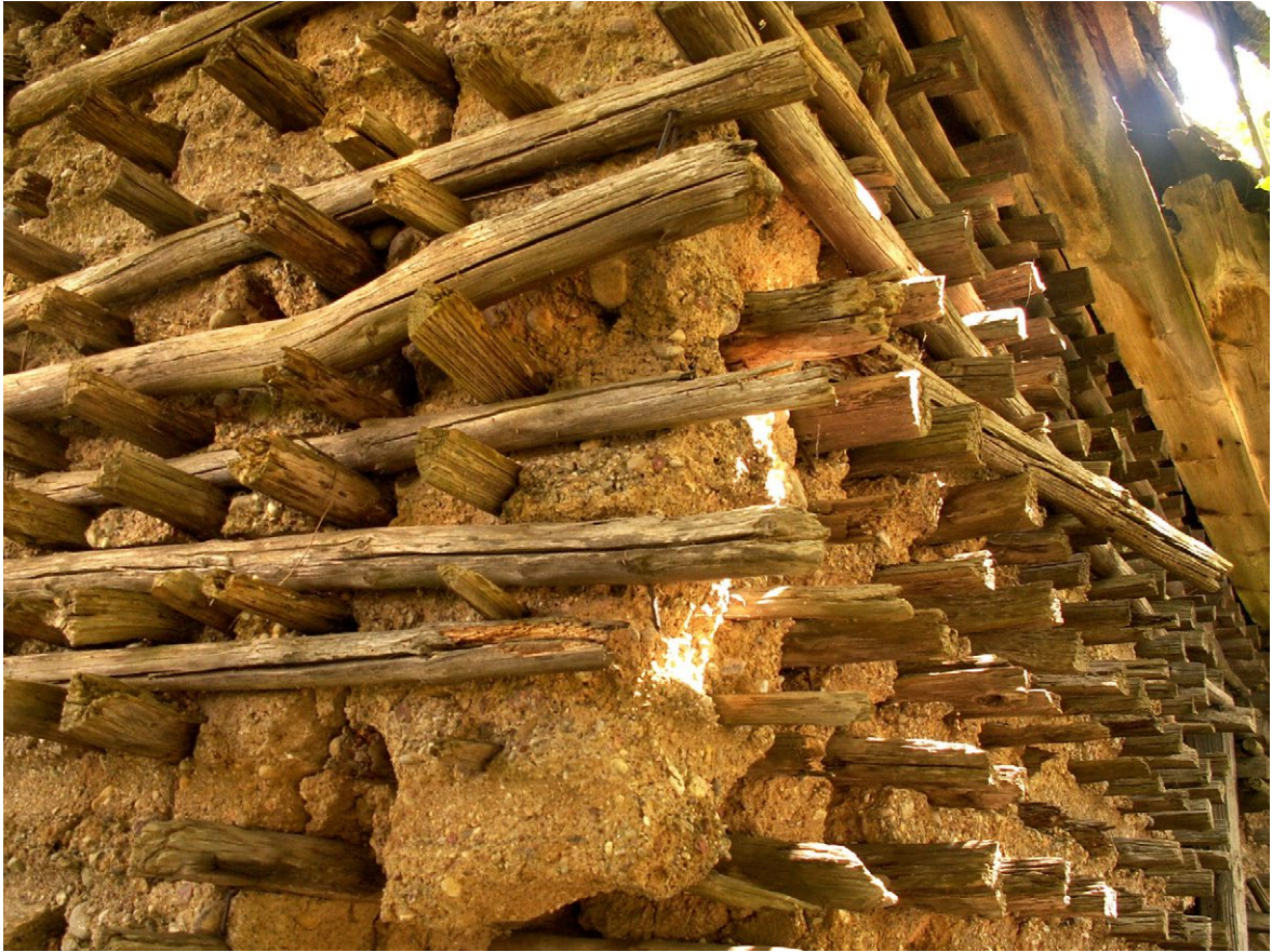
Fot. 5. Najstarszy typ konstrukcji z polan opałowymi układanych prostopadle do pow. ściany (typ wołyński) i spajanych zaprawą gliniano-wapienną: dom z 1926 r. we wsi Gliniszcz Wielkie, gm. Sokółka (zburzony), fot. J. Szewczyk, 2009
