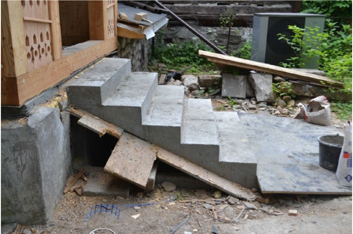
47. Willa „Jadwiniówka I”, drew., 1886; wpis do rejestru zabytków A-437 z dn. 24.01.1986 i [A-66/M] z dn. 09.10.2006, fot. N. Skiepmo 2019
