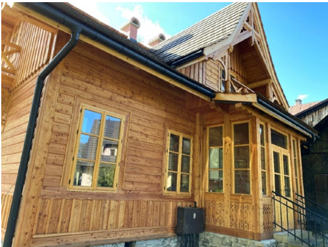
55. Całkowita wymiana substancji zewnętrznej: szalunku, stolarek, konstrukcji ganku, schodów i stopni, balustrad, szczytów, pokrycia dachowego, kominów. Willa „Jadwiniówka I”, 1886; wpis do rejestru zabytków A-437 z dn. 24.01.1986 i [A-66/M] z dn. 09.10.2006, fot. N. Skiepmo 2022
