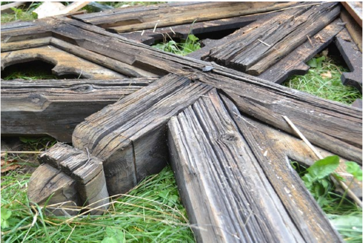
50. Willa „Jadwiniówka I”, 1886; wpis do rejestru zabytków A-437 z dn. 24.01.1986 i [A-66/M] z dn. 09.10.2006, dekoracje szczytów elewacji południowej, promieniowanie UV, wilgoć, fot. N. Skiepmo 2020
