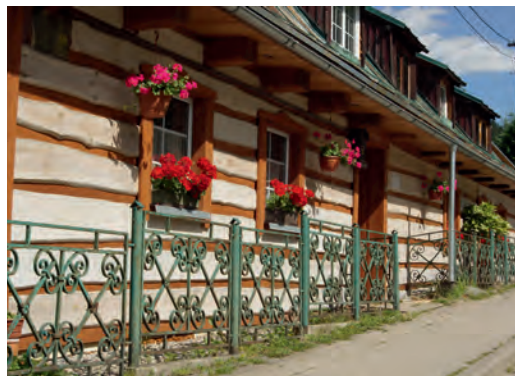
Montaż ahistorycznych szalunków zewnętrznych zmieniających formę elewacji domu drewnianego, fot. P. Roczek
