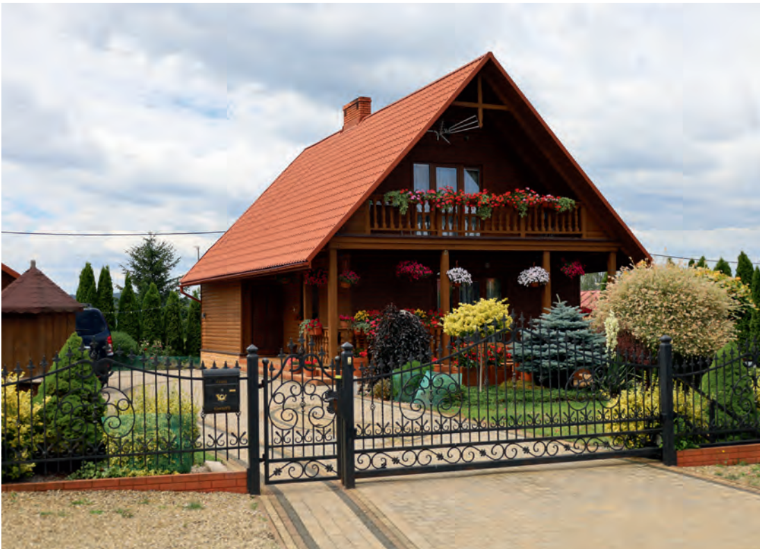
Mechanizm wymiany tradycyjnej zabudowy drewnianej – budowa nowego budynku w sąsiedztwie zabytku, stan w 2009 i 2022, fot. B. Podubny i R. Kwolek
