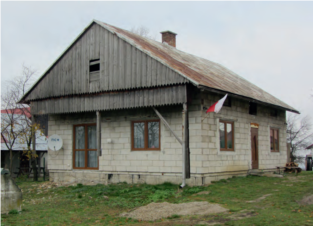
Mechanizm wymiany tradycyjnej zabudowy drewnianej – zastąpienie konstrukcji drewnianej murowaną, stan w 1972 i 2022 r., fot. B. Wanat i J. Stęchły
