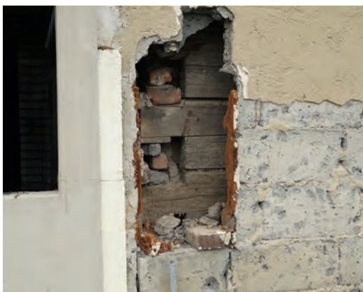
Konstrukcja drewniana ścian budynku wtórnie obmurowana i ukryta pod warstwą materiału izolującego, fot. P. Roczek
