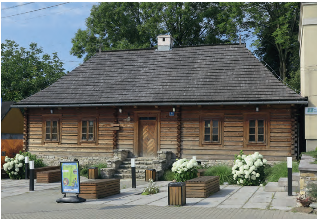
Rekonstrukcja drewnianego zabytku z wykorzystaniem nowego drewna przy zachowaniu dawnej formy, fot. A. Olczyk
