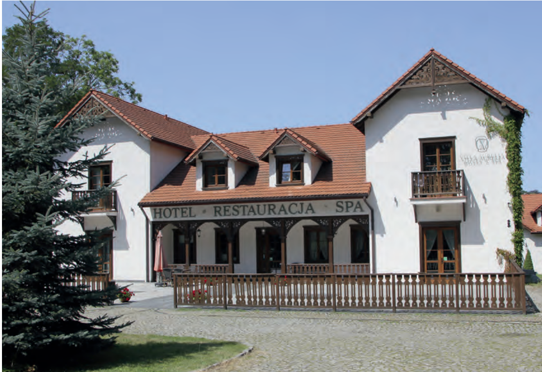
Budowa nowego obiektu o konstrukcji murowanej w miejscu dawnego budynku drewnianego z powtórzeniem jego pierwotnej formy, fot. A. Sikora-Terlecka
