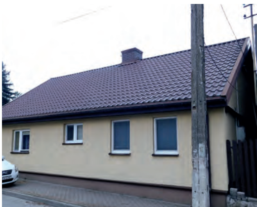
Całkowite przekształcenie pierwotnej formy domu drewnianego poprzez termomodernizację ścian oraz wymianę stolarek okiennych i pokrycia dachu, fot. J. Opaska
