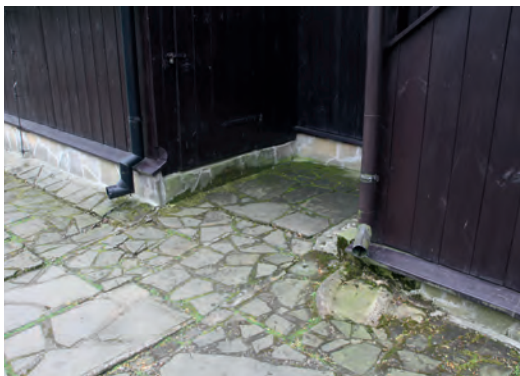
Utwardzenie terenu wokół zabytku ograniczające możliwość odparowywania wilgoci z gruntu, fot. G. Naumowicz
