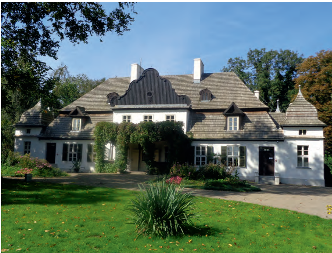
Dwór drewniany w Koszutach, Wielkopolska, fot. A. Wawrzyńczuk
