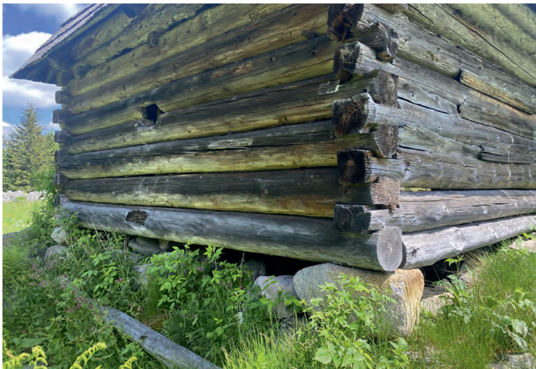
Szałas pasterskie w Tatrach – zachowana pierwotna konstrukcja ścian drewnianych tradycyjnie posadowionych na masywnych kamieniach umieszczonych pod węglami w narożach ścian, fot. N. Skiepmo
