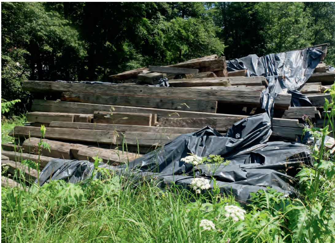
Elementy rozebranego zabytku przewidzianego do translokacji. Niebezpieczeństwo zniszczenia drewna w wyniku długotrwałego przechowywania i braku prawidłowego zabezpieczenia, fot. M. Warchoł
