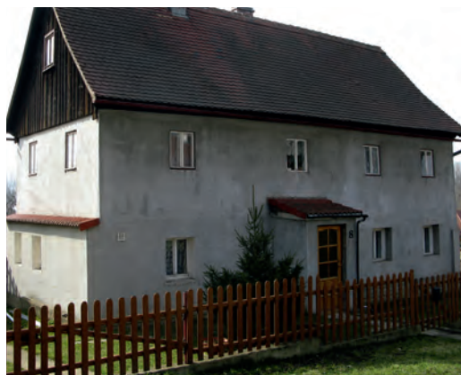
Termomodernizacja drewnianego zabytku o konstrukcji przysłupowej, skutkująca zatarciem jego pierwotnych cech stylowych, fot. P. Roczek
