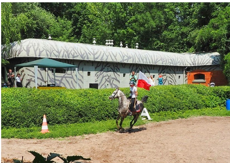
17. Budowla (obiekt) bojowa w fortyfikacji (system fortowy grupowy, Fort 49 1/4 Grębałów, Twierdza Kraków). Tradytory – pancerna bateria kazamatowa do ognia bocznego, adaptowana na obiekt edukacyjno-muzealny, przed nim ujeżdżalnia terenowa. Fot. K. Wielgus
