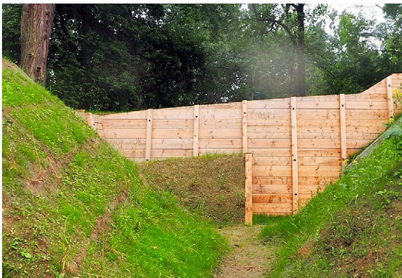
20. Formy ziemne w fortyfikacji. Oryginalne, odrestaurowane ściśle wg historycznych metod i technologii stanowisko piechoty na wale artyleryjskim Fortu 52 „Borek” Twierdzy Kraków (1884-86), rewaloryzacja – 2020 r. Fot. K. Wielgus
