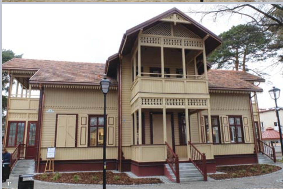
9, 12. Widok ogólny 10. Wejście na werandę 11, 13. Elewacja frontowa Fot. 9-13 | Maciej Warchoń, NID
