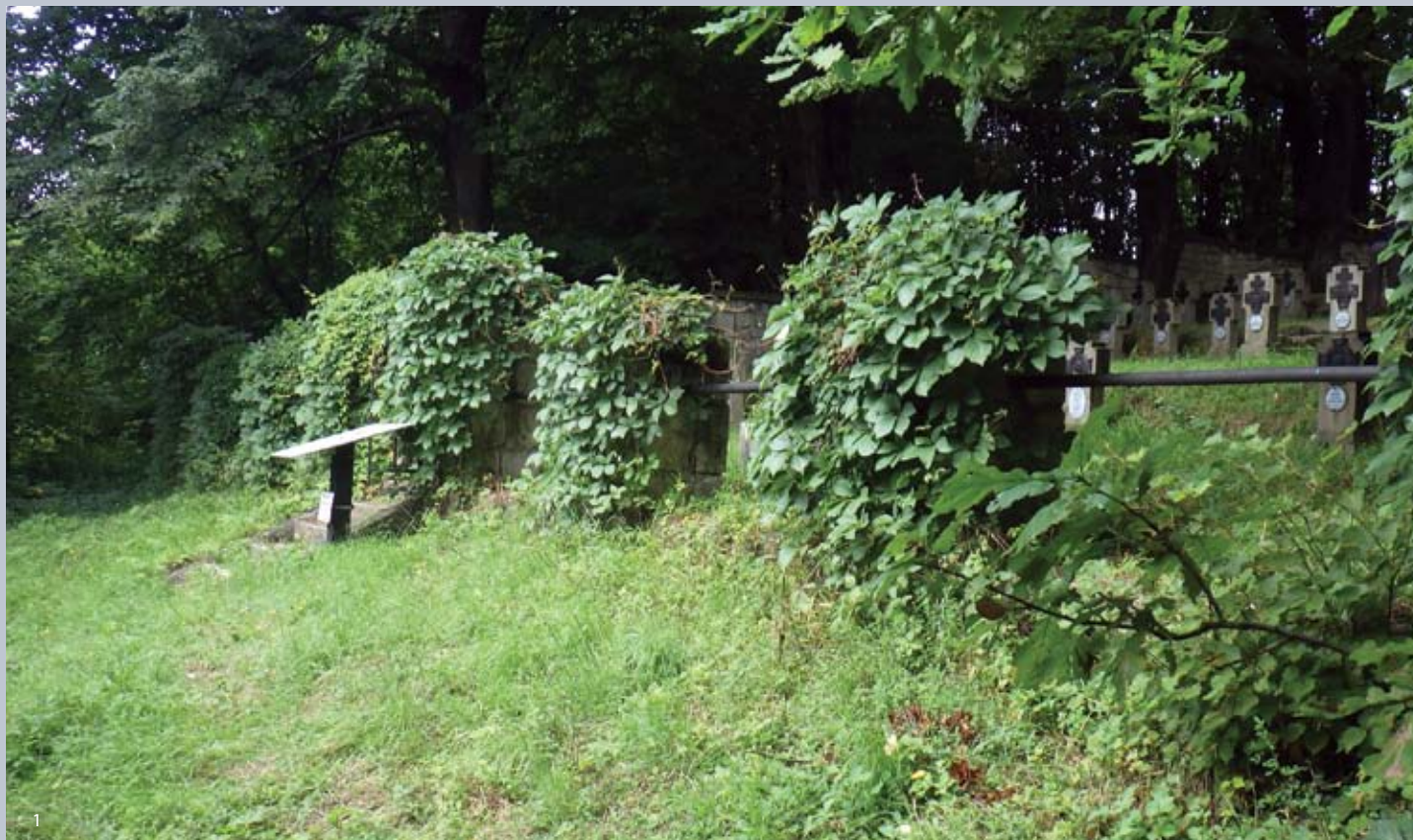
1. Ogrodzenie cmentarza – widok od południowego wschodu
