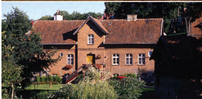
5. Gietrzwałd, pow. olsztyński, typowy murowany dom z czerwonej cegły licowej, z dwuspadowym dachem pokrytym ceramiczną dachówką.
