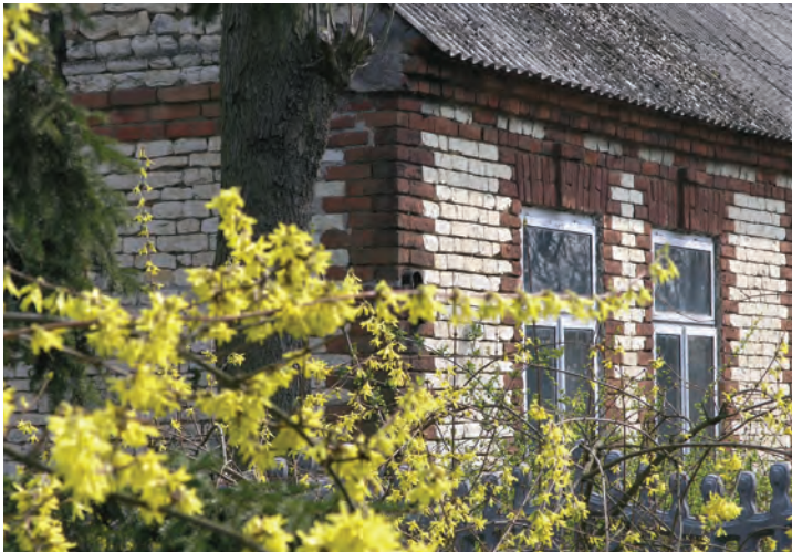
1b. Okolice Poddębic i Uniejowa. Tradycyjna zabudowa z kamienia wapiennego i cegły na wsi. Fot. W. Witkowski.
