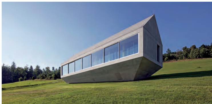
4. Brenna, stok Równicy (Beskidy). Arka Koniecznego, projekt Robert Konieczny KWK Promes. Fot. Olo Studio.
