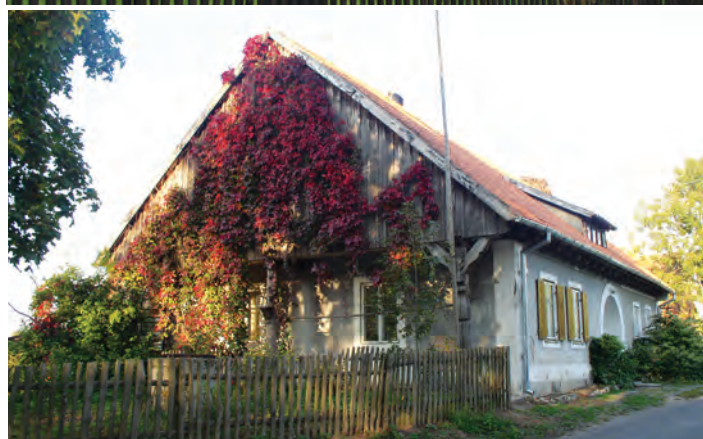
9c. Suczki, pow. węgorzewski, murowany budynek mieszkalny z drewnianym podcieniem szczytowym. Przykład wykorzystania elementów regionalnych, początek XX wieku. Fot. Iwona Liżewska, 2001.
