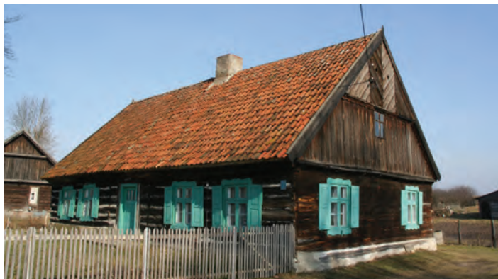
6. Marcinkowo, pow. olsztyński, drewniana chałupa konstrukcji zrębowej. Fot. Iwona Liżewska, 2010.
