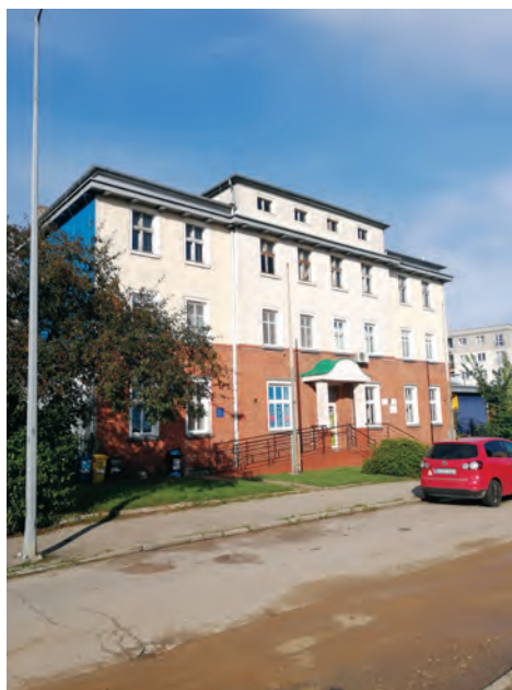
4. Giżycko. Ponadstuletni budynek Zakładu Energetycznego zburzony w 2021 roku. W jego miejsce planowana jest budowa apartamentowca. Fot. W. Łukowski.
