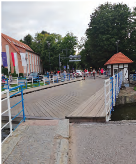
2. Giżycko. Most obrotowy na Kanale Łuczańskim w trakcie otwierania go dla ruchu wodnego. Fot. W. Łukowski.
