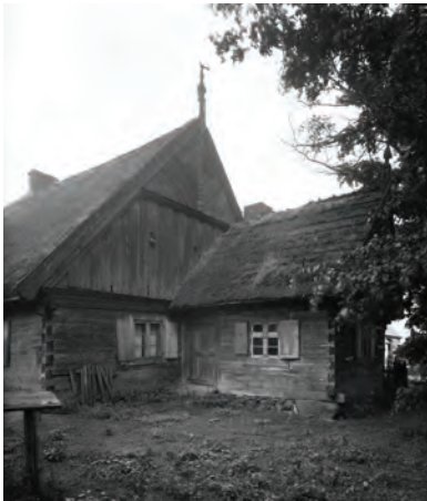
11a. Kulik, drewniana chałupa mazurska z dekoracyjnym deskowaniem szczytu ozdobionym pazdurem, początek XIX wieku. Fot. Bruno Zelinsky. Zbiory fotograficzne dawnego Urzędu Konserwatora Zabytków w Królewcu, Instytut Sztuki PAN, sygn. 056570.
