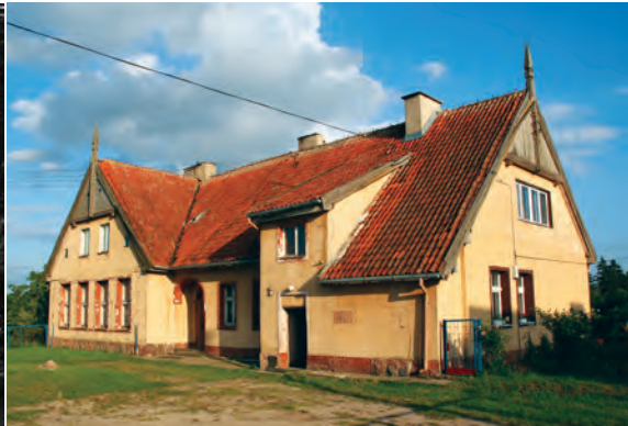
11b. Marcinowa Wola, pow. giżycki, murowany budynek szkolny z podcieniem wnekowym i odeskowanym szczytem z pazdurem. Przykład wykorzystania elementów regionalnych, początek XX wieku. Fot. Iwona Liżewska, 2008.
