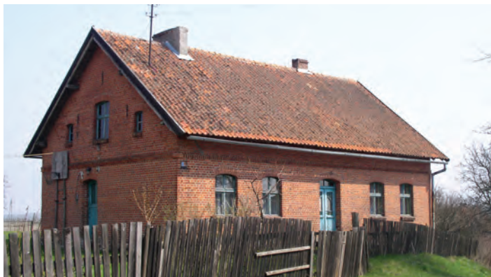
2. Zawady, pow. ostródzki, typowy murowany dom z czerwonej cegły licowej, z dwuspadowym dachem pokrytym ceramiczną dachówką.
