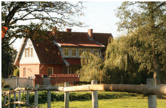
15. Iwanowo, pow. piski, współcześnie zaprojektowany i wybudowany dom w duchu wernakularyzmu tradycyjnego. Fot. Iwona Liżewska, 2021.
