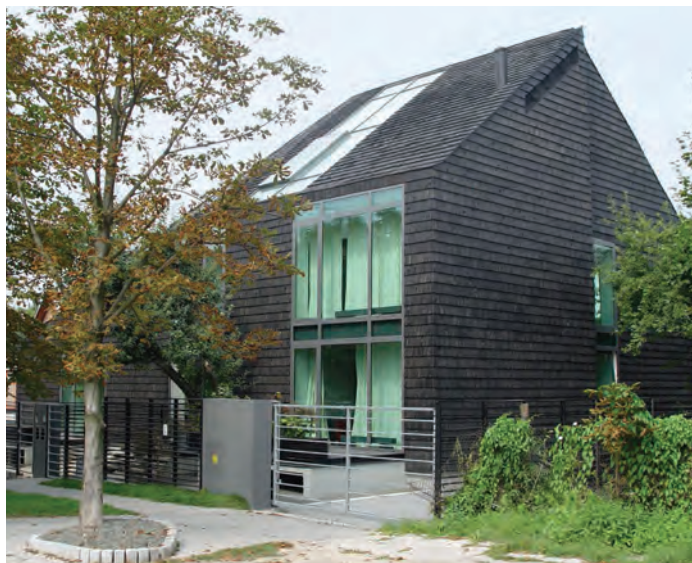
1. Dom z gontu, Kraków, Polska, autorzy: nsMoon Studio. Źródło: http://alpinafire.pl/pl/realizacje_49/zabudowy-fasadowe_3 [dostęp: 10 listopada 2022].
