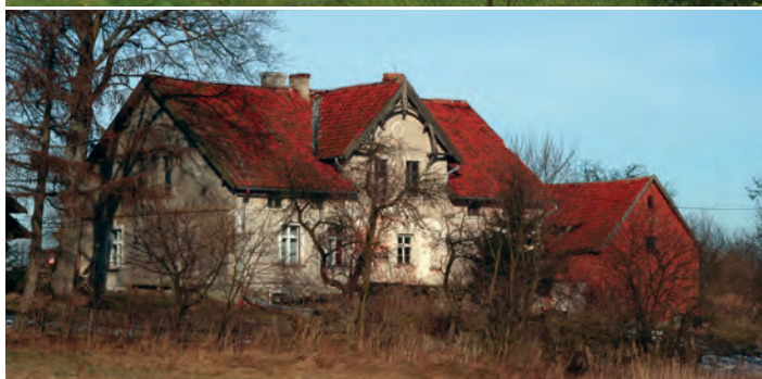
4. Ząbrowiec, pow. elbląski, typowy murowany dom z czerwonej cegły licowej, z dwuspadowym dachem pokrytym ceramiczną dachówką.
