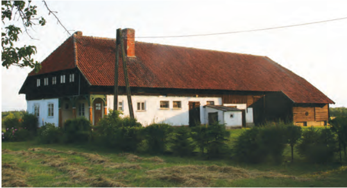
10b. Mażany, pow. kętrzyński, murowany budynek mieszkalny z drewnianym podcieniem narożnym. Przykład wykorzystania elementów regionalnych, lata 30. XX wieku. Fot. Iwona Liżewska, 2002.
