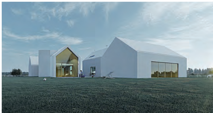
6. Dom na Jurze, projekt: GórnikArchitects, 2020.
