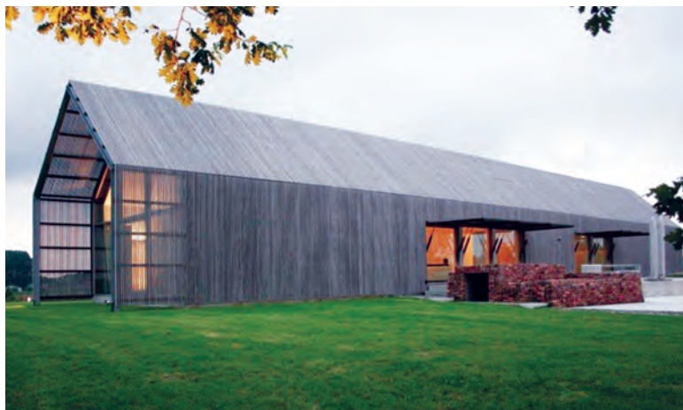
4. The Barn House – Dom-stodoła, Flanders, Belgia, autorzy: Buro2. Źródło: https://www.wallpaper.com [dostęp: 10 listopada 2022].
