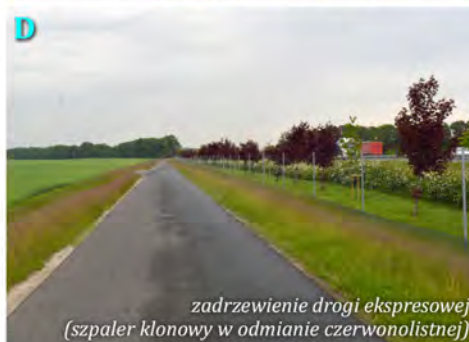
ryc. 146. Przebieg drogi ekspresowej S5 przez wnętrze krajobrazowe w majątności Iwno
