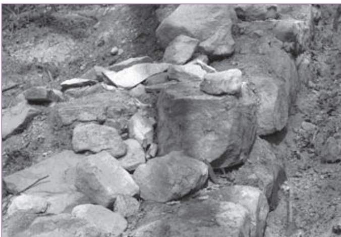
2. Krajowice. Relikty zamku Golesz. Kamienie wybrane ze zniszczonej wkopami podziemnej partii murów i złożone na koronie oryginalnego muru zamkowego, kwiecień 2009. Fot. I. Malawska.
