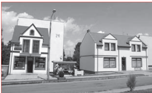
8. Zalewo, realizacja zabudowy pierzei północnej centrum miasta, stan obecny. Fot. J. Domino.
