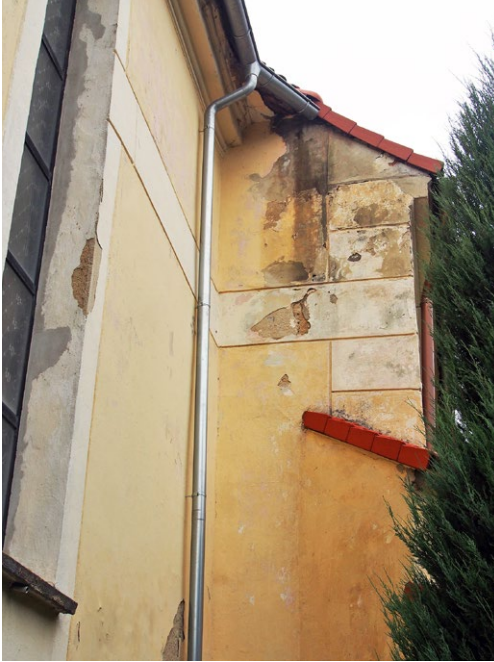
Fot. 7b, c Błędy w wykonaniu systemów orynnowania i kanalizacji deszczowej, niedrożne odpływy — nie są niestety rzadkim zjawiskiem
