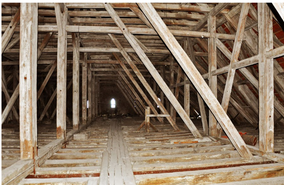
Il. 112 Toruń, kościół pw. NMP. Więżba nad nawą główną, jętkowa o mieszanym systemie konstrukcyjnym: o dwóch stolcach leżących, dwóch stolcach stojących i z wieszarem jednowieszakowym (fot. U. Schaaf, 2021)
