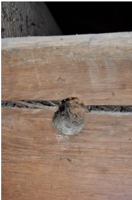
Il. 126 Toruń, kościół pw. św. Janów. Więźba dachowa nad prezbiterium. Otwór po jednym kołku na elemencie konstrukcji pochodzącej z XIV w. (fot. U. Schaaf, 2019)
