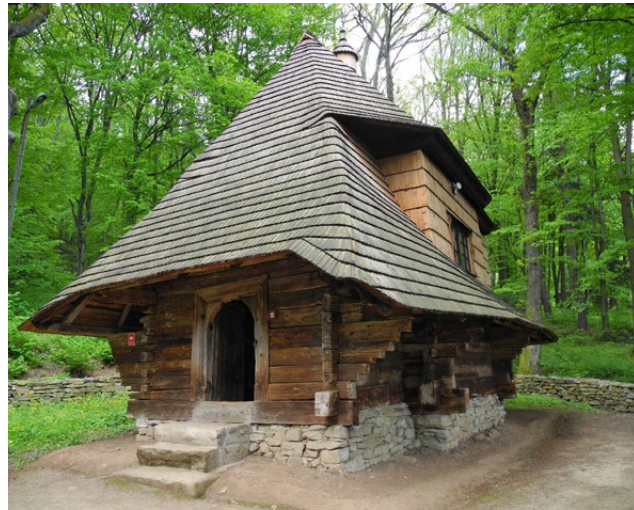
Il. 28 Muzeum Budownictwa Ludowego w Sanoku. Wieńcowa cerkiew z Rosolina, 1750 r. (fot. M. Prarat, 2018)
