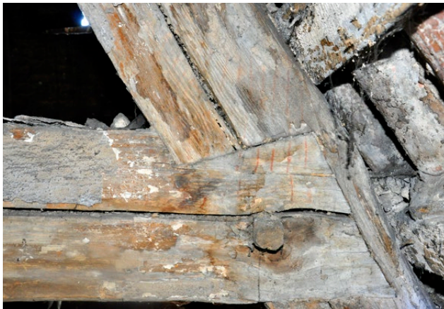
Il. 74 Toruń, kamienica na ul. Mostowej 6. Więźba dachowa z połowy XVI w., znak przechodzący przez jętkę i krokiew (fot. U. Schaaf, 2018)
