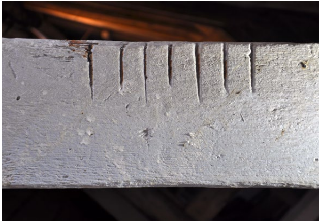
Il. 66 Wrocław, budynek na ul. Szewskiej 49. Więźba dachowa z 1846 r. Narastający system numeracji z użyciem ciesielskich znaków montażowych o formie kreskowej we wtórnie użytych elementach z XIV w. (fot. U. Schaaf, 2020)
