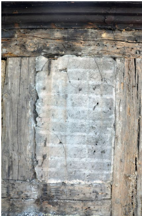
Il. 159 Niedziejewo, kościół pw. Świętego Andrzeja Apostoła z 1753 r. Otynkowane pola szkieletu z namalowanym układem cegieł (fot. U. Schaaf, 2020)
