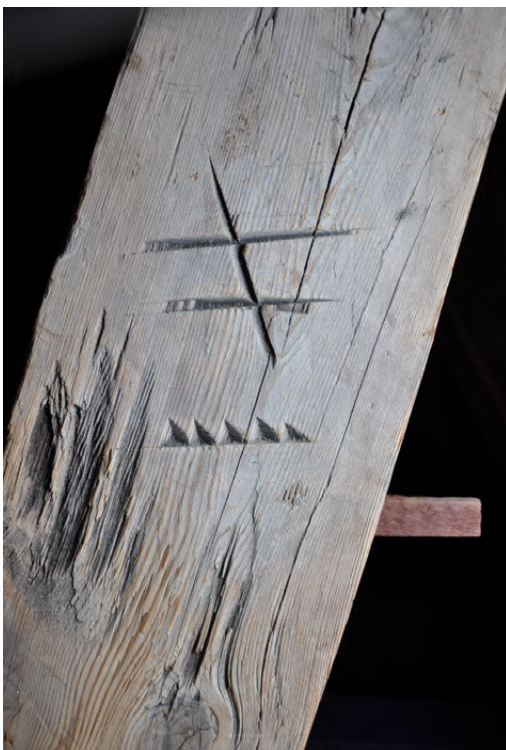
Il. 70 Toruń, kościół pw. św. Janów. Więźba dachowa z lat 30. XV w., ciesielskie znaki montażowe w formie cyfr rzymskich łączonych ze znakami trójkątnymi przylegającymi do cienkiej kreski (fot. U. Schaaf, 2018)
