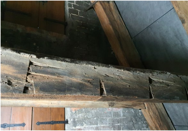
Il. 97 Toruń, ul. Kopernika 15. Więźba dachowa z 1370 r. Widoczne ślady po obróbce siekierą (fot. M. Prarat, 2022)
