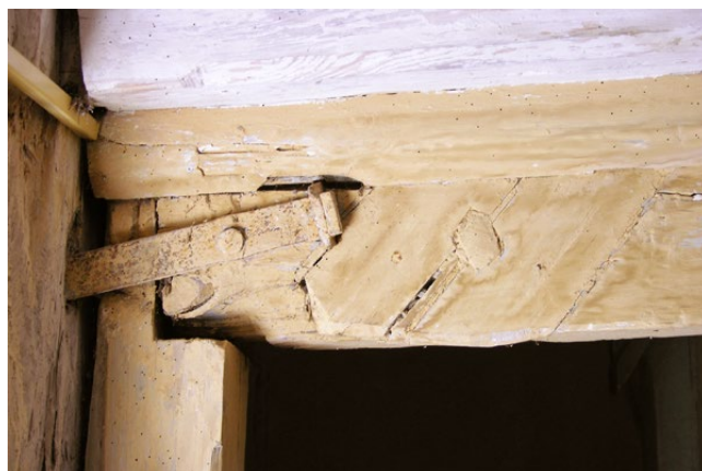
Il. 59 Lubiechnia Mała, kościół Podwyższenia Krzyża Świętego z końca XVII w. Obcięta nakładka zaczepowa w dolnym ryglu obecnej konstrukcji empory (fot. U. Schaaf, 2017)
