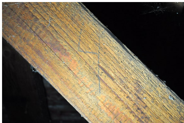
Il. 63 Nawra, pałac z przełomu XVIII i XIX w. Więżba dachowa, ciesielski znak montażowy wykonany ołówkiem (fot. U. Schaaf, 2021)
