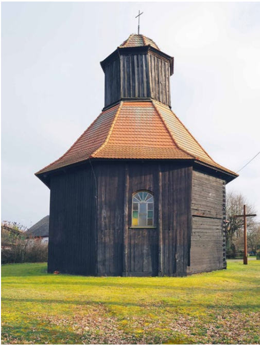
Il. 27 Trzebule, kościół w konstrukcji wieńcowej z 1670 r. (fot. U. Schaaf, 2024)
