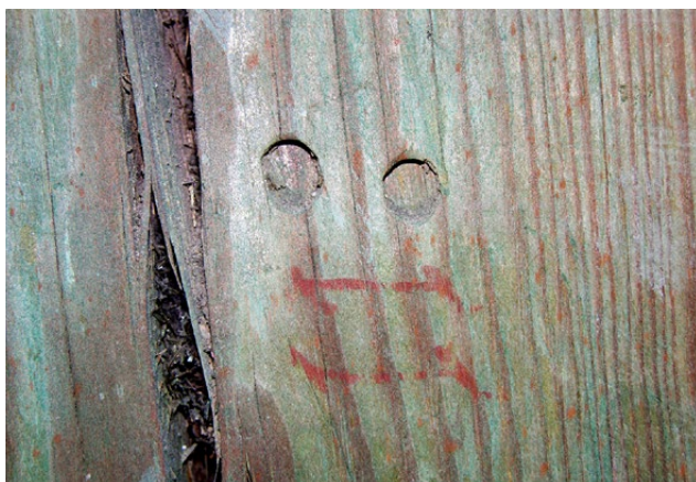
Il. 64 Rościszawice, kościół Podwyższenia Krzyża Świętego z początku XVIII w. Element konstrukcji oznaczony podwójnie – dłutem i sangwiną (fot. U. Schaaf, 2009)
