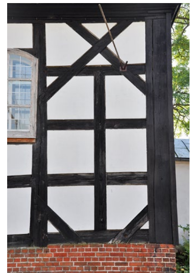
Il. 42 Kalsko, kościół o zdwojonej konstrukcji ścian z 1692–1693 r. Narożne przęsło elewacji. Widoczne zastąpienie dolnych fragmentów konstrukcji i pół szkieletu murem ceglany (fot. U. Schaaf, 2019)
