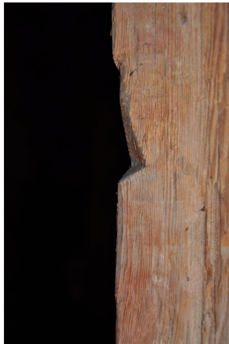
Il. 127 Toruń, kościół pw. św. Janów. Więźba dachowa nad nawą południową z lat 30. XV w. Narożne podcięcie związane z pionowym transportem budulca (fot. U. Schaaf, 2019)
