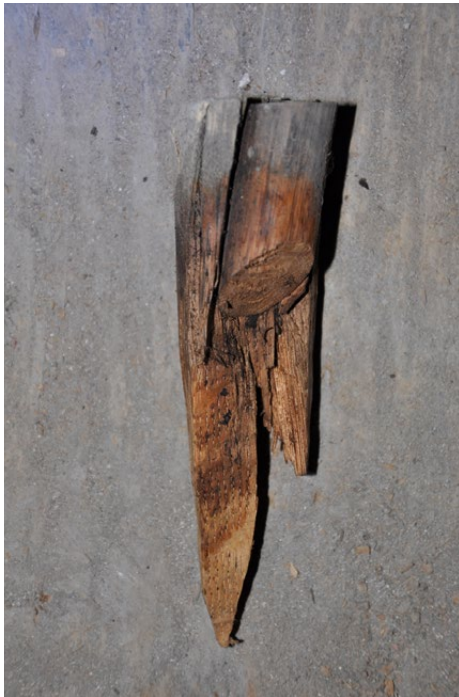
Il. 124 Toruń, kościół pw. św. Janów. Więźba dachowa nad nawą południową z lat 30. XV w. Wyjęty klin ze śrykówką (fot. U. Schaaf, 2021)
