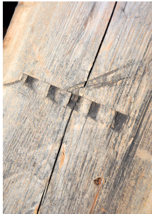
Il. 67 Toruń, kościół pw. św. Janów. Więźba dachowa z lat 30. XV w. Narastający system numeracji z użyciem ciesielskich znaków montażowych o formie kwadratowych nacięć (fot. U. Schaaf, 2018)
