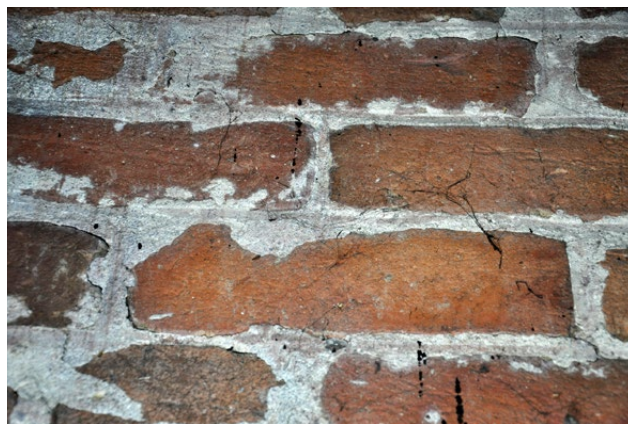
Il. 152 Świerzno, kościół szkieletowy z 1681 r. Eksponowane lico ceglane z opracowaną i pomalowaną na czerwono spoiną (fot. U. Schaaf, 2020)
