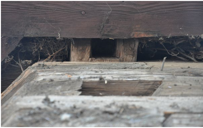
Il. 175 Szczerców, kościół z 1516–1517 r. (obecnie kaplica cmentarna). Puste gniazdo od spodu belki kulawkowej po zaczepie (fot. U. Schaaf, 2019)
