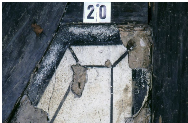
Il. 156 Świdnica, kościół pw. św. Trójcy z 1656–1657 r. Opracowanie kolorystyczne – szaroczarny pas obwiedziony linią konturową i linią towarzyszącą w odległości około 5 cm (fot. U. Schaaf, 2005)
