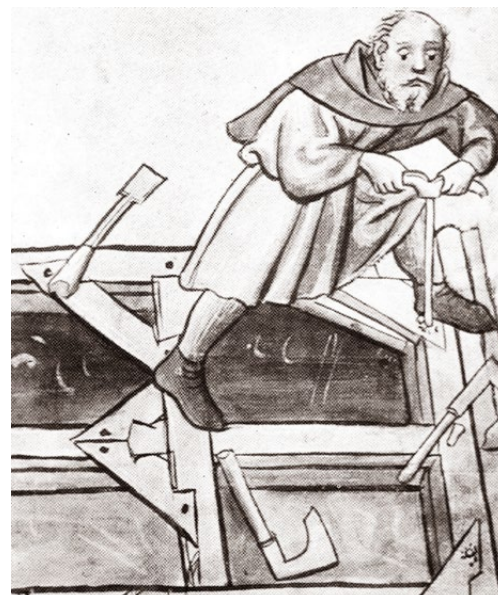
Il. 47 Plac ciesielski w średniowieczu. Rycina z XV w. (H.T. Schadwinkel, G. Heine, Das Werkzeug des Zimmermans , Hannover 1986, Abb. 409)
