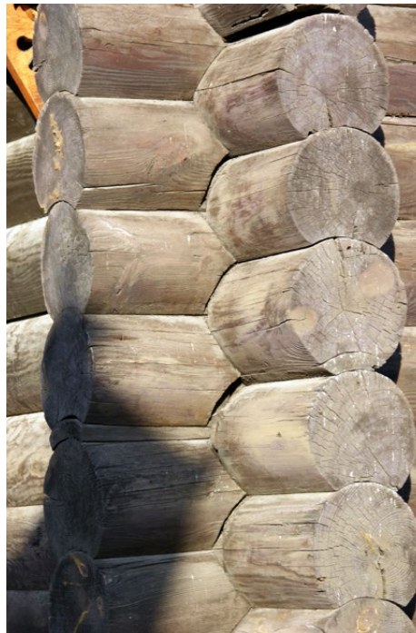
Il. 160 Poczdám Aleksandrówka, konstrukcja wieńcowa z okrągłaków w osiedlu domów w stylu rosyjskim, początek XIX w. (fot. U. Schaaf, 2020)
