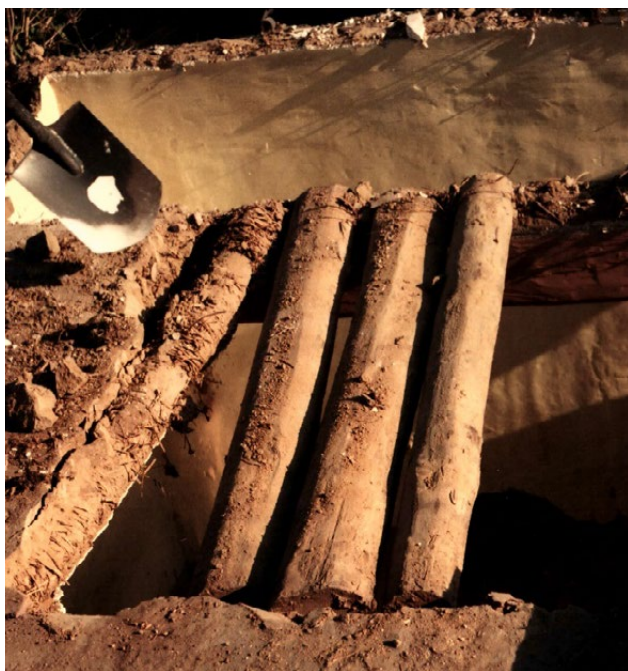
Il. 143 Oski Piec, dom z około 1880 r. Polepa stropu wykonana ze szczap owiniętych gliną z siczką, położonych na górnej stronie belek wiązarowych (fot. M. Hawryszków, 2011)
