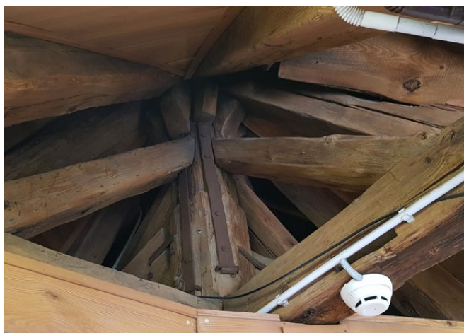
Il. 20 Toruń, wieża Ratusza Staromiejskiego. Konstrukcja zadaszenia, lata 20. XVIII w. (fot. M. Prarat, 2021)
