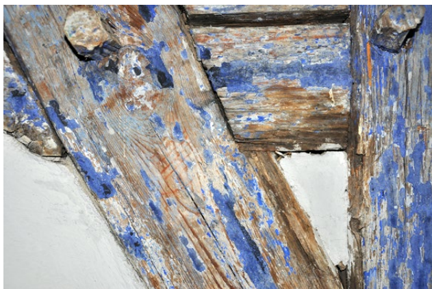
Il. 62 Jawor, kościół Pokoju z 1654–1656 r. Ciesielskie znaki montażowe narysowane sangwiną na powierzchni drewna (fot. U. Schaaf, 2019)
