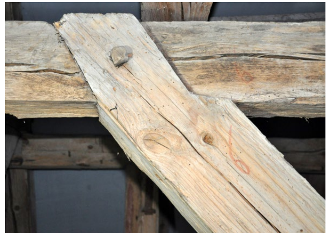
Il. 69 Świerzno, kościół pw. Św. Trójcy z lat 80. XVII w. Więźba dachowa, ciesielskie znaki montażowe w formie cyfr arabskich (fot. U. Schaaf, 2020)
