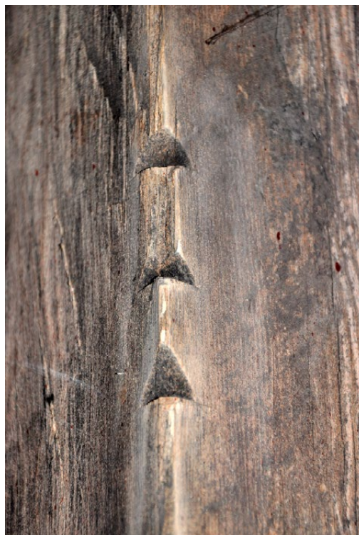
Il. 73 Toruń, kościół pw. św. Janów. Więźba dachowa z lat 30. XV w., ciesielski znak montażowy na krawędzi elementu (fot. U. Schaaf, 2018)
