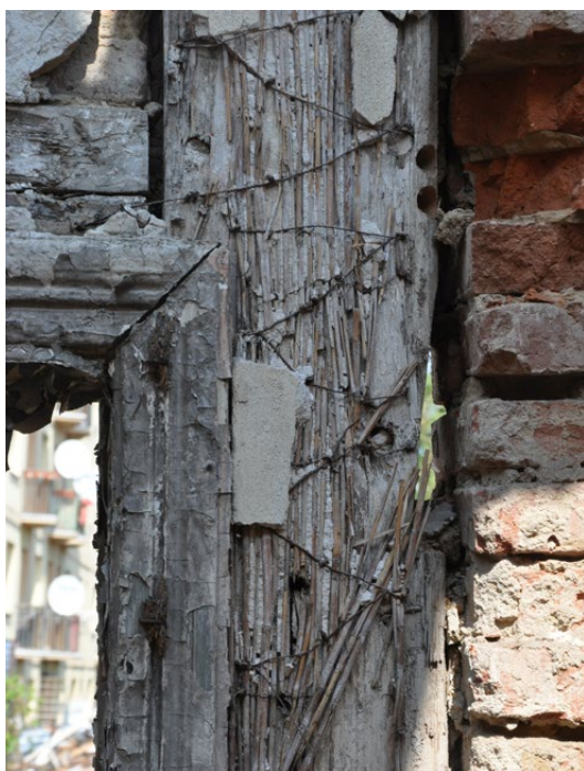
Il. 149 Kutno, pałac podróżny Augusta III z 1750 r. Druły trzymające trzcinę z tynkiem (fot. U. Schaaf, 2017)
