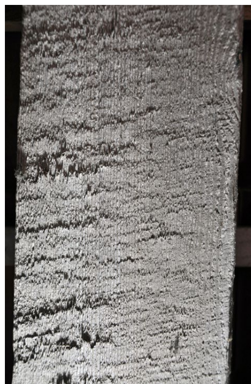
Il. 114 Toruń, kościół pw. NMP. Więżba nad nawą główną, jętkowa o mieszanym systemie konstrukcyjnym. Element obrobiony za pomocą piły ramowej lub kłódowej (fot. U. Schaaf, 2021)
