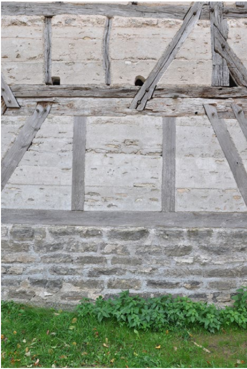
Il. 132 Muzeum na wolnym powietrzu Bad Windsheim. Wypełnienia z kamienia łamanego z gipsu (fot. U. Schaaf, 2018)
