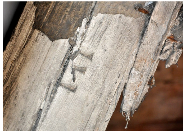
Il. 77 Toruń, kamienica na ul. Mostowej 6. Więźba dachowa z połowy XVI w. Ta sama konstrukcja więźby jak na il. 76. Dodatkowy system ciesielskich znaków montażowych o formie narastającej liczby trójkątnych nacięć po stronie lewej konstrukcji (fot. U. Schaaf, 2018)
