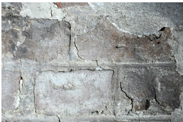
Il. 153 Świerzno, kościół szkieletowy z 1681 r. Eksponowane lico ceglane, które zostało wtórnie otynkowane (fot. U. Schaaf, 2020)
