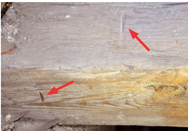
Il. 72 Toruń, kościół pw. NMP. Więźba dachowa z końca XVIII w., element podwójnie oznaczony ciesielskimi znakami montażowymi (fot. U. Schaaf, 2020)
