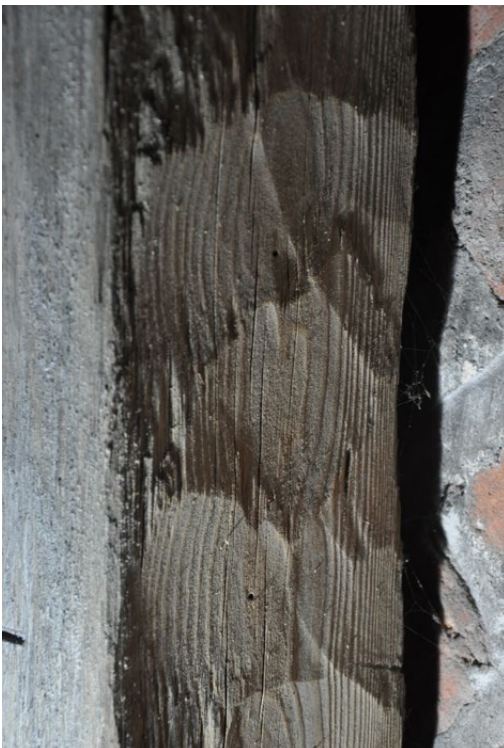
Il. 99 Toruń, kościół pw. św. Jakuba. Więźba dachowa nad nawą północną, widoczne ślady po obróbce toporem motykowatym (fot. U. Schaaf, 2020)
