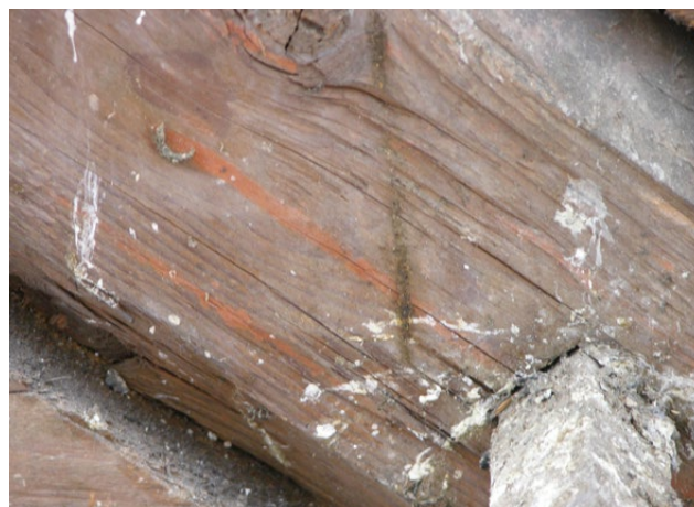
Il. 96 Jelenia Góra-Cieplice, kościół Zbawiciela, 1774–1779 r. Widoczne linie wykonane sznurem traserskim oznaczające funkcję elementu budowlanego (fot. U. Schaaf, 2017)
