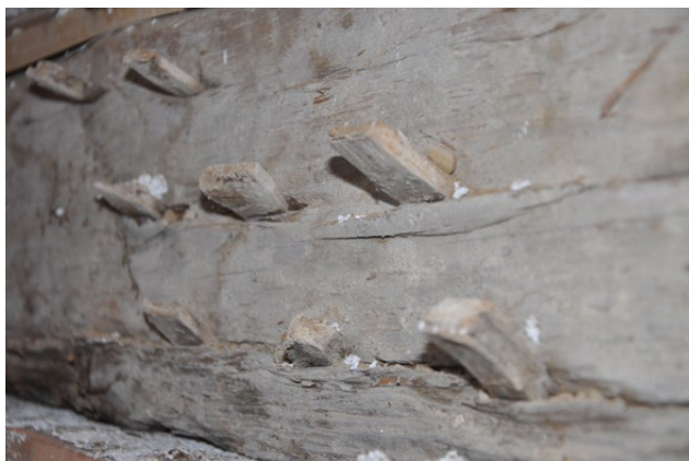
Il. 147 Lubiechnia Mała, kościół Podwyższenia Krzyża Świętego z końca XVII w. Małe kliny wbite w elementy drewniane szkieletu dla uzyskania lepszej przyczepności tynku (fot. U. Schaaf, 2017)
