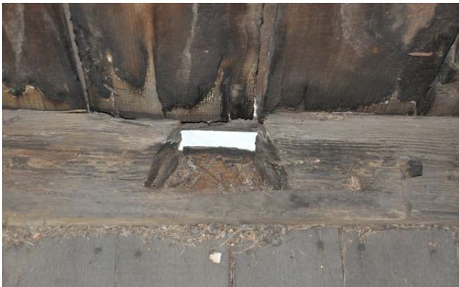
Il. 176 Szczerców, kościół z 1516–1517 r. (obecnie kaplica cmentarna). Gniazdo po jaskółczym ogonie w skrajnej belce wiązarowej po zaczepie (fot. U. Schaaf, 2019)
