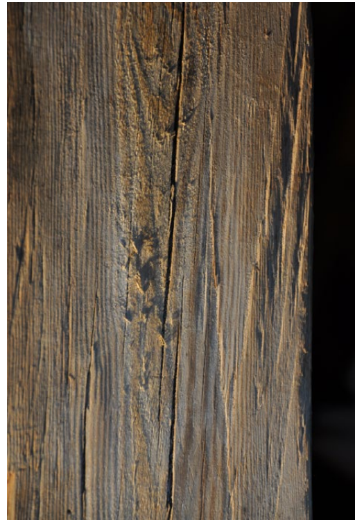
Il. 98 Toruń, kościół pw. św. Janów. Więźba dachowa nad nawą północną, lata 30. XV w. Widoczne ślady po obróbce toporem (fot. U. Schaaf, 2019)
