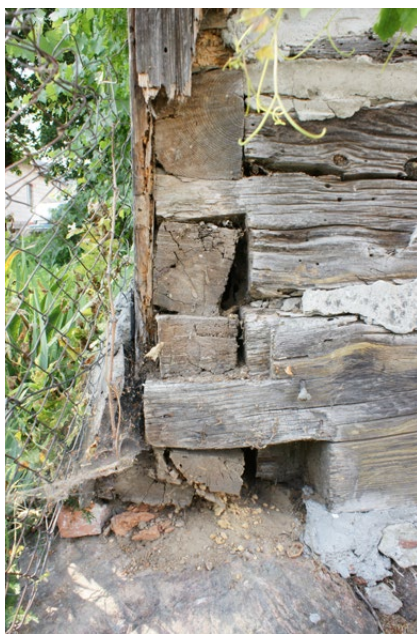
Il. 183 Niedźwiedz, zagroda z końca XVIII w. Częściowo wtórne podwaliny połączone na prostą nakładkę (fot. M. Prarat, 2008)
