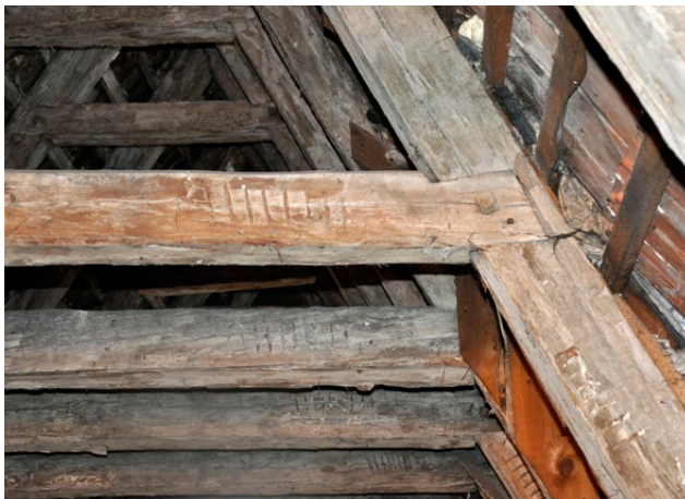
Il. 76 Toruń, kamienica na ul. Mostowej 6. Więźba dachowa z połowy XVI w. System ciesielskich znaków montażowych w formie narastającej liczby nacięć po prawej stronie konstrukcji więźby na jętce i krokwi (fot. U. Schaaf, 2018)
