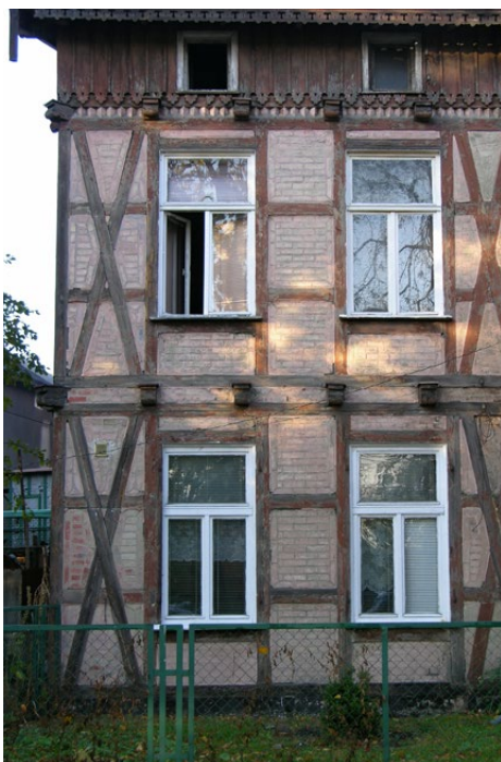
Il. 138 Toruń, ul. Bydgoska. Budynek w konstrukcji szkieletowej z wypełnieniem pól szkieletu ceglami w układzie dekoracyjnym (fot. U. Schaaf, 2005)
