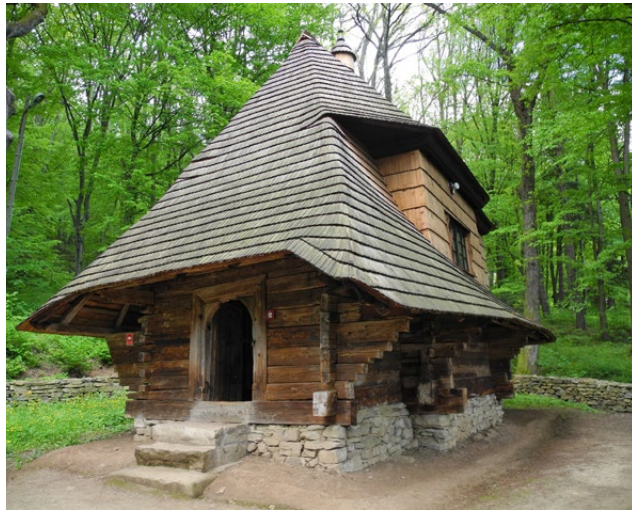
Il. 28 Muzeum Budownictwa Ludowego w Sanoku. Wieńcowa cerkiew z Rosolina, 1750 r. (fot. M. Prarat, 2018)
