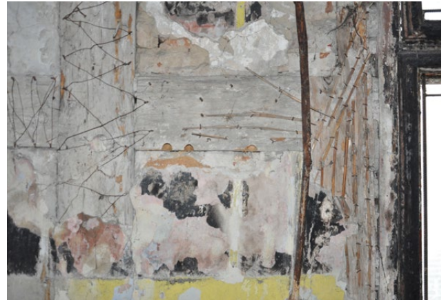
Il. 150 Kutno, pałac podróżny Augusta III z 1750 r. Druły przybite gwoździami do konstrukcji, na które nałożono tynk (fot. U. Schaaf, 2017)
