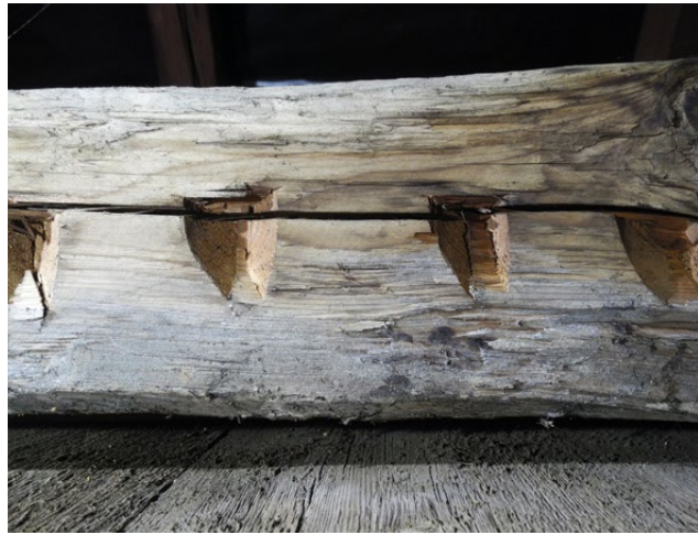
Il. 133 Jawor, kościół Pokoju z 1654–1656 r. Osadzenie szczap w pojedynczych nacięciach elementów poziomych (fot. U. Schaaf, 2019)
