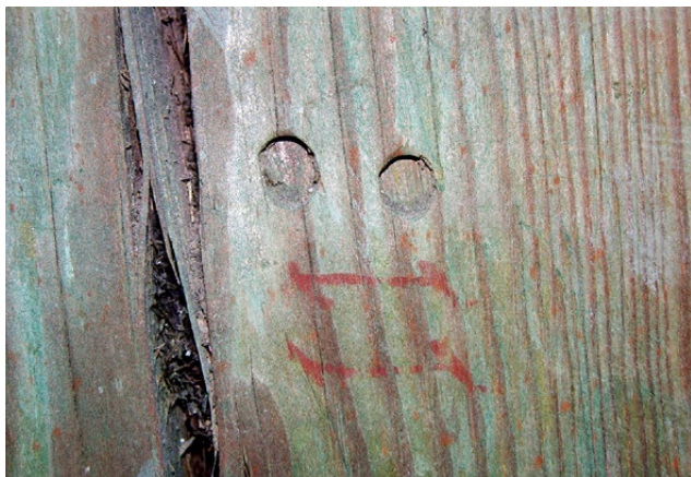
Il. 64 Rościszewice, kościół Podwyższenia Krzyża Świętego z początku XVIII w. Element konstrukcji oznaczony podwójnie – dłutem i sangwiną (fot. U. Schaaf, 2009)
