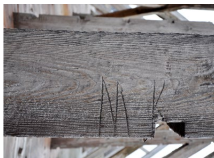
Il. 85–89 Ciechocinek, tężnia nr 3 z 3. ćwierci XIX w. Znaki handlowe na elementach konstrukcji (fot. U. Schaaf, 2021)
