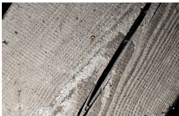
Il. 115 Toruń, kościół pw. NMP. Więżba nad nawą główną, jętkowa o mieszanym systemie konstrukcyjnym. Element obrobiony za pomocą traku mechanicznego (fot. U. Schaaf, 2021)
