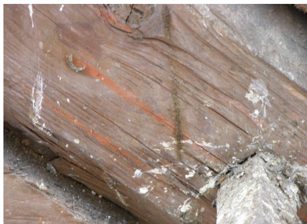
Il. 96 Jelenia Góra-Cieplice, kościół Zbawiciela, 1774–1779 r. Widoczne linie wykonane sznurem traserskim oznaczające funkcję elementu budowlanego (fot. U. Schaaf, 2017)
