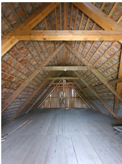
Il. 33 Ołęderski Park Etnograficzny w Wielkiej Nieszawce. Spichlerz z Wielkiego Zajączkowa, przetom XVIII i XIX w. Więźba dachowa jednojętkowa (fot. M. Prarat, 2021)
