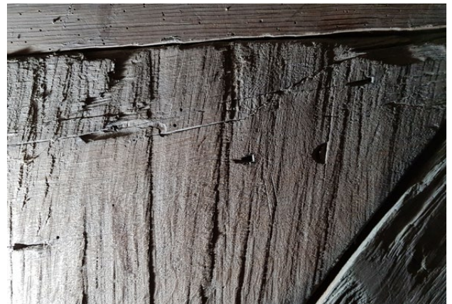
Il. 100 Świerzno, kościół pw. Świętej Trójcy z lat 80. XVII w. Fragment rygla obrobionego piłą ręczną (fot. M. Prarat, 2021)
