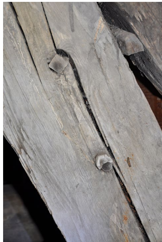
Il. 123 Toruń, kościół pw. św. Janów. Więźba dachowa nad nawą południową z lat 30. XV w. Widoczne dwa kliny ze śrykówką po splewicie w krokwi (fot. U. Schaaf, 2021)
