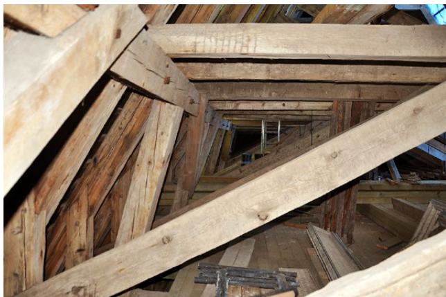
Il. 46 Kamiń Pomorski, katedra. Więzba nad nawą z połowy XIV w. Wtórna konstrukcja o stolcach leżących z 3. ćwierci XIX w. (fot. U. Schaaf, 2021)
