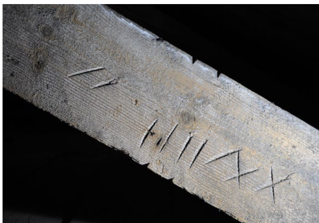
Il. 71 Leszno, kościół pw. św. Krzyża z przełomu XVIII i XX wieku. Znak liczbowy wiązara – XXVIII, przyznak dla strony prawej – dwie skośne kreski, przyznaki wysokościowe – narożne trójkątne nacięcia (fot. U. Schaaf, 2017)
