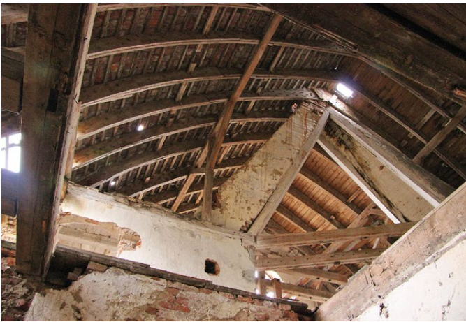
Il. 39 Drogosze, więźba krążynowa w budynku gospodarczym, XIX w. (fot. M. Prarat, 2014)
