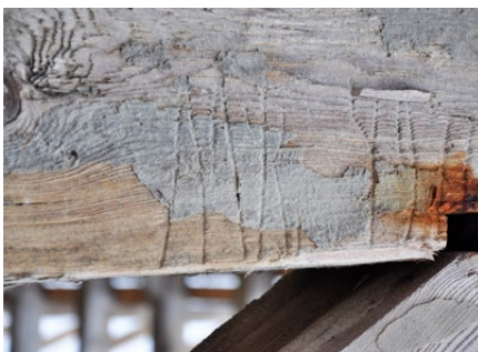
Il. 85–89 Ciechocinek, tężnia nr 3 z 3. ćwierci XIX w. Znaki handlowe na elementach konstrukcji (fot. U. Schaaf, 2021)
