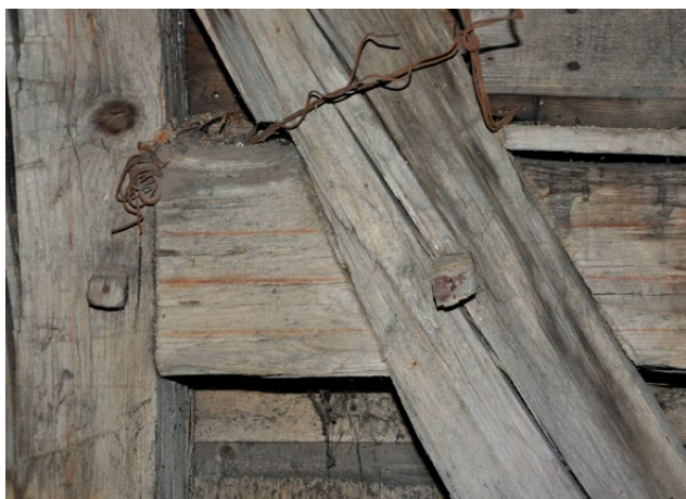
Il. 95 Jawor, kościół Pokoju z 1654–1656 r. Widoczne linie wykonane sznurem traserskim oznaczające przeznaczenie elementu budowlanego (fot. U. Schaaf, 2018)
