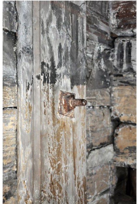
Il. 177 Szczerców, kościół z 1516–1517 r. (obecnie kaplica cmentarna). Pionowe bale (tzw. lisice) służące do zabezpieczenia ścian wieńcowych (fot. U. Schaaf, 2019)
