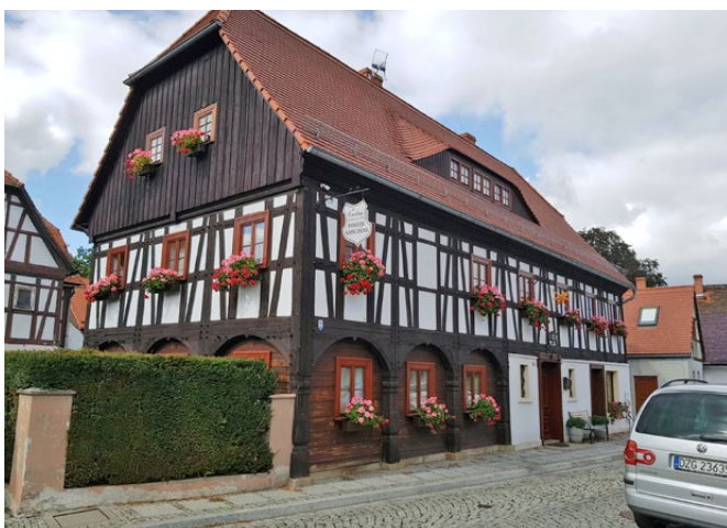
Il. 31 Bogatynia, budynek w konstrukcji przysłupowej (fot. M. Prarat, 2019)
