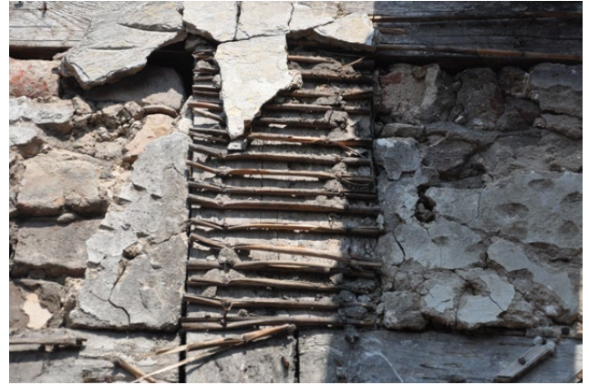
Il. 148 Kutno, pałac podróżny Augusta III z 1750 r. Gwoździe trzymające trzcinę z tynkiem (fot. U. Schaaf, 2017)
