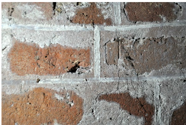
Il. 151 Świerzno, kościół szkieletowy z 1681 r. Eksponowane lico ceglane z opracowaną i pomalowaną na biało spoiną (fot. U. Schaaf, 2020)
