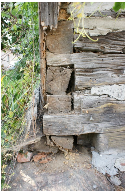
Il. 183 Niedźwiedz, zagroda z końca XVIII w. Częściowo wtrone podwaliny połączone na prostą nakładkę (fot. M. Prarat, 2008)
