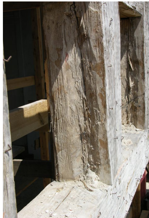
Il. 135 Rościśławice, kościół Podwyższenia Krzyża Świętego z początku XVIII w. Wyżłobienie boków słupów dla lepszego oparcia i zabezpieczenia wypełnień w polach (fot. U. Schaaf, 2009)
