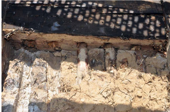
Il. 158 Niedziejewo, kościół pw. św. Andrzeja Apostoła z 1753 r. Wypełnienie gliniane na żerdziach pół szkieletu (fot. U. Schaaf, 2020)
