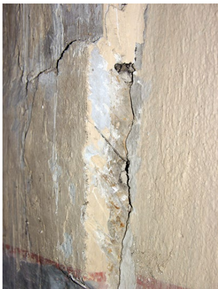
Il. 58 Lubiechnia Mała, kościół Podwyższenia Krzyża Świętego z końca XVII w. Widoczna obcięta nakładka po mieczu poniżej belkowania obecnej empory (fot. U. Schaaf, 2017)
