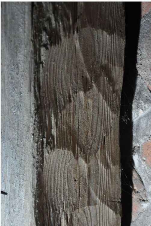
Il. 99 Toruń, kościół pw. św. Jakuba. Więźba dachowa nad nawą północną, widoczne ślady po obróbce toporem motykowatym (fot. U. Schaaf, 2020)
