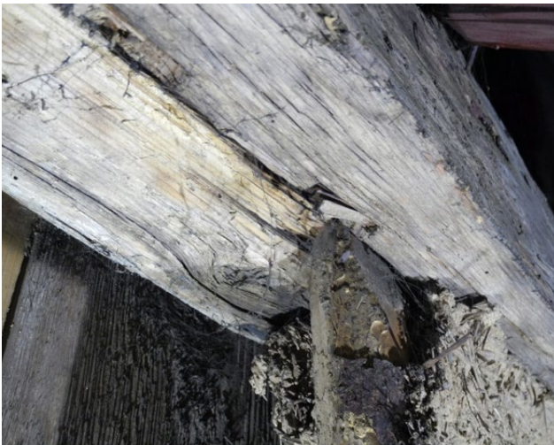
Il. 134 Jawor, kościół Pokoju z 1654–1656 r. Osadzenie szczap w podłużnych nacięciach (fot. U. Schaaf, 2019)
