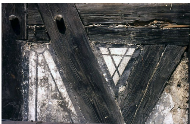
Il. 155 Świdnica, kościół pw. św. Trójcy z 1656–1657 r. Opracowanie kolorystyczne – szaroczarny kolor nachodzący na biały tynk (fot. U. Schaaf, 2005)
