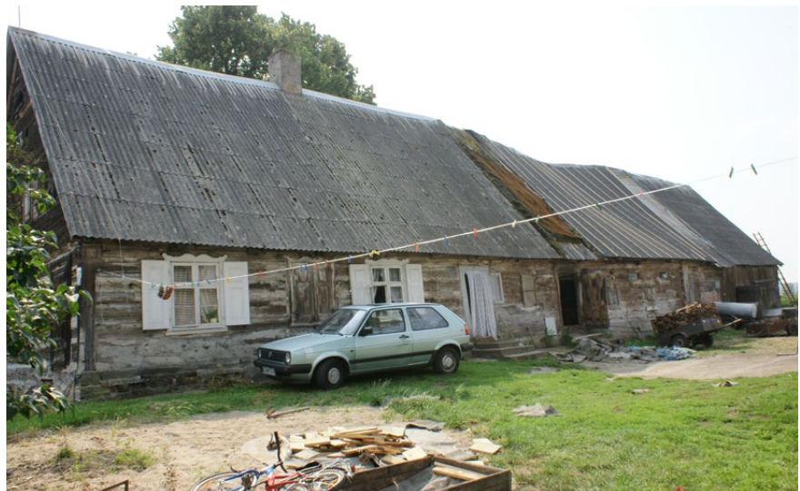
Il. 183 Niedźwiedz, zagroda z końca XVIII w. Częściowo wtrone podwaliny połączone na prostą nakładkę (fot. M. Prarat, 2008)
