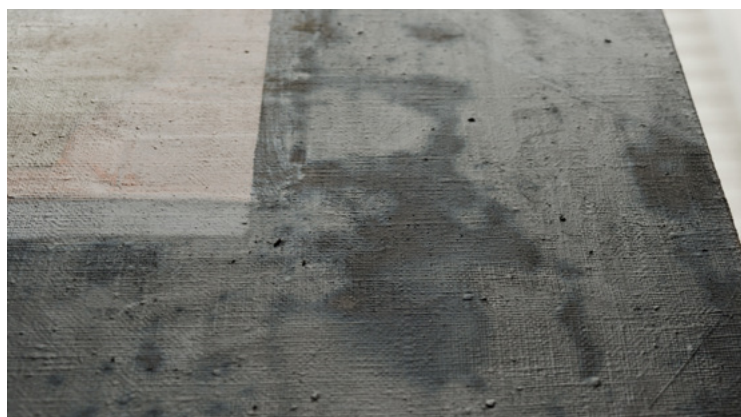
il. 1 Przykład obrazu o dużych nierównościach w połysku powierzchni spowodowanych nierównomierną chłonnością podłoża
