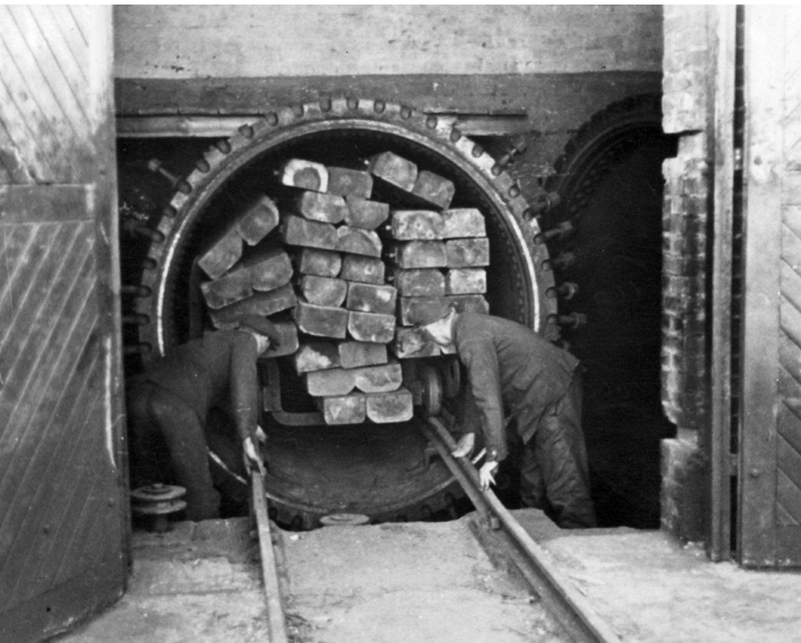
Robotnicy podczas pracy w zakładzie impregnacji drewna w powiecie Ostrów Mazowiecka. Wyjmują zaimpregnowane podkłady kolejowe z kotła. 1942 r. Fot. Steimer/NAC
