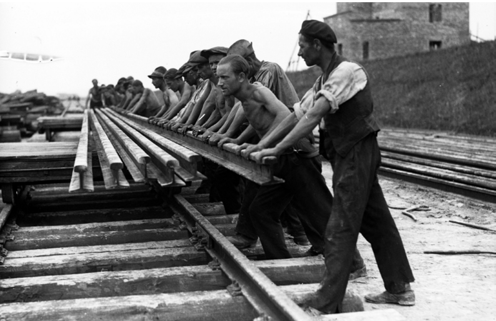
Robotnicy podczas ładowania szyn na dreźny kolejowe, które dowożą je na koniec trasy. Budowa linii kolejowej Kraków-Miechów, 1934 r. Fot. NAC
