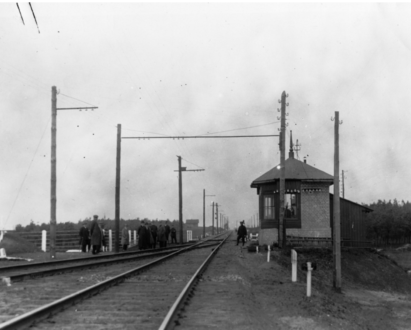
Urządzenie zapobiegające zderzeniu pociągów. Plant kolejowy pod stacją Maczki ze specjalnymi przewodami elektrycznymi, automatycznie wstrzymującymi pociągi biegnące po tym samym torze, 1926 r. Fot. NAC
