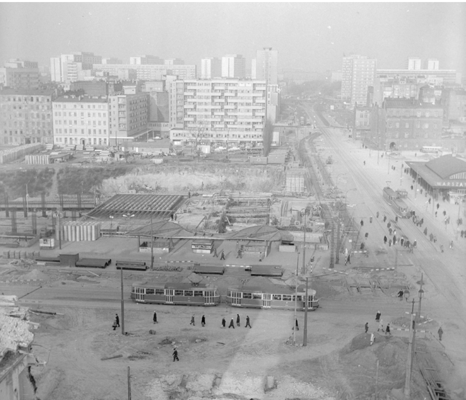
Plac budowy przy dworcu WKD Warszawa-Śródmieście, 1974 r. Fot. Grażyna Rutkowska / NAC
