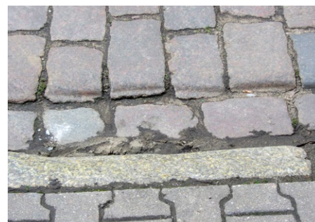
56 Poznań, ulica Mielżyńskiego. Ścięte kostki kamienne przy ścieku (zdjęcie sprzed remontu). Fot. Andrzej Billert
