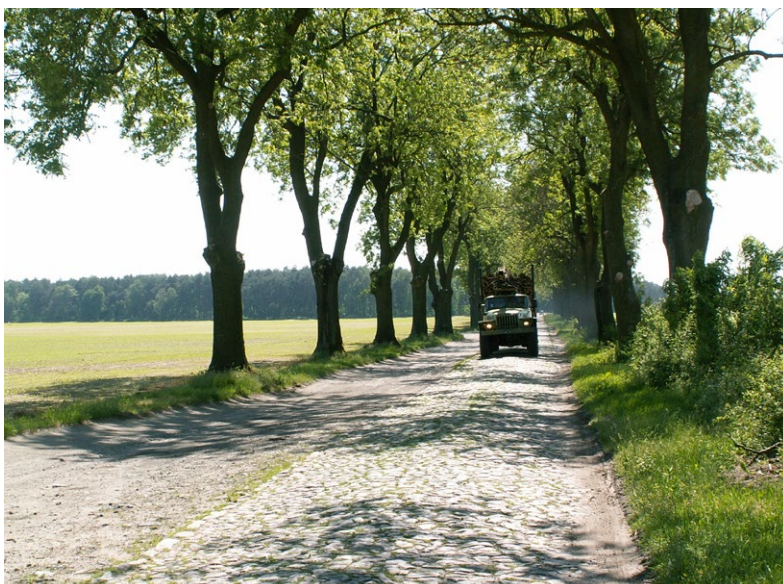
70 Okolice Jabłkowa (Wielkopolska). Drogi brukowe nie były przewidziane do ruchu ciężarowego. Fot. Andrzej Billert
