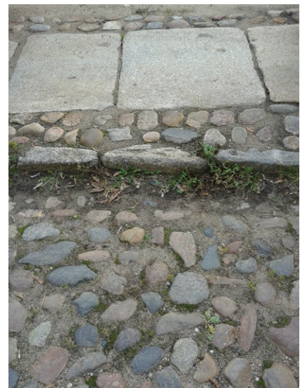
34 Poznań, ulica Skośna. Chodnik z płyt kamiennych i obustronnym pasem z otoczaków oraz krawężnikiem z podłużnych kamieni. Fot. Andrzej Billert
