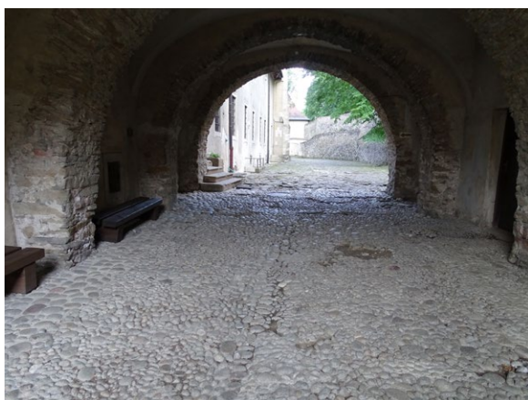
7 Słowacja, Czerwony Klasztor. Bruk z małych otoczków prawie równej wielkości, ułożonych bardzo ściśle, przypomina drobne, misternie układane elementy biżuterii. Fot. Andrzej Billert
