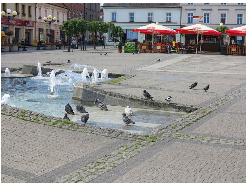
18 Mikołów, rynek. Współczesna nawierzchnia placu wykonana z kostki betonowej i granitowej. Przykład doboru ahistorycznego materiału nawierzchni (płyty), niespójnej z charakterem placu, asymetrycznej i ostro zarysowanej kompozycji oraz niewłaściwego wprowadzania ahistorycznych form fontanny. To wszystko skutkuje zniekształceniami przekroju placu i chaosem przestrzennym. Fot. A. Olczyk, 2016
