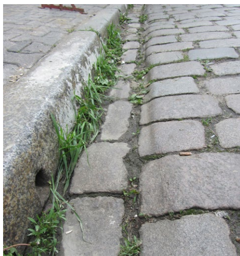
56 Poznań, ulica Mielżyńskiego. Ścięte kostki kamienne przy ścieku (zdjęcie sprzed remontu). Fot. Andrzej Billert
