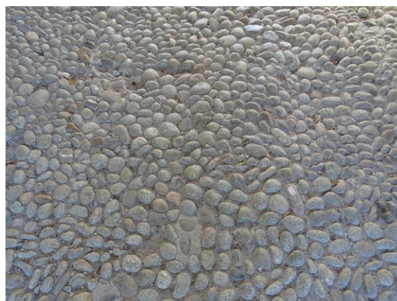
7 Słowacja, Czerwony Klasztor. Bruk z małych otoczków prawie równej wielkości, ułożonych bardzo ściśle, przypomina drobne, misternie układane elementy biżuterii. Fot. Andrzej Billert
