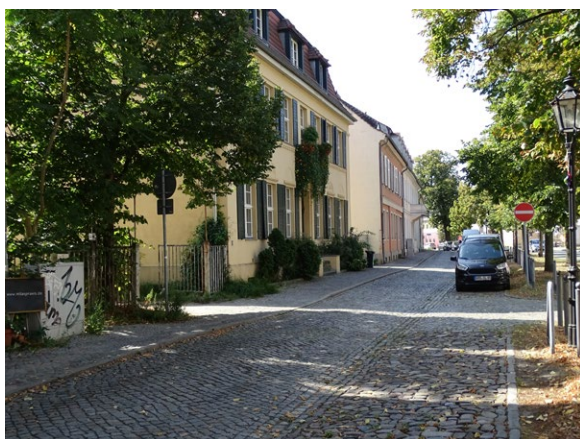
6 Niemcy. Połączenie kostki kamiennej na jezdni z brukiem z kamieni polnych na miejscach postojowych w Brandenburgiu (a) i Frankfurcie nad Odrą (b). Fot. Andrzej Billert
