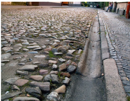
42 Paczków, powiat nyski. Ścieki. Fot. Andrzej Billert
