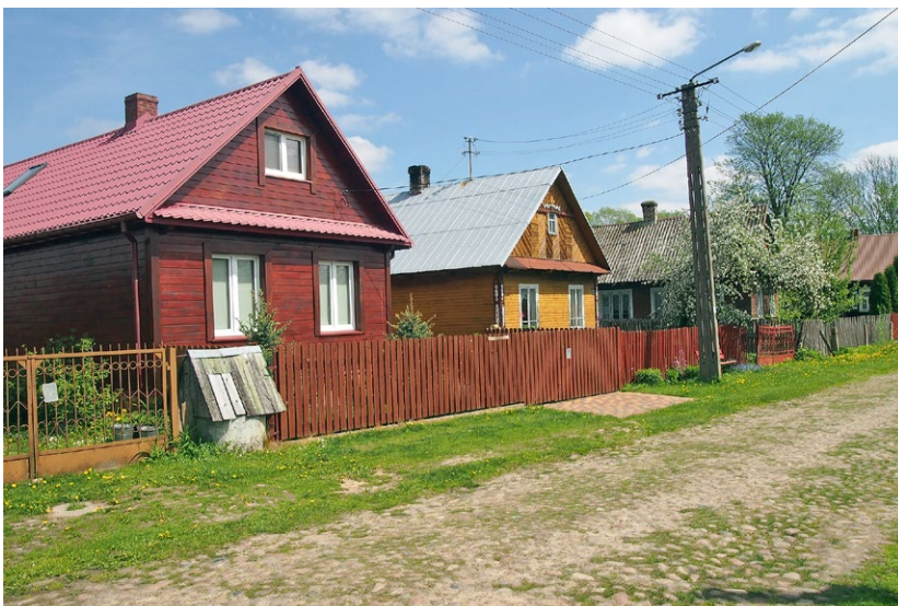
20 Soce. Droga brukowana kamieniem polnym w historycznym układzie ruralistycznym. W wyniku przeprowadzonej współcześnie modernizacji bruk zastąpiono szarą kostką betonową, co poskutkowało całkowitą utratą walorów zabytkowych i znacznym uszczerbkiem na zabytkowej wartości układu ruralistycznego. Fot. OT NID Białystok, 2005
