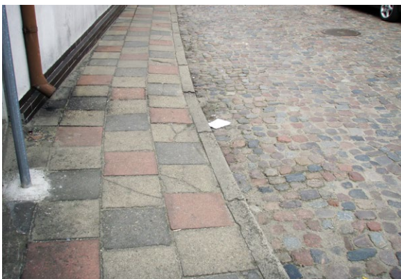
41 Gostyń. Kolorowe płytki chodnikowe. Rodzaj nawierzchni jest tu raczej typowy – płytki betonowe – ale nietypowa jest kolorystyka nawiązująca do przyległej nawierzchni jezdni z kamieni polnych. Fot. Andrzej Billert
