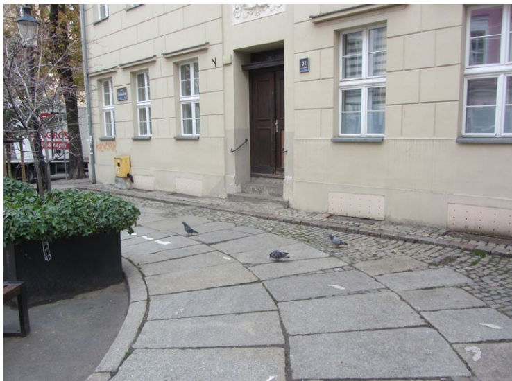
33 Poznań, ulica Żydowska. Chodnik z płyt kamiennych ułożonych bezpośrednio przy krawężniku. Fot. Andrzej Billert
