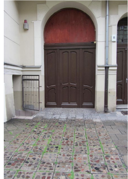
27 Poznań, ulica Poplińskich. Zjazd na posesję z płyt kamienno-betonowych. Fot. Andrzej Billert
