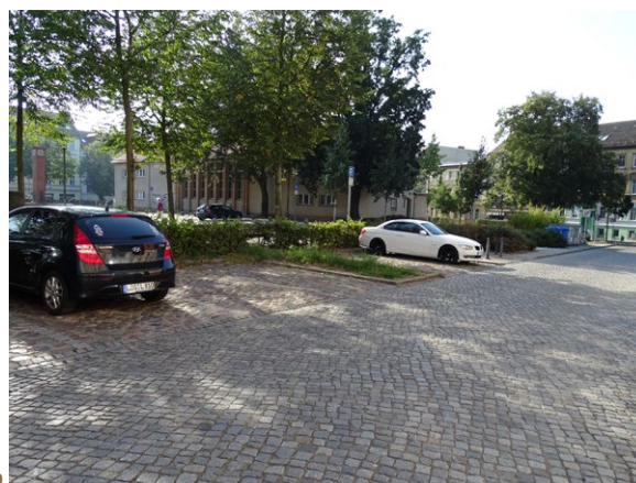
6 Niemcy. Połączenie kostki kamiennej na jezdni z brukiem z kamieni polnych na miejscach postojowych w Brandenburgiu (a) i Frankfurcie nad Odrą (b). Fot. Andrzej Billert
