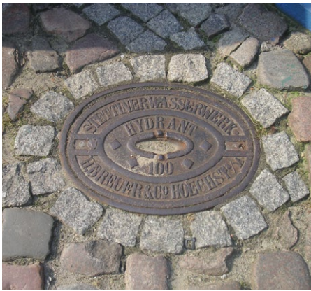
62 Szczecin, ulica Księcia Mściwoja II. Żeliwna pokrywa zaworu. Źródło: Fridolin freudenfett/Wikimedia Commons (CC BY-SA 4.0)
