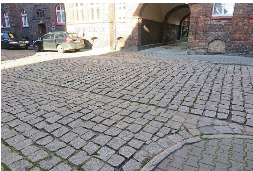
19 Katowice, osiedle Nikiszowiec. Współczesna nawierzchnia ulicy z nieregularnej kostki granitowej, ułożonej prostopadle do osi jezdni, z obsadzką oraz pasami chodnikowymi z kostki betonowej i wyodrębnionymi granitowymi krawężnikami. Przykład naśladownictwa polegającego na wprowadzeniu nowej nawierzchni, spójnej z charakterem wnętrza urbanistycznego, na podstawie zachowanych materiałów ikonograficznych (typ, kolor materiału), z odtworzeniem przekroju ulicy (wypukły przekrój pasa jezdni, obsadka/rynsztok, wyodrębnienie chodników za pomocą krawężników). Fot. A. Olczyk, 2020
