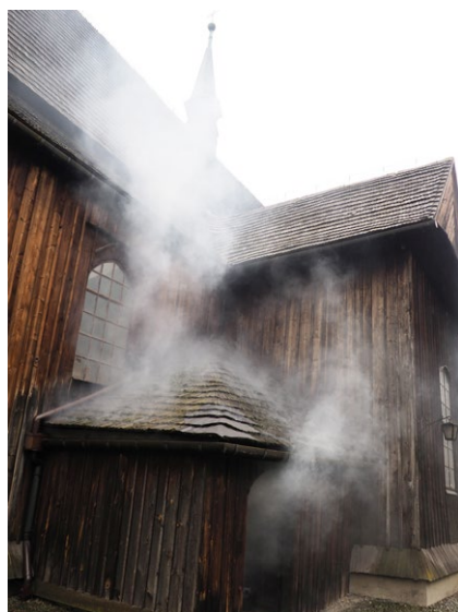
Stałe urządzenie gaśnicze mgłowe w działaniu. Fot. K. Kociółek
