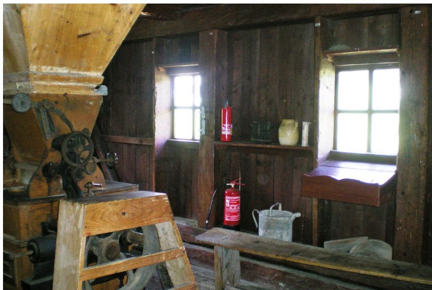
Gaśnice ulokowane w drewnianym budynku. Niestety zapomniano o ich oznakowaniu. Fot. K. Kociotek
