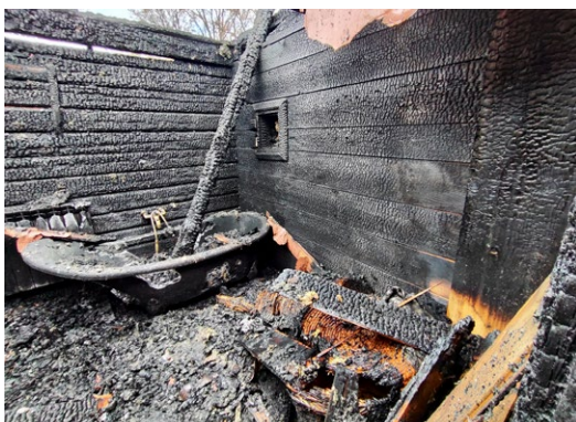
Dla porównania zniszczenia po pożarze w pomieszczeniu z wyposażeniem z materiałów naturalnych (z lewej) i w pomieszczeniu, gdzie znajdowała się plastikowa wanna (z prawej). Fot. E. Graboś
