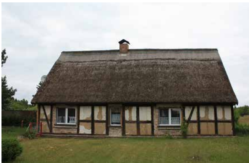
Budynek po usunięciu okładziny elewacyjnej
