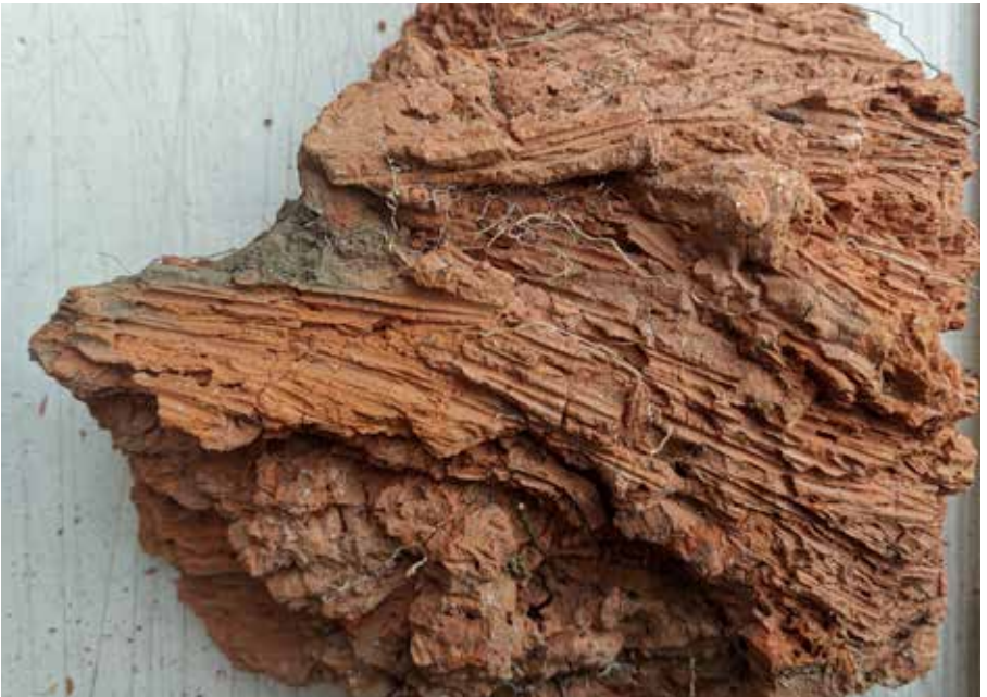
Fragment glinianego wypełnienia ściany ryglowej, które uległo wypaleniu w trakcie pożaru, fot. T. Cykalewicz Bruchstück einer Fachwerkfüllung aus Lehm, das beim Brand ausgehärtet ist. Aufn. T. Cykalewicz
