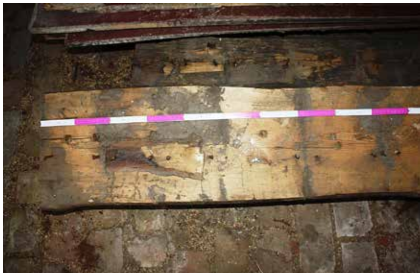
Drewno podłogowe z pozostałościami po gwoździach ze starych desek podłogowych Lagerholz des Fußbodens mit Holznagelresten der alten Dielen
