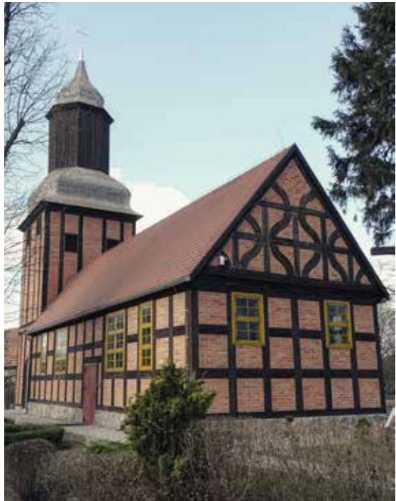
Kirche in Klein Mellen: vor und nach den denkmalpflegerischen Arbeiten
