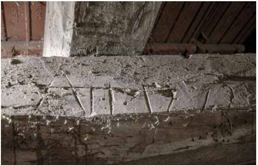
Fot. 2. Kościół pw. Najświętszego Serca Pana Jezusa w Gorzycy, więźba dachowa, fragment ryglu z wyrytą datą „AD 1779” odnalezioną w trakcie zbierania wymiarów metodą tradycyjną, fot. M. Kumorowicz-Brzeska, 2022
