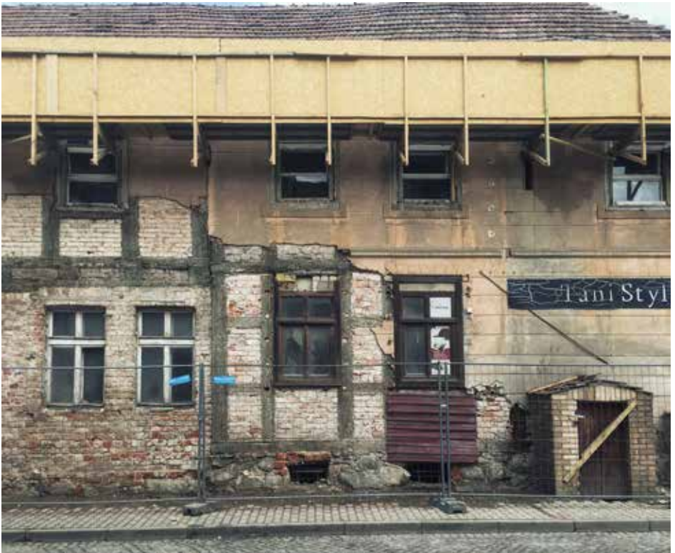
Fragment elewacji południowej budynku przy ul. Ratuszowej 11 w Myśliborzu, 2021
