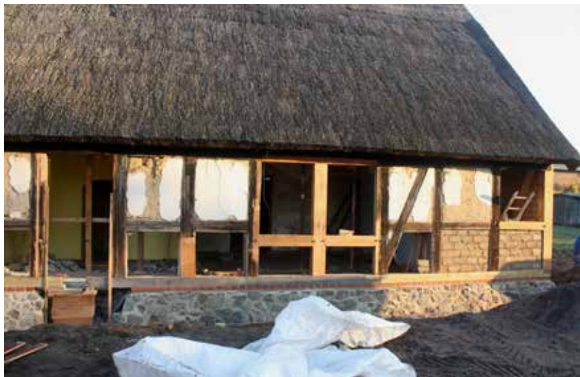
W trakcie remontu fragmentu elewacji ulicznej przywrócono starą konstrukcję okienną Während der Sanierung, Ausschnitt der Straßenfassade, die alte Fenstergliederung wurde wieder hergestellt
