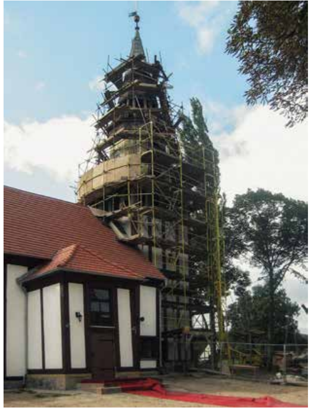
Kościół filialny w Janczewie w trakcie prac, 2005
