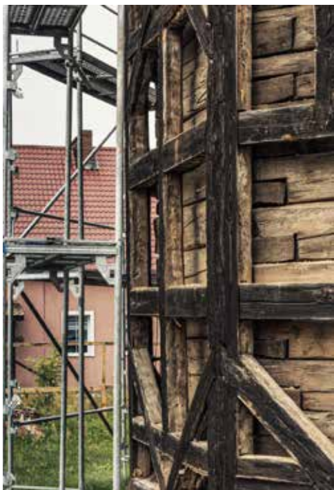
Kościół filialny w Kalsku w trakcie prac, 2021 Die Filialkirche in Kalzig (Kalsko) während der Arbeiten, 2021
