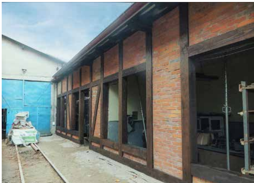
Lokomotywownia i hala napraw wagonów w Przeworsku Lokomotivdepot und Waggonreparaturhalle in Przeworsk
