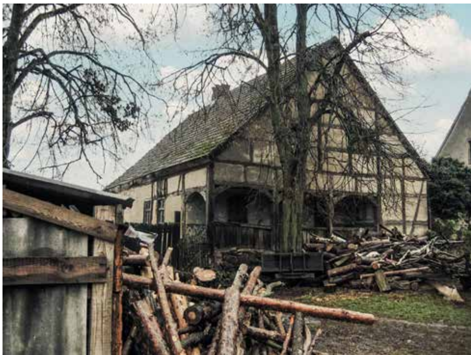
Chałupa podcieniowa z Lisowa przed rozpoczęciem prac, 2005
