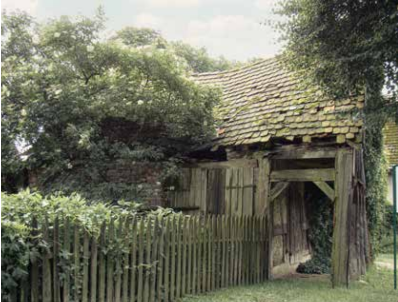
Kuźnia w Dolsku, przed pracami remontowo-konserwatorskimi i po nich, fot. W. Witek Schmiede in Dölzig: vor und nach den denkmalpflegerischen Arbeiten
