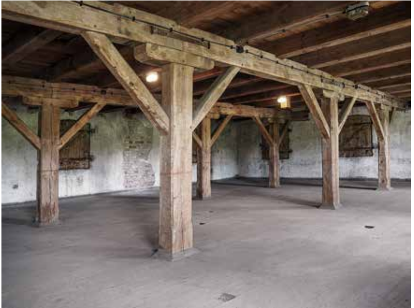
Fot. 1. Spichlerz, piętro, część magazynowa - rozwiązanie słupów wspierających podciąg, Lubicz Górny, fot. D. Jagiełło, 2022
