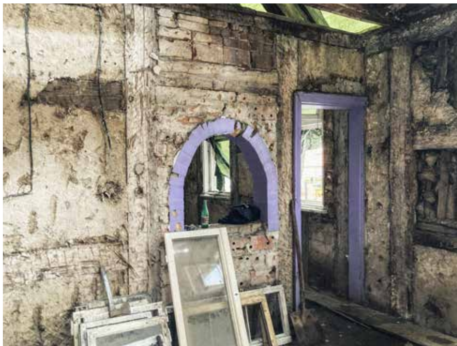
Widok wypełnień pół szkieletu ścian wewnętrznej i zewnętrznej w budynku przy ul. Rynek 2 w Myśliborzu, fot. M. Sokołowska, 2023.
