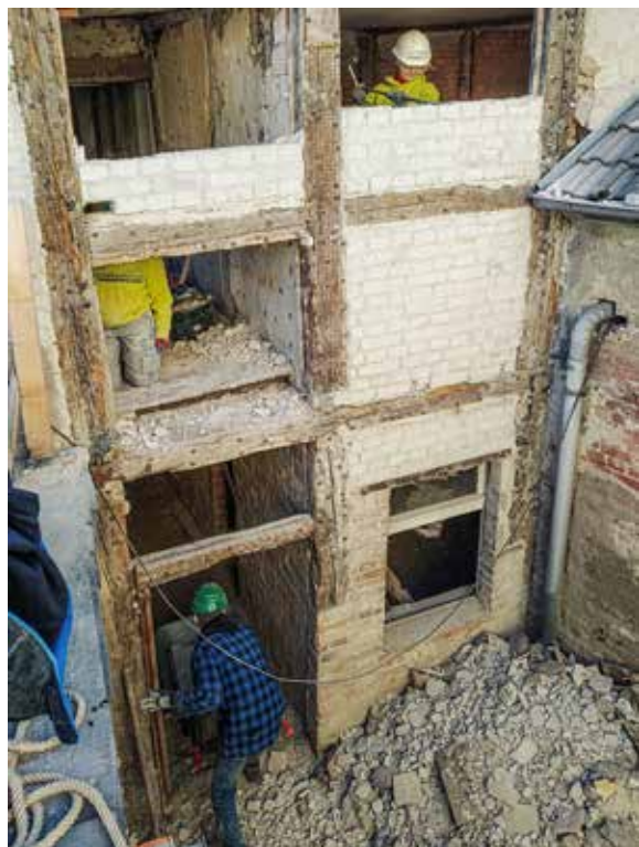
Podczas prac murarskich Beim Ausbau der Kalksandsteinausfachung
