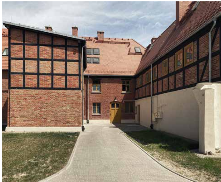
Widok elewacji zachodniej budynku przy ul. Ratuszowej 11 w Myśliborzu po pracach remontowych, 2023
