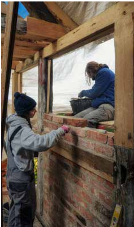
Budowanie ścian Beim Gefache mauern
