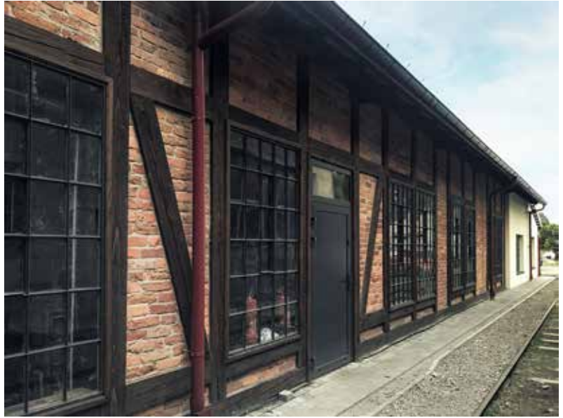
Lokomotywnia i hala napraw wagonów w Przeworsku Lokomotivdepot und Waggonreparaturhalle in Przeworsk
