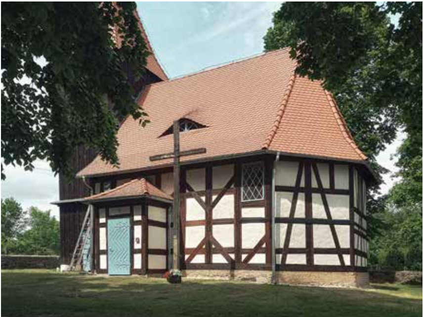
Kościół filialny w Lubiechni Małej po zakończeniu prac, 2022
