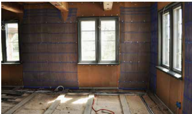
Termoizolacja oraz montaż instalacji grzewczej i elektrycznej, 2017 Thermoisolierung und Montage von Heiz- und Elektroinstallationen, 2017
