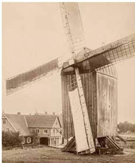
Dom podcieniowy w Mikoszewie, przy ul. Gdańskiej 55 (na drugim planie)
