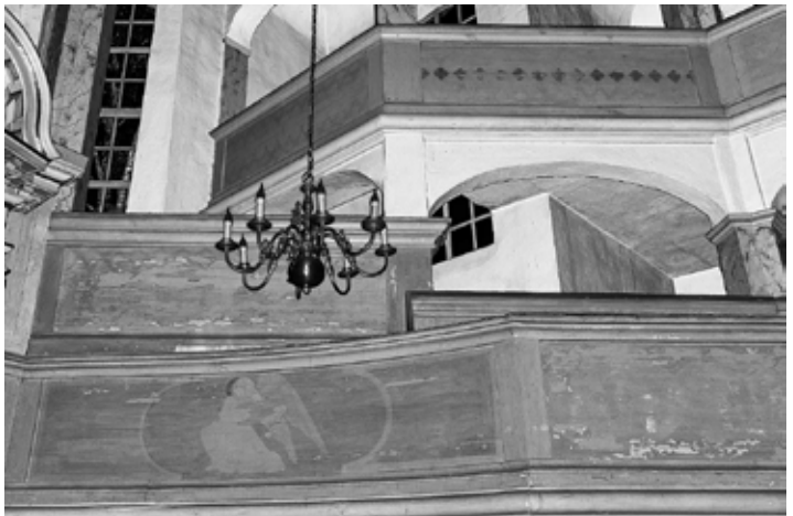
Kościół w Bieczu. Skan uwidaczniający nieistniejące polichromie Kirche in Beitzsch. Wärmebild einer bereits entfernten Polychromie.
