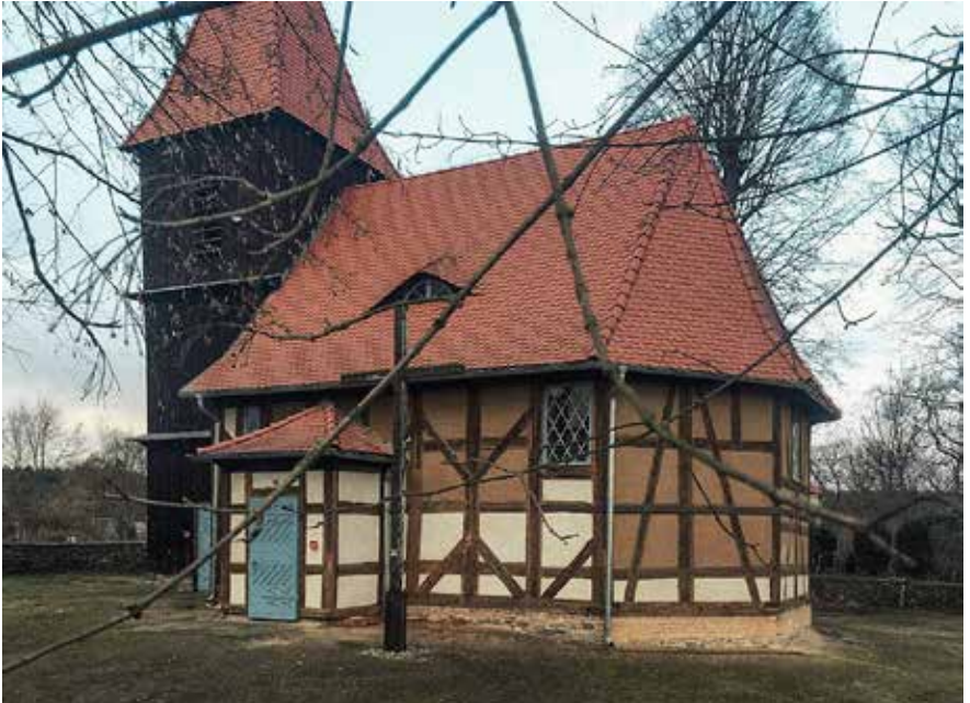
Kościół filialny w Lubiechni Małej w trakcie prac, 2020
