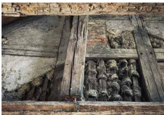
Widok wypełnień pół szkieletu ściany szczytowej w budynku przy ul. Rynek 2 w Myśliborzu, 2023
