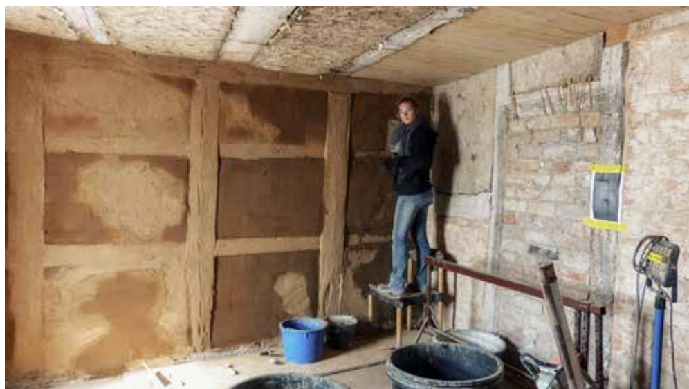
Tynkowanie Beim Lehmverputz
