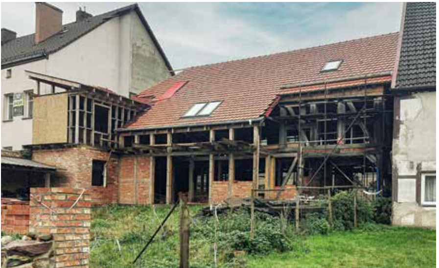
Stan obiektu, fot. T. Cykalewicz, listopad 2023
