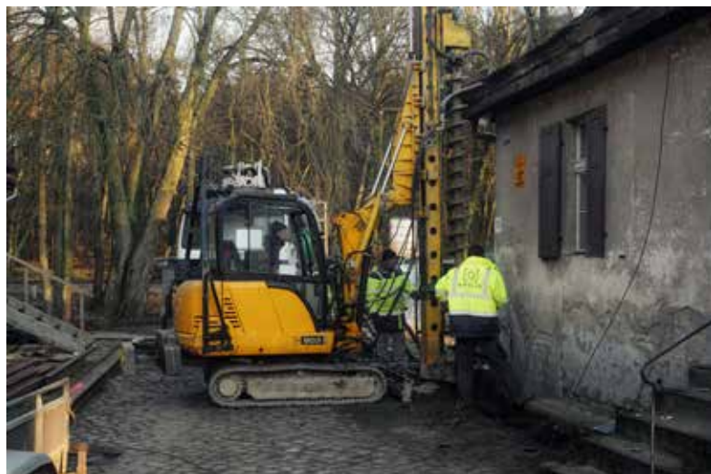
Barlinek, Młyn-Papiernia, ul. św. Bonifacego 37-39, roboty palowe: firma Solis, fot. T. Cykalewicz, 2017
