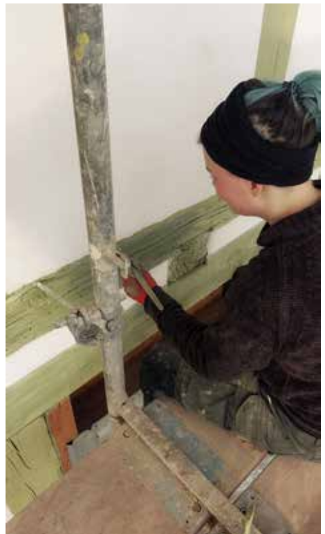
Malowanie konstrukcji zewnętrznej farbą olejną Anstrich des Außenfachwerks nach Befund mit Ölfarbe
