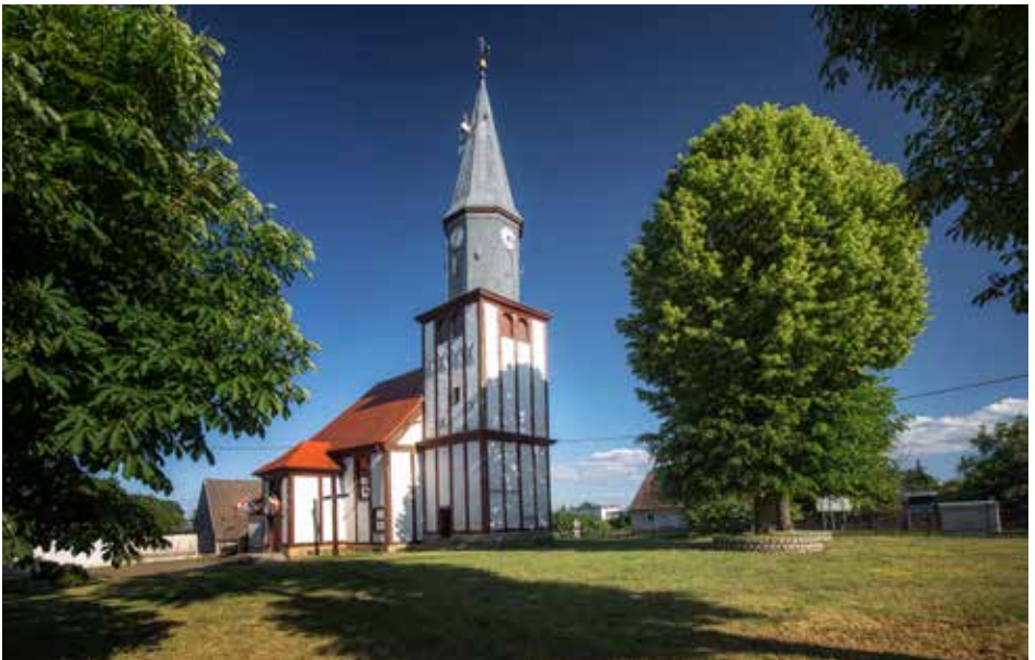
Kościół filialny w Janczewie po zakończeniu prac, 2006
