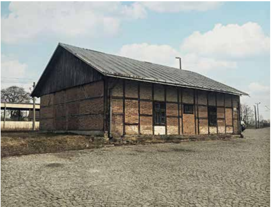
Lokomotywownia i hala napraw wagonów w Przeworsku Lokomotivdepot und Waggonreparaturhalle in Przeworsk
