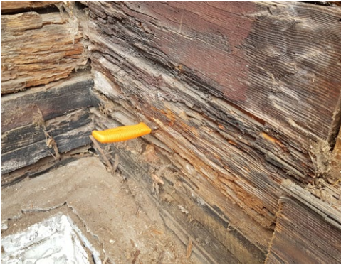
Badanie właściwości mechanicznych drewna konstrukcji ściany translokowanego obiektu
