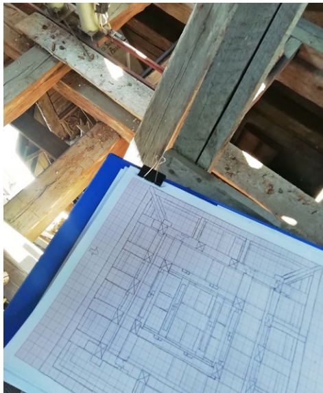
Pomiar konstrukcji drewnianej wykonany metodami tradycyjnymi
