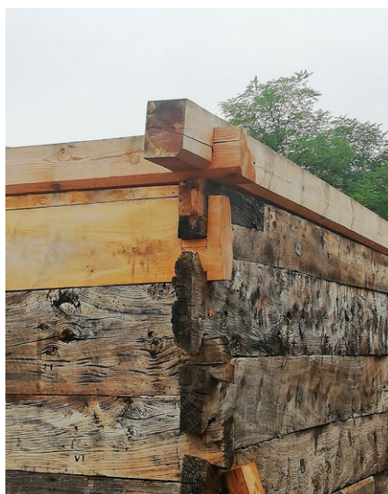
Odtworzenie zniszczonych bierwion ściany wieńcowej
