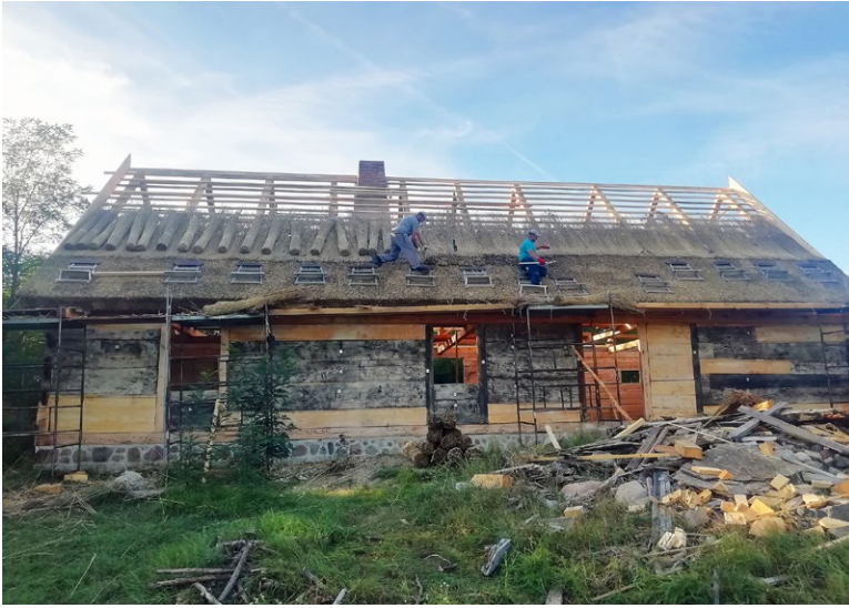
Montaż konstrukcji i pokrycia dachu
