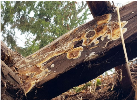
Krokwie zaatakowane przez grzyb – gnilicę oliwkową ( Coniophora olivacea )
