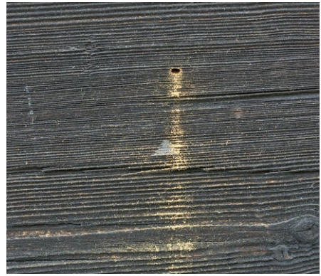
Mączka drzewna wysypująca się z otworu wyłotowego postaci imago spuszczela pospolitego ( Hylotrupes bajulus )
