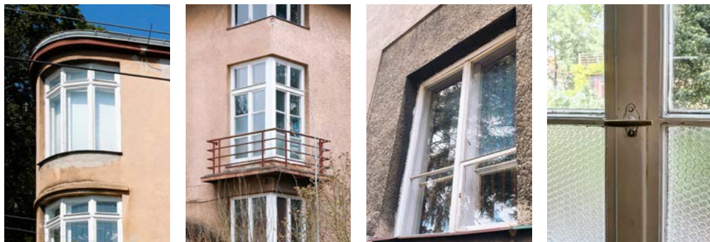
Okna narożne, przykład tradycyjnej stolarki i detal okucia
