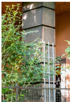
Detal z tynku kamieniarskiego oraz lastryko
