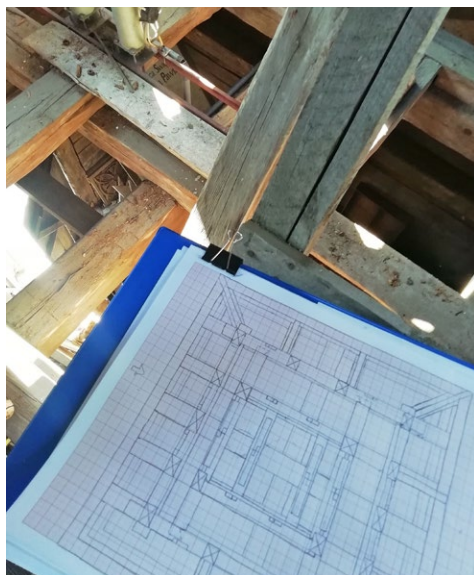
Pomiar konstrukcji drewnianej wykonany metodami tradycyjnymi
