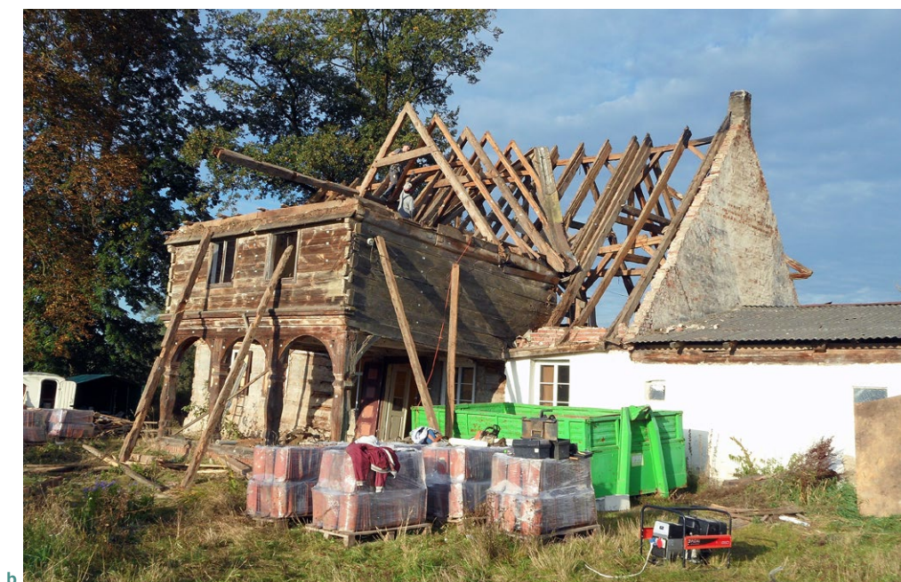
Etapy translokacji zagrody z Kaniczek na teren Olęderskiego Parku Etnograficznego w Wielkiej Nieszawce koło Torunia: przed translokacją (a), w trakcie demontażu (b), montaż w skansenie (c), po zakończeniu procesu translokacji i remontu (d)
