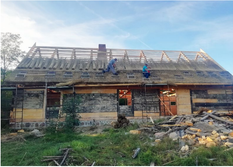
Montaż konstrukcji i pokrycia dachu
