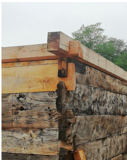
Odtworzenie zniszczonych bierwion ściany wieńcowej
