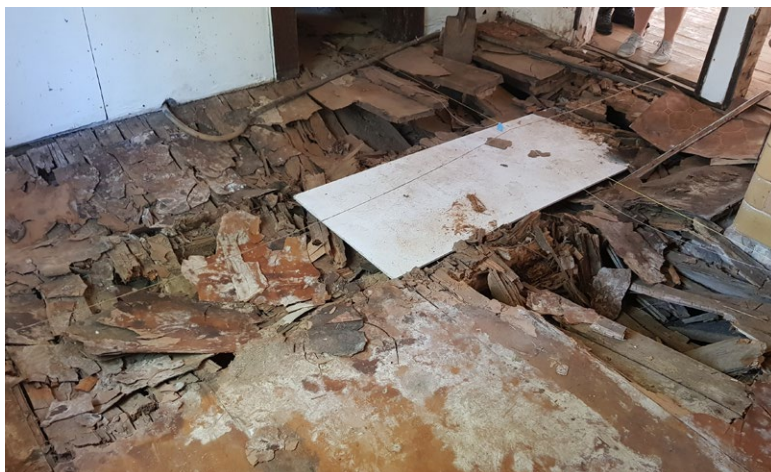
Wnętrze budynku zniszczone przez grzyba domowego – strocza domowego ( Serpula lacrymans )
