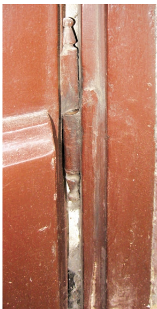
Kraków, Dom Jana Matejki. Zdeformowany zawias w bramie wejściowej. Fot. K. Czepiel, 2009
