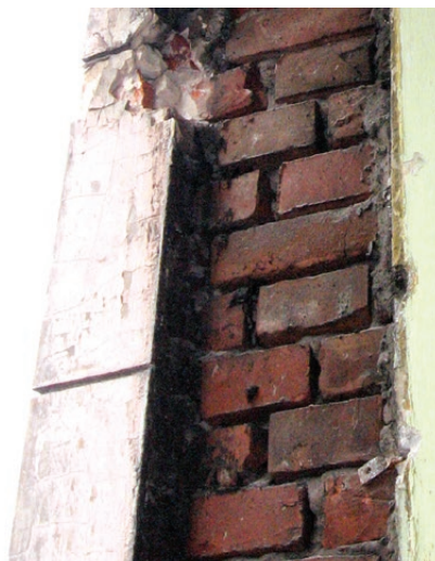
Kraków, kamienica przy ul. Siennej 7. Fragment ościeża otworu okiennego po wymontowaniu okna skrzynkowego. Na zdjęciu widoczny pozostawiony hak po wymontowaniu okna oraz otwór po wymontowanym haku. Fot. K. Czepiel
