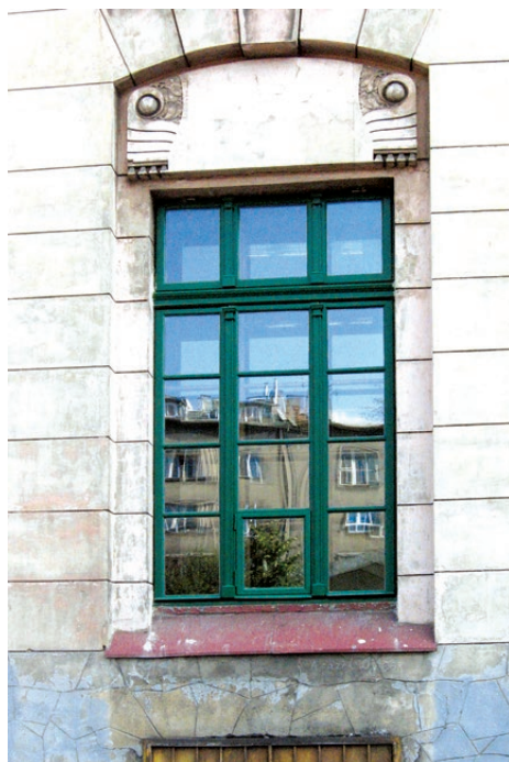
Okno odtworzone, zmodernizowane. Fot. K. Czepiel, 2012
