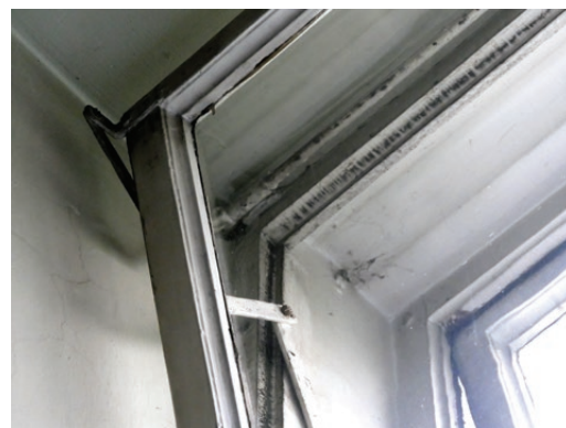
Kraków, budynek Polskiej Akademii Umiejętności przy ul. Sławkowskiej 17. Na zdjęciu widoczne wyżłobione nadproże ościeżnicy mające pomieścić wałek rolety. Fot. D. Rozbicka, 2018
