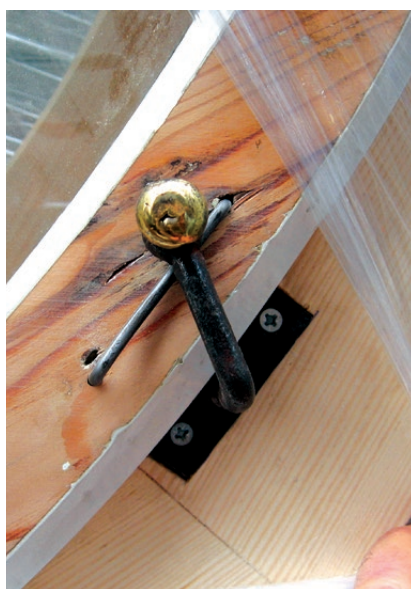
Kraków, Muzeum Księżąt Czartoryskich, Klasztor. Okna z mniej więcej 1870 roku. Na zdjęciu widoczne fleki uzupełniające powierzchniowe ubytki ramiaków skrzydeł okiennych. Fot. K. Czepiel, 2010
