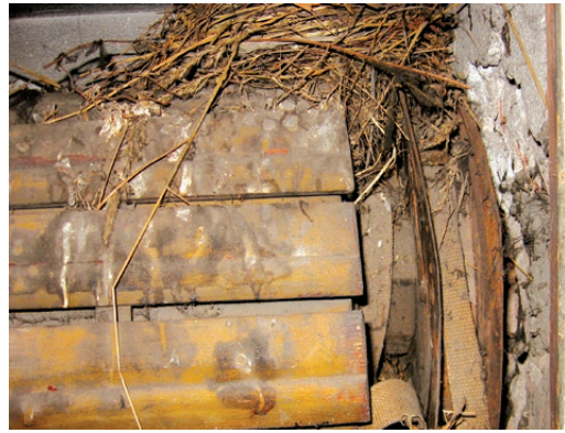
Siersza (Małopolska), willa dyrektora kopalni z 1910 roku. Zwinięta żaluzja we wnęce, po prawej widoczne nawinięta sprężyna i parciana taśma. Fot. K. Czepiel, 2012
