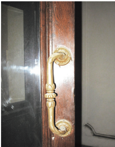
Radziszów, dwór Dzieduszyckich. Fornirowana drewnem orzechowym i politurowana ościeżyna drzwiowa. Stan przed konserwacją. Fot. T. Murzyn, 2011
