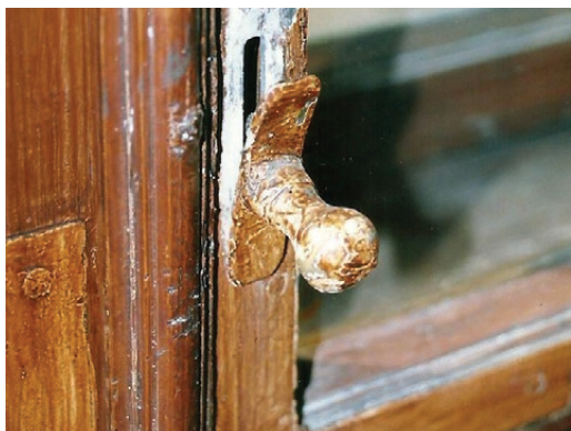
Kraków, pałac Wielopolskich. Zasuwka w oknach wykonanych w latach 1864–1865. Fot. K. Czepiel, 2009
