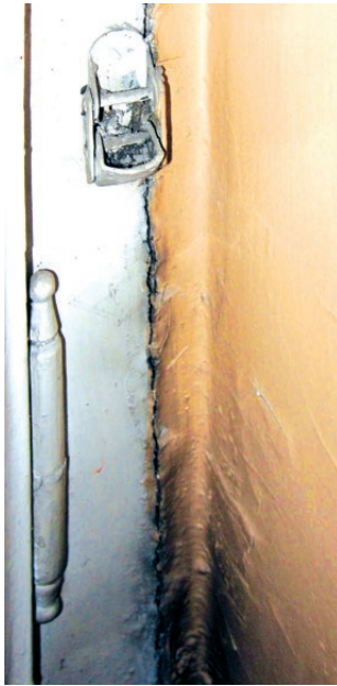
Siersza, willa dyrektora kopalni z 1910 roku. Uchwyt blokujący przesuwanie parcianej taśmy żaluzji listewkowej. Fot. K. Czepiel, 2012
