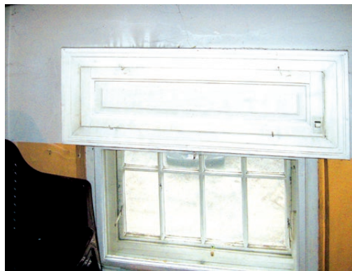
Kraków, ul. Botaniczna 3, willa profesora Piltza. Żaluzja przeciwsloneczna po konserwacji. Fot. K. Czepiel, 2014
