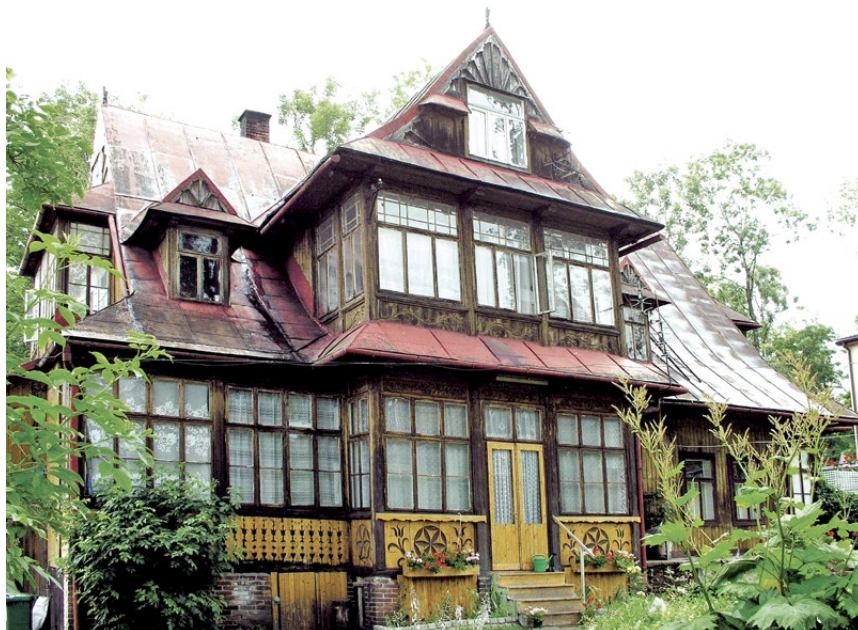
Zakopane, ul. Sienkiewicza. Drewniana willa z zachowaną historyczną stolarką okienną, niemal całkowicie wypełniającą elewację budynku, a tym samym kształtującą wygląd budowli. Fot. N. Skiepmo, 2021
