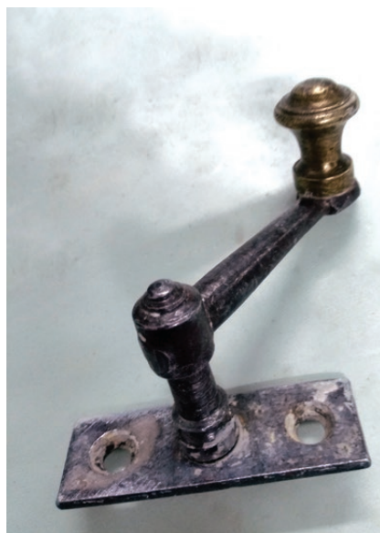
Kraków, budynek Akademii Sztuk Pięknych przy ul. Smoleńsk 9. Oryginalna (z 1914 roku) niesymetryczna zakrętka okienna przed usunięciem przemalowań oraz po ich usunięciu i odstonięciu pierwotnego koloru. Fot. K. Czepiel, 2016
