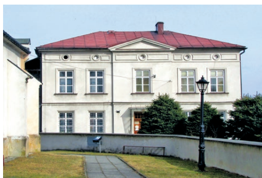
Fasada plebanii w Pobiedrze (Paszkówce) dobrze obrazuje zamiłowanie twórców dojrzałego historyzmu do naśladowania form z przeszłości, z zaakcentowaniem symetrii układu całej ściany i wyraźnym zaznaczeniem jej głównej osi. Harmonię całości doskonale podkreśla stolarka okienna o powtarzalnych, gęstych podziałach okien na mniejsze kwatery. Fot. A. Laskowski, 2011
