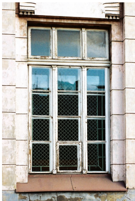
Okno oryginalne. Fot. K. Czepiel, 2008
