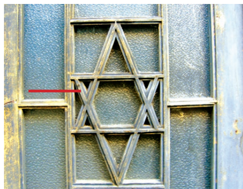
Kraków, ul. Grodzka 28/30, synagoga Tignera, lata 20. XX wieku. Modernistyczne drzwi z szybami ornamentowy- mi osadzonymi na listewkach. Fot. K. Czepiel
