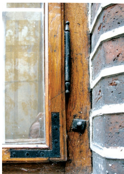
Kraków, Muzeum Księżąt Czartoryskich, Klasztor. Okna z mniej więcej 1870 roku. Na zdjęciu widoczne fleki uzupełniające powierzchniowe ubytki ramiaków skrzydeł okiennych. Fot. K. Czepiel, 2010
