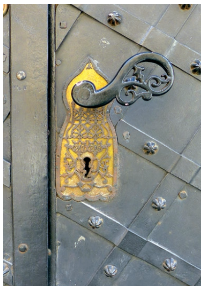
Kraków, kamienica przy ul. Kanoniczej. Neogotycka klamka z tarczką mosiężną pokrytą pozłotą (rekonstrukcja). Fot. K. Czepiel, 2018
