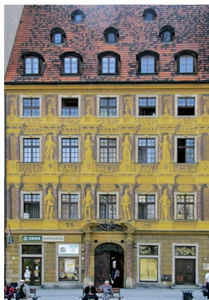
Dyscyplina w komponowaniu fasad, w której kluczową rolę odgrywały otwory okienne (umieszczone także w strefie dachu), obowiązywała również w kreacjach barokowych, czego doskonałym przykładem jest kamienica Pod Siedmioma Elektorami, jedna z najstarszych przy wrocławskim rynku (nr 8), o fasadzie przebudowanej w 2. połowie XVII wieku (a po części i później). Fot. A. Laskowski, 2011
