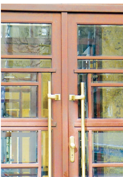
Kraków, ul. Dominikańska 1. Okno w elewacji podwórzowej po pożarze w roku 1850. Uwagę zwraca nierówna, migotliwa powierzchnia szklanych tafli. Fot. K. Czepiel, 2010
