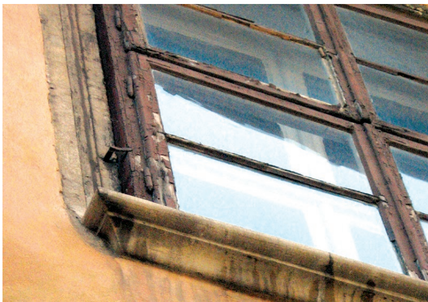
Kraków, dwór kanoników przy ul. Poselskiej 7. Hak do mocowania do kamiennych węgarów okien krosnowych zdwojonych. Fot. K. Czepiel, 2014
