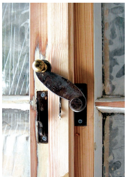
Kraków, Muzeum Księżąt Czartoryskich, Klasztor. Okna z mniej więcej 1870 roku. Na zdjęciu widoczne fleki uzupełniające powierzchniowe ubytki ramiaków skrzydeł okiennych. Fot. K. Czepiel, 2010
