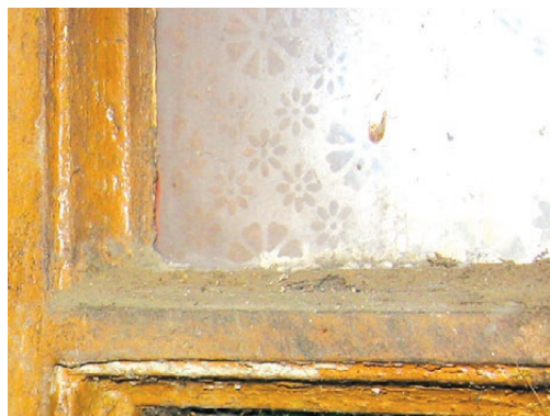
Kraków, kamienica przy ul. Karmelickiej 11. Matowione wzorzyste szyby w oknie z końca XIX wieku. Fot. K. Czepiel, 2010
