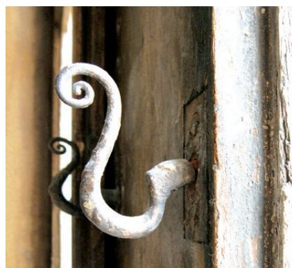
Kraków, Sukiennice, zakrętka okienna z 1870 roku. Okucia projektowane przez architekta Tomasza Prylińskiego. Fot. K. Czepiel, 2008
