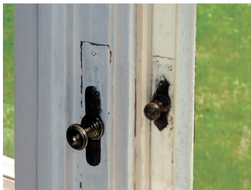
Kraków, pałac Pusłowskich. Zasuwka w oknach wykonanych w 4. ćwierci XIX wieku. Fot. K. Czepiel, 2018
