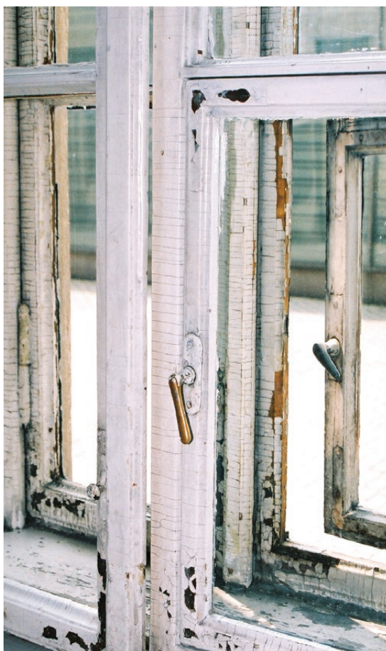
Kraków, ul. Wąska 3/5, okna przed konserwacją. Fot. K. Czepiel, 2006
