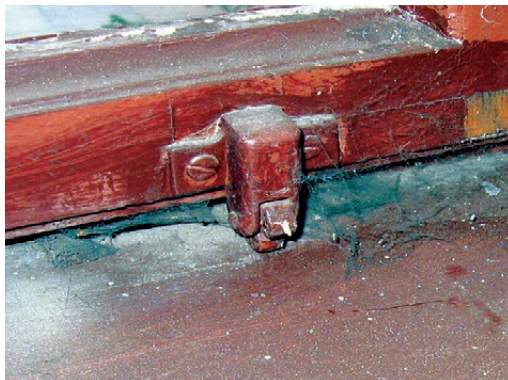
Kraków, budynek urzędu miasta. Zaczepek przeciwwiatrowy w oknach wykonanych w latach 1907–1914. Fot. K. Czepiel, 2009
