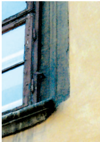
Kraków, dwór kanoników przy ul. Poselskiej 7. Okno krosnowe zdwojone wbudowane do kamiennych węgarzków za pomocą haków zakutych wiórami łożnianymi – zbliżenie na hak. Fot. K. Czepiel, 2014
