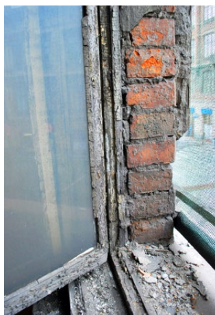
Kraków, okna w kamienicy przy ul. Dietla 44. Fot. B. Gostyńska, 2013
