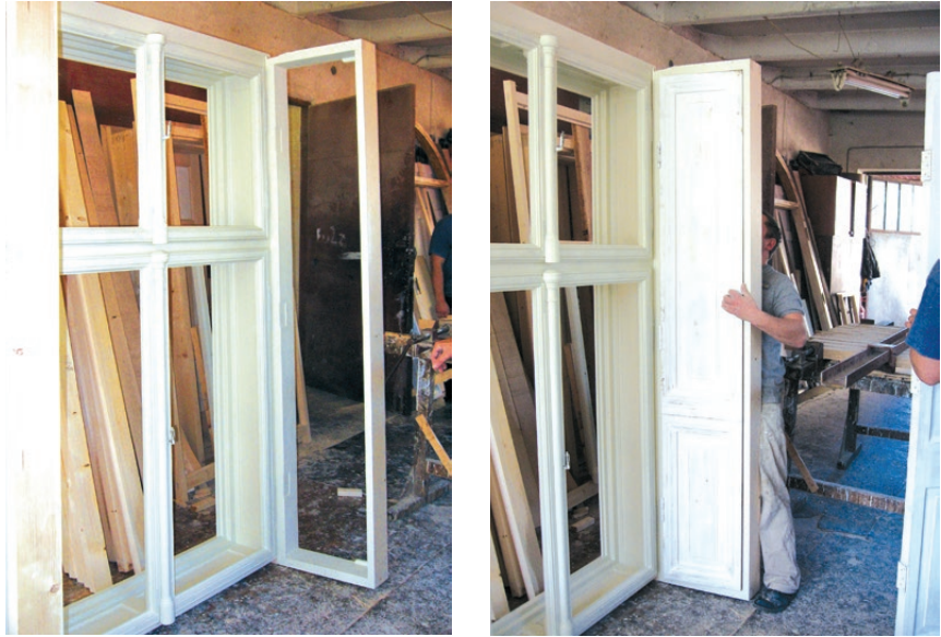
Krzywaczka, dwór z początku XIX wieku. Okno z okiennicami z końca XIX wieku w czasie restauracji – widok od strony wnętrza. Z lewej widoczna zamontowana rama do zawieszenia skrzydeł okiennicy, z prawej zawieszanie skrzydeł w ramie. Fot. K. Czepiel, 2009
