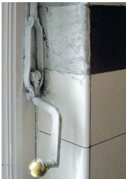
Po lewej: Kraków, budynek Biblioteki Jagiellońskiej z okresu międzywojennego. Uchwyt ciężła rozwórki. Fot. K. Czepiel, 2017
