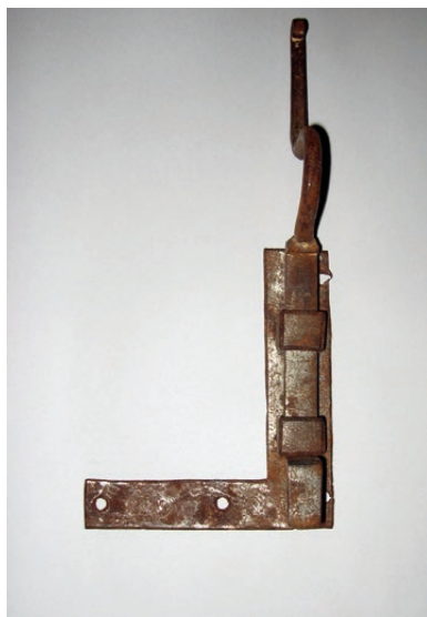
Dwór w Krzywaczce. Stalowa zasuwa okienna z początku XIX wieku. Widoczne resztki pobiły cynowo-ołowiowej. Fot. K. Czepiel
