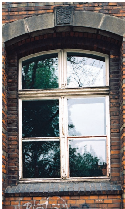
Okno oryginalne. Fot. K. Czepiel, 2006
