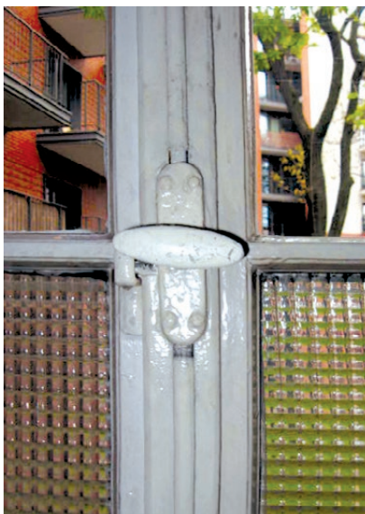
Kraków, pałac Przeworskich przy ul. Warszawskiej 17. Zasuwa okienna z początku XX wieku. Fot. K. Czepiel
