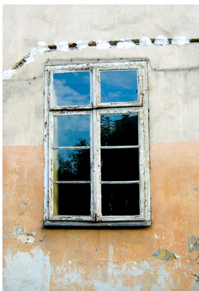
Kraków, ul. Dominikańska 1. Okno w elewacji podwórzowej po pożarze w roku 1850. Uwagę zwraca nierówna, migotliwa powierzchnia szklanych tafli. Fot. K. Czepiel, 2010
