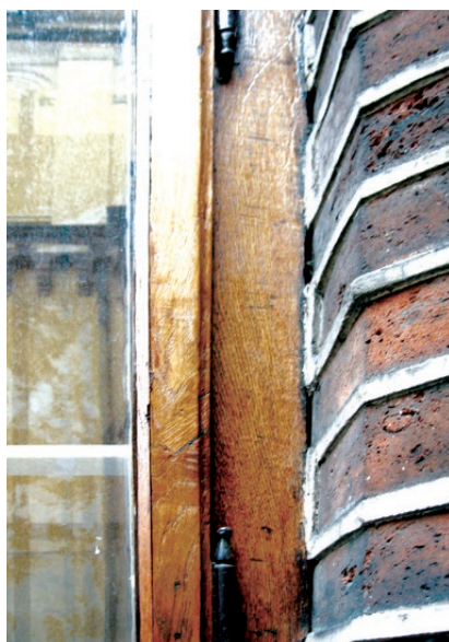
Kraków, Muzeum Księżąt Czartoryskich, Klasztor. Okna z mniej więcej 1870 roku. Na zdjęciu widoczne fleki uzupełniające powierzchniowe ubytki ramiaków skrzydeł okiennych. Fot. K. Czepiel, 2010
