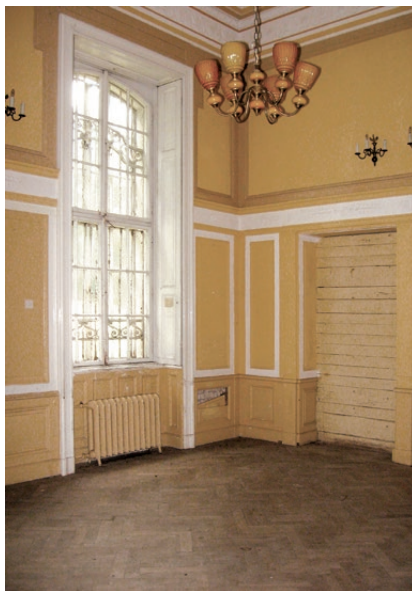
Brzesko-Okocim, pałac Goetzów. Okno ościeżnicowe z wewnętrznymi okiennicami schowanymi. Fot. K. Czepiel, 2008
