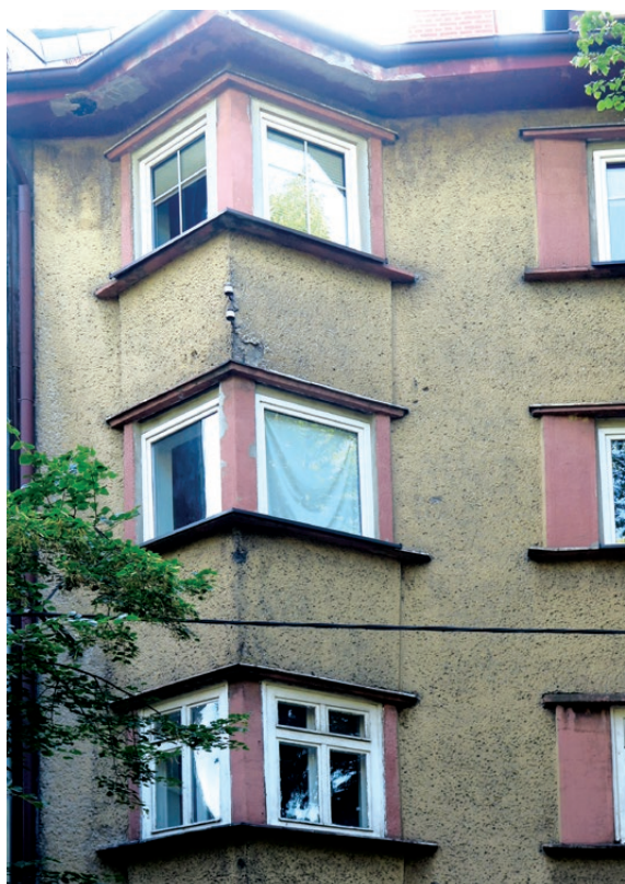
Bytom, plac Akademicki. Trzy różne wypełnienia analogicznych otworów okiennych w obrębie jednego wykuszu. Przykład ilustrujący, jak łatwo harmonia pierwotnej kompozycji elewacji ulega zatarciu w wyniku zmiany pojedynczego elementu. Fot. A. Olczyk, D. Bajowska, 2019
