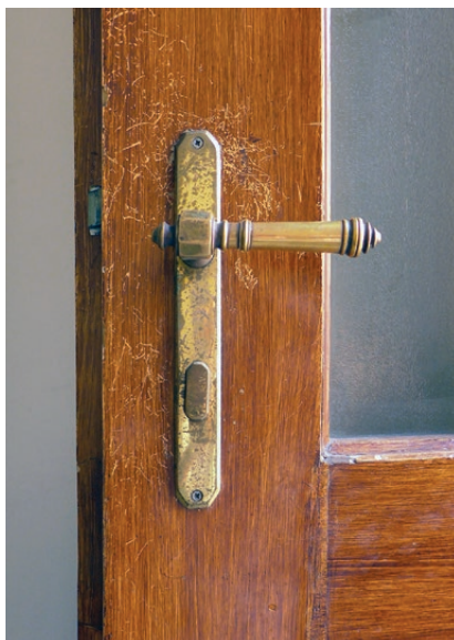
Kraków, pałac Pusłowskich. Klamka z 4. ćwierci XIX wieku, wykonana z brązu pokrytego pozłotą. Fot. K. Czepiel, 2018
