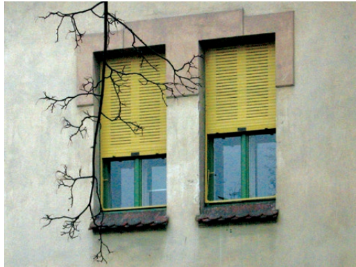
Siersza (Małopolska), willa dyrektora kopalni z 1910 roku. Zwinięta żaluzja we wnęce, po prawej widoczne nawinięta sprężyna i parciana taśma. Fot. K. Czepiel, 2012
