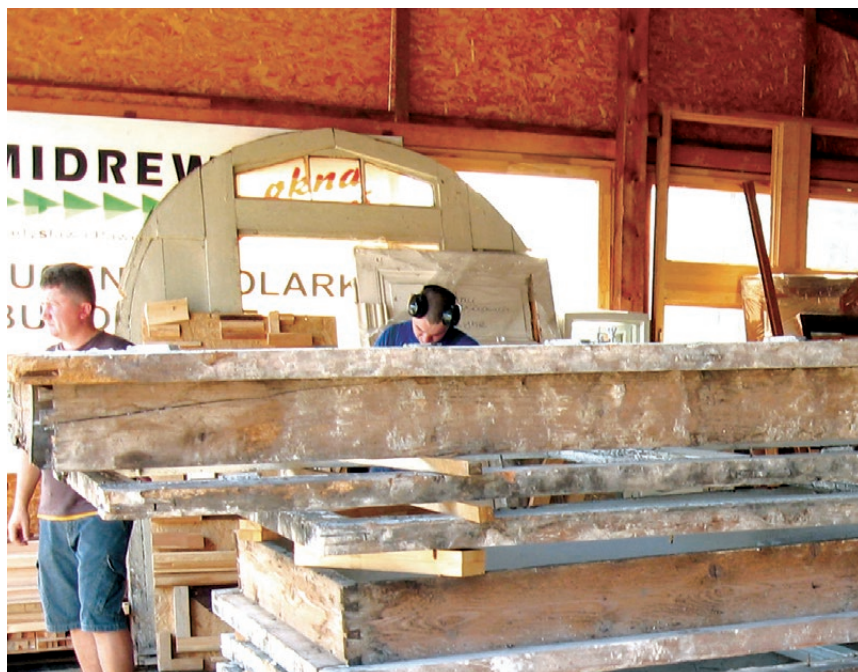
Zabytkowe okna z budynku szkoły przy ul. św. Marka 34 w Krakowie po wymontowaniu i zmagazynowaniu w pracowni. Fot. K. Czepiel
