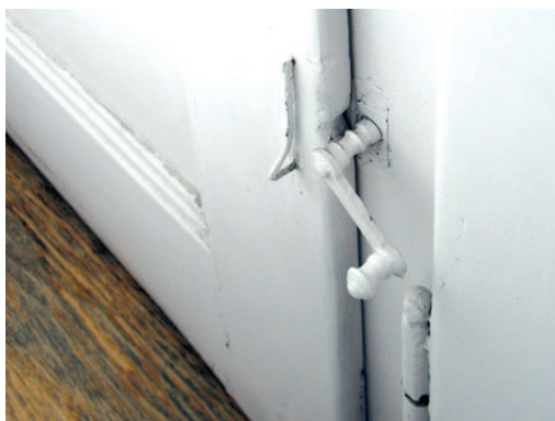
Kraków, budynek Akademii Sztuk Pięknych przy ul. Smoleńsk 9. Oryginalna (z 1914 roku) niesymetryczna zakrętka okienna przed usunięciem przemalowań oraz po ich usunięciu i odstonięciu pierwotnego koloru. Fot. K. Czepiel, 2016
