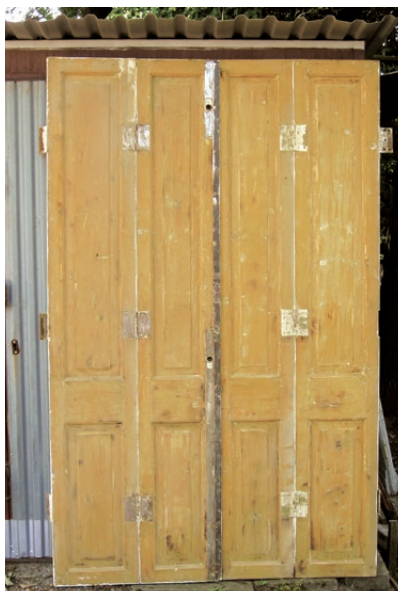
Krzywaczka, dwór z początku XIX wieku. Okno z okiennicami z końca XIX wieku. Awers (z lewej) i rewers (z prawej) okiennic w trakcie konserwacji. Fot. K. Czepiel, 2008
