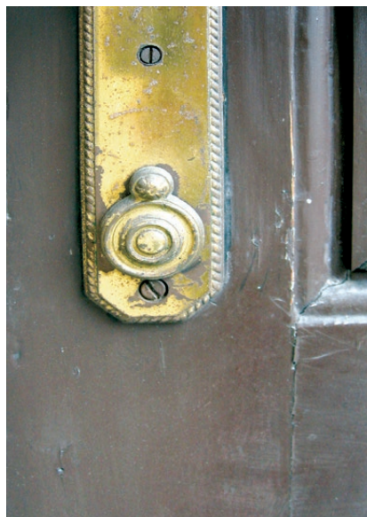
Kraków, kamienica przy ul. Kanoniczej. Neogotycka klamka z tarczką mosiężną pokrytą pozłotą (rekonstrukcja). Fot. K. Czepiel, 2018
