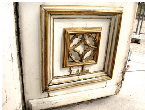
Kraków, Celestat. Drzwi wejściowe z filunkami obramowanymi złożonymi listwami profilowanymi. Fot. K. Czepiel, 2012
