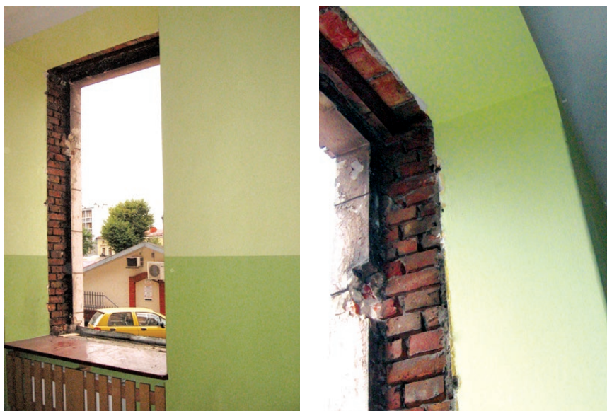
Otwór w murze po wymontowaniu okna skrzynkowego. Fot. K. Czepiel
