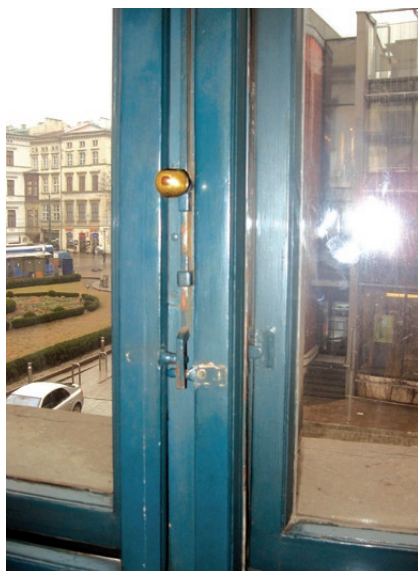
Kraków, pałac Wielopolskich. Zasuwa w oknach wykonanych w latach 1864–1865. Fot. K. Czepiel, 2009
