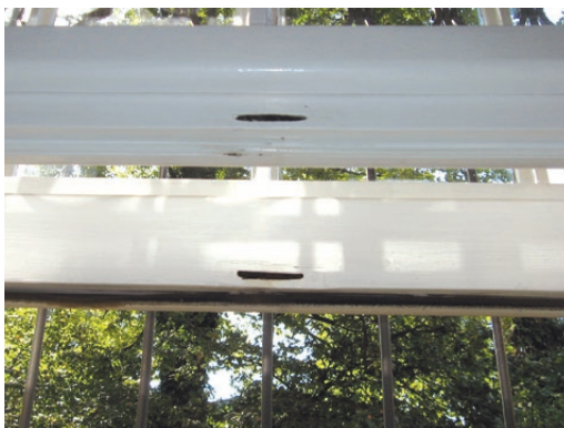
Kraków, Dom Józefa Mehoffera (oddział Muzeum Narodowego) z 2. połowy XIX wieku. Gniazdo zaczepów haka zawrotnicy w ślemieniu. Fot. K. Czepiel, 2016
