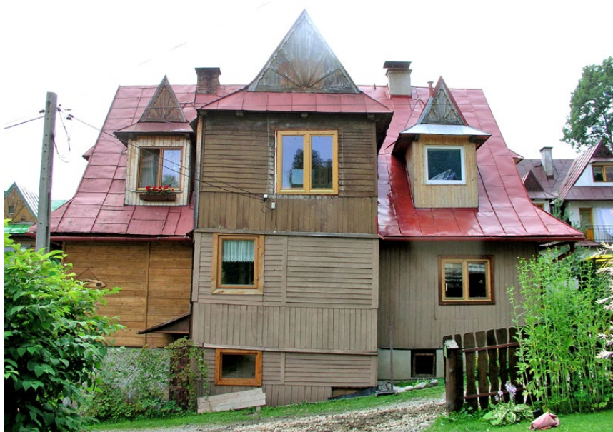
Zakopane, ul. Tatarsy. Drewniana willa z wymienioną stolarką okienną zakomponowaną w obrębie przebudowanej elewacji. Fot. N. Skiepmo, 2018
