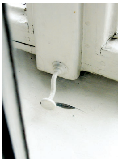
Kraków, budynek Akademii Sztuk Pięknych przy ul. Smoleńsk 9. Odbojnik wbudowany na listwie przyrymkowej prawego skrzydła. Fot. K. Czepiel, 2016
