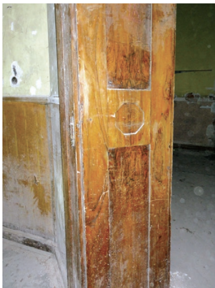
Radziszów, dwór Dzieduszyckich. Fornirowana drewnem orzechowym i politurowana ościeżyna drzwiowa. Stan przed konserwacją. Fot. T. Murzyn, 2011
