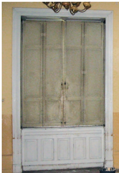
Brzesko-Okocim, pałac Goetzów. Okno ościeżnicowe z wewnętrznymi okiennicami otwartymi. Fot. K. Czepiel, 2008
