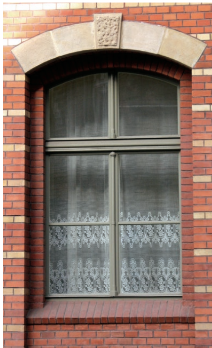
Okno odtworzone, zmodernizowane. Fot. K. Czepiel, 2008
