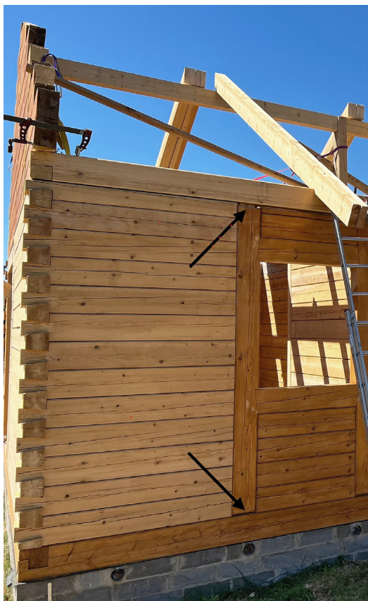
Il. 14. Ściana z pozostawioną szczeliną na zleg, fot. C. Romanowski
