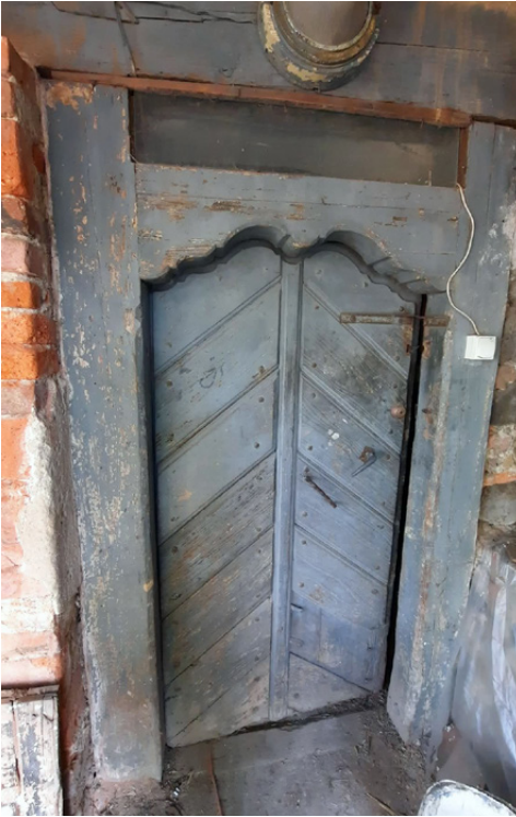
Dom Chlebowy w Bogatyni w trakcie renowacji stolarki z użyciem tradycyjnej farby z oleju lnianego. Drzwi zewnętrzne przed renowacją. Wykonawca: Stolarnia Okna, Drzwi, Schody w Mirsku
