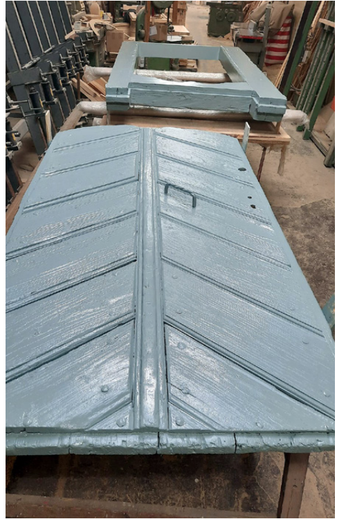
Drzwi zewnętrzne Domu Chlebowego w Bogatyni w trakcie renowacji. Wykonawca: Stolarnia Okna, Drzwi, Schody w Mirsku
