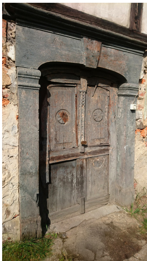
Portal drzwiowy Domu Chlebowego przy ul. Kościuszki 114 w Bogatyni
