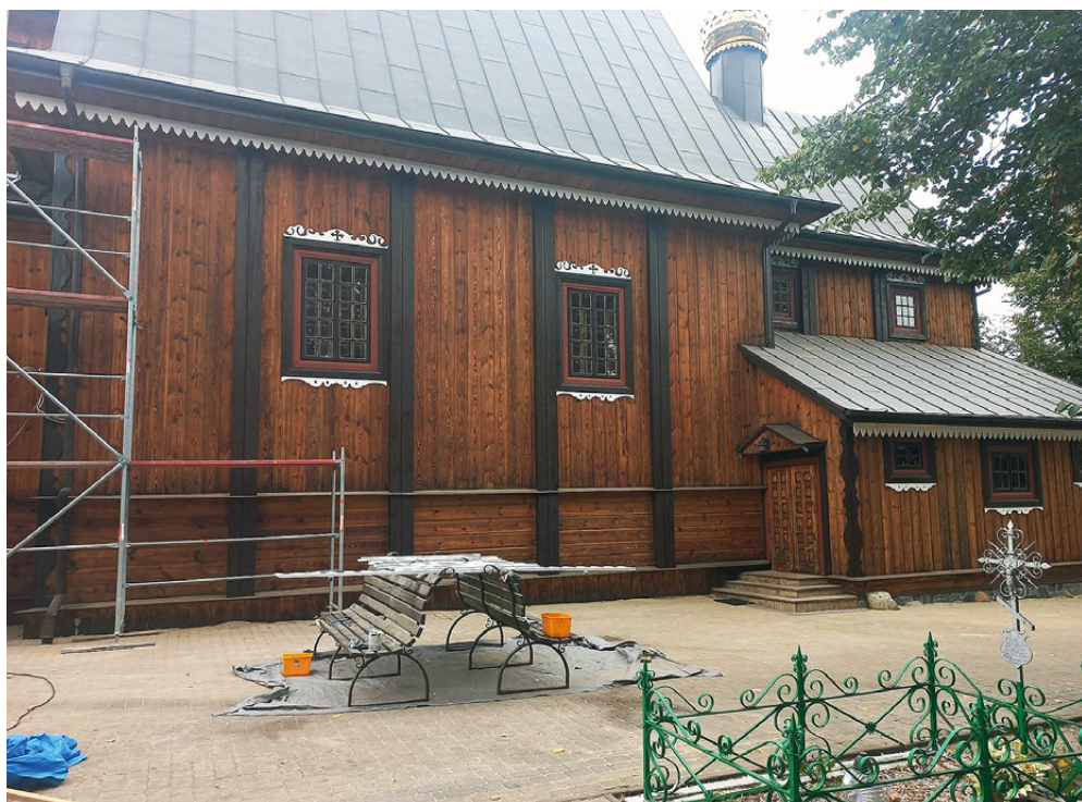
Cerkiew pw. Narodzenia NMP w Bielsku Podlaskim po renowacji. Elewacja po oczyszczeniu została zabezpieczona olejem smołowym oraz farbami z oleju lnianego
